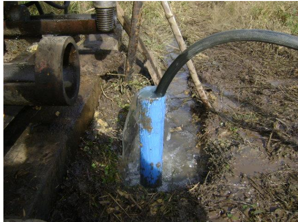
Figura 5.23 - Modelo da conformação final dos poços de monitoramento contendo as devidas proteções sanitárias e tubos de vedação.
