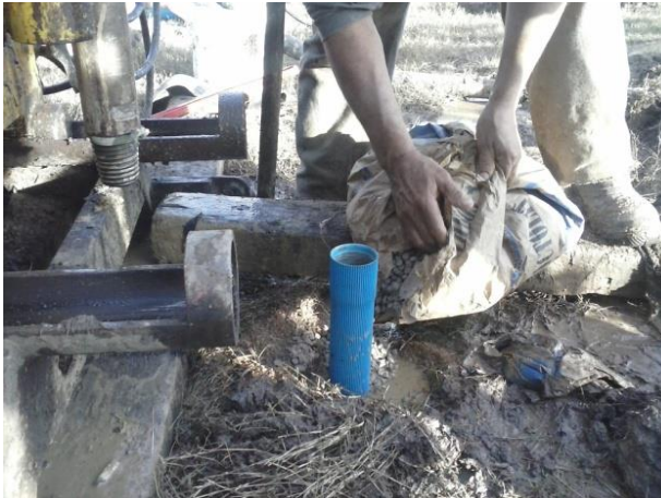
Figura 5.20 - Aplicação de brita junto ao filtro no PM01B.
