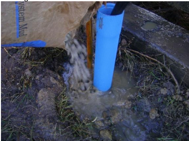
Figura 5.22 - Preenchimento final com sedimentos no poço de monitoramento PM04B para completar o espaço gerados da acomodação dos sedimentos após saturação com água.
