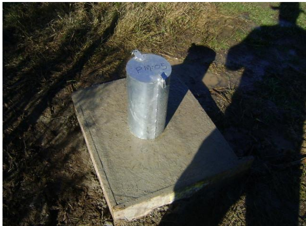
Figura 5.23 - Modelo da conformação final dos poços de monitoramento contendo as devidas proteções sanitárias e tubos de vedação.
