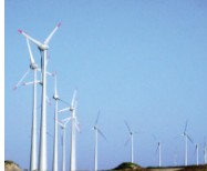
Usina Eólica Betim
