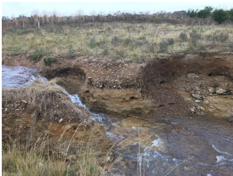
Figura 9: Destaque para os processos erosivos instalados próximo ao ladrão de uma pequena barragem de uma drenagem secundária que alimenta o rio Jaguarão e futuro reservatório, na antiga propriedade do Sr João Luiz Ozório da Silva. Esta erosão expõe aluviões e coluviões quaternários na região, com Latitude 31°28'37,3"; 53°48'58,3".
