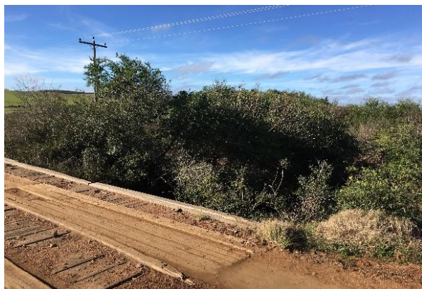
Figura 35: Estrada de Bagé, divisa de municípios.
