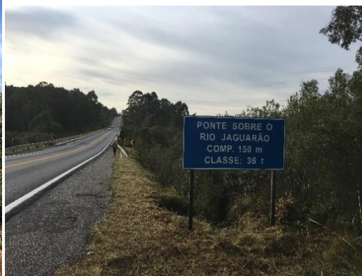
Figura 36: Rodovia BR 293, sobre o rio Jaguarão.
