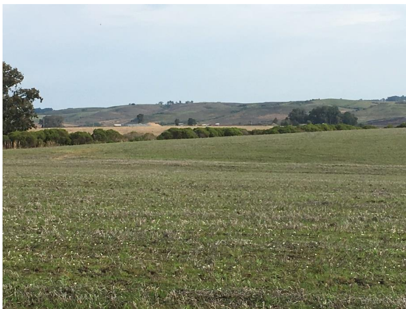
Figura 8: Obras do barramento ao fundo e destaque para a topografia plano-ondulada do entorno do futuro reservatório. Coordenadas Geográficas 31° 28' 42,64'' e 53° 48' 23,49''.
