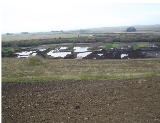
Figura 42: Vista de solo arado no entorno da APP e futuro reservatório J2, com destaque para jazidas de solo utilizadas para a construção da barragem de terra e que serão recuperadas antes do enchimento.
