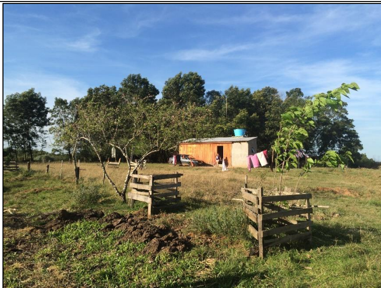
Foto 44: Edificação de madeira.
