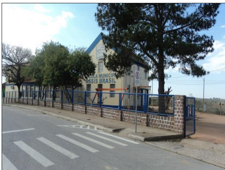
Foto 65: Sede da Escola Municipal de Ensino Fundamental Assis Brasil, localizada no perímetro urbano de Pedras Altas. Atualmente, divide infraestrutura com a Escola Estadual de Ensino Médio São Diogo.
