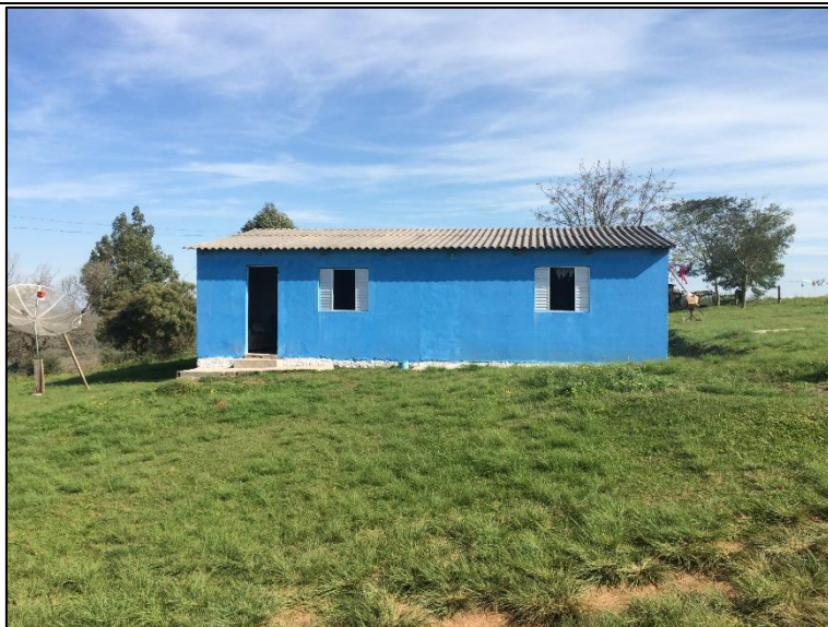
Foto 36: Edificação residencial de alvenaria.
