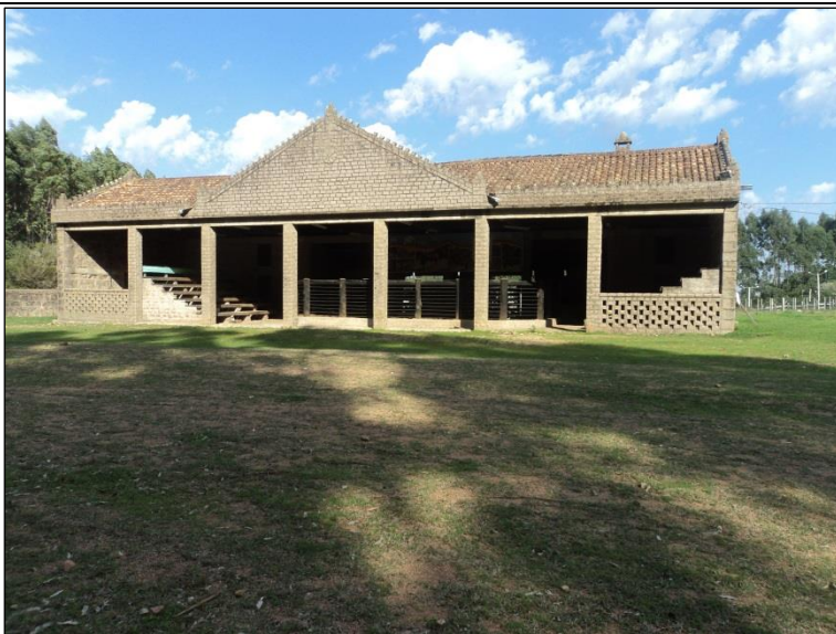
Foto 71: Edificação do Parque de Eventos Rurais, localizado na zona rural do distrito sede de Pedras Altas.
