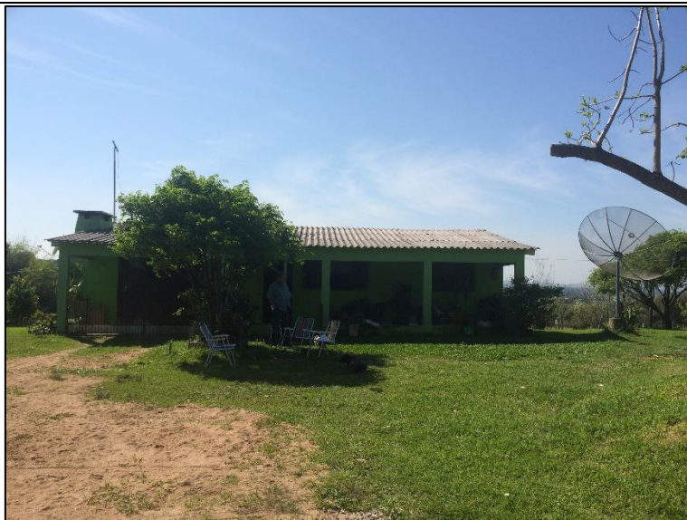
Foto 54: Edificação residencial de alvenaria.
