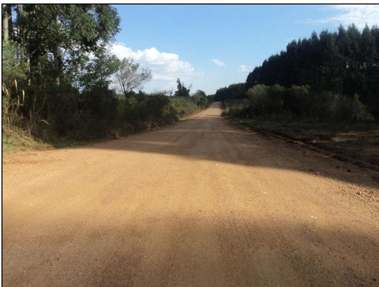
Foto 19: Situação da Estrada RS-608
