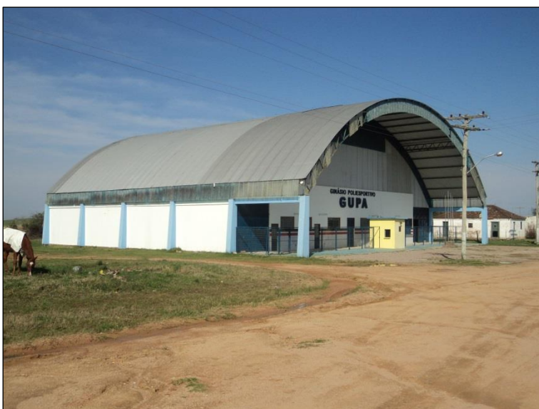
Foto 72: Ginásio Poliesportivo (GUPA), localizado no perímetro urbano de Pedras Altas.
