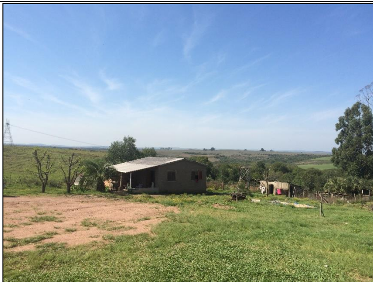
Foto 58: Casa 1 de alvenaria.
