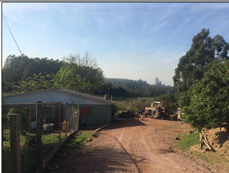
Foto 40: Edificação residencial de alvenaria.
