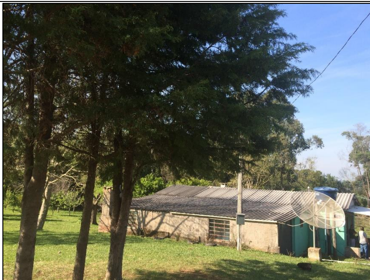
Foto 50: Edificação residencial de alvenaria.
