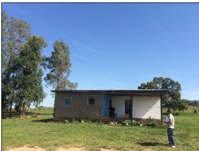
Foto 59: Casa 2 de alvenaria.
