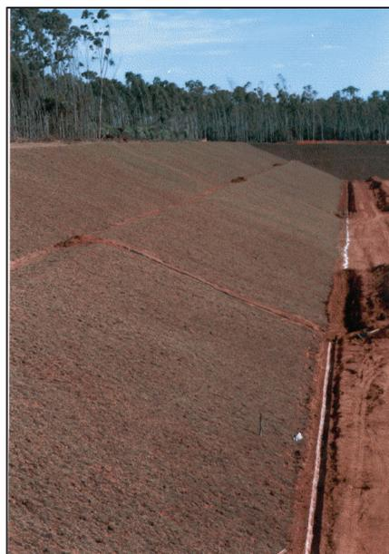
**Figura 2.5.6.4.5-3: Detalhe da abertura de vala para instalação da tubulação da rede de drenagem no topo do talude.**
