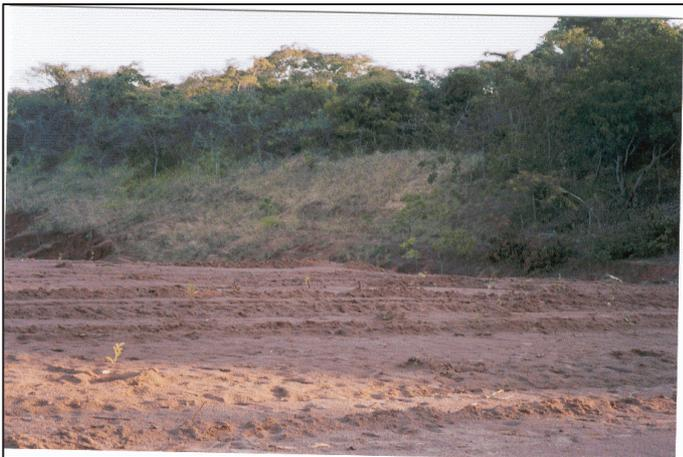
**Figura 2.5.6.4.1-2: Área do bota fora com a superfície preparada para receber a terra vegetal.**
