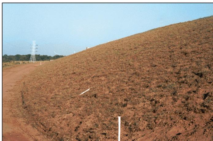
**Figura 2.5.6.4.5-4: Detalhe de um talude já revegetado.**
