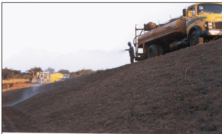
**Figura 2.5.6.4.5-54: Detalhe da irrigação sendo realizada em talude recém plantado.**
