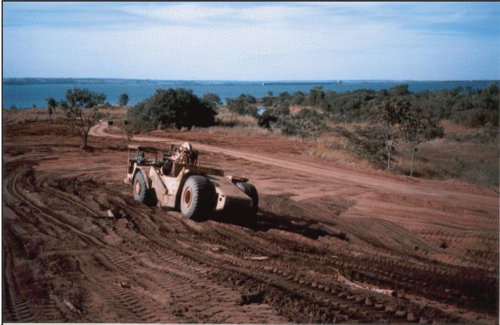
**Figura 2.5.6.4.1-4: Detalhe da operação de espalhe da terra vegetal na superfície do bota-fora.**
