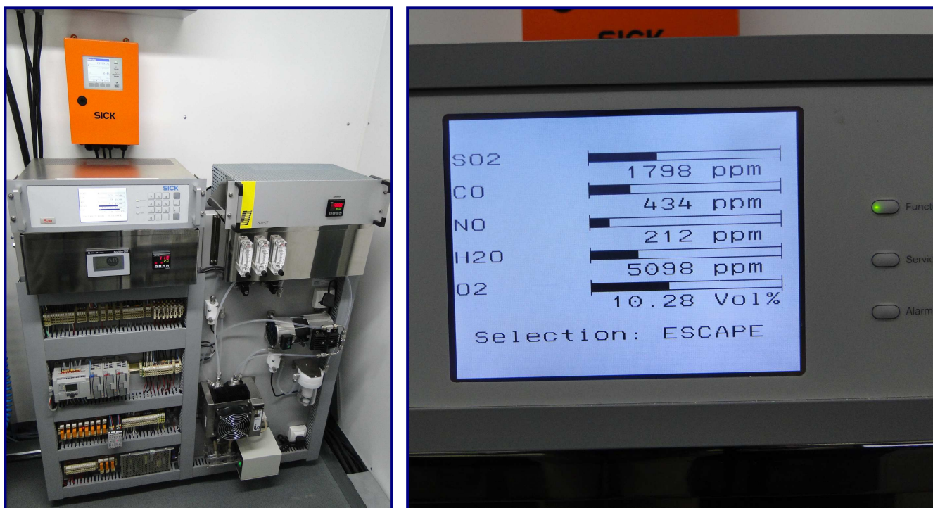
Figura 6 – Sistema de Condicionamento de Amostra e Análise de Gases com os Dados da Caldeira 2.
