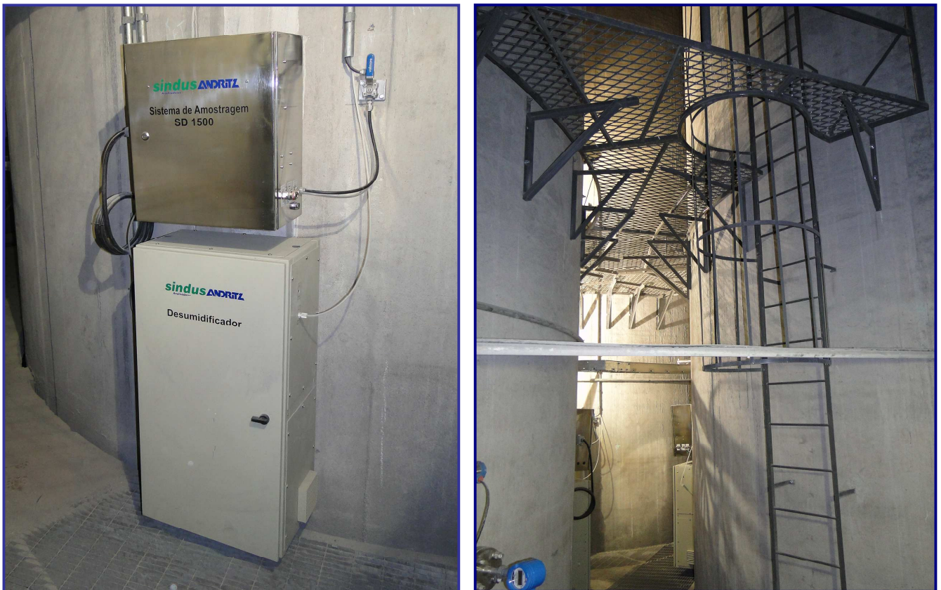
Figura 2 – Sistema de Amostragem SD 1500 e Infraestrutura Interna da Chaminé.
