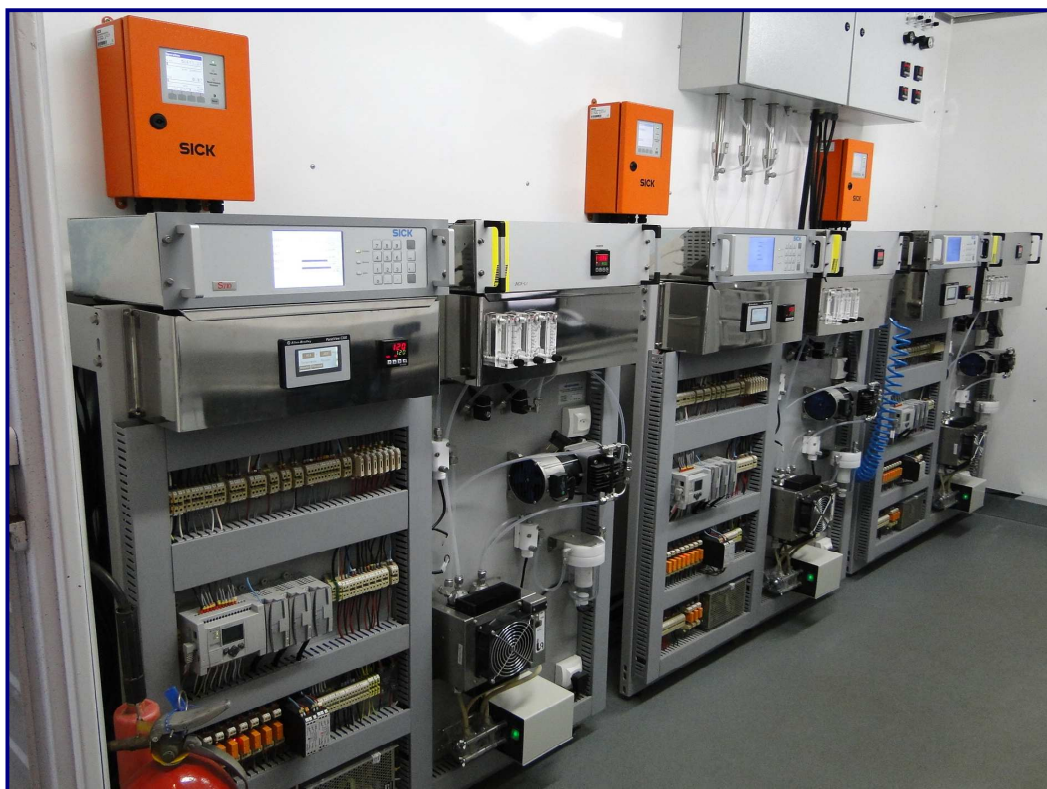
Figura 8 – Sistema de Análise de Gases Individuais para as Três Chaminés das Fases A e B.
