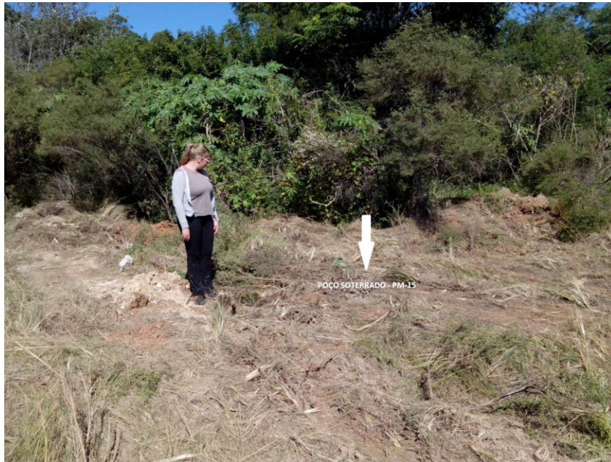
Figura 5. Fotografia mostrando o local onde estava instalado o poço PM-15, agora soterrado por obra de terraplenagem.
