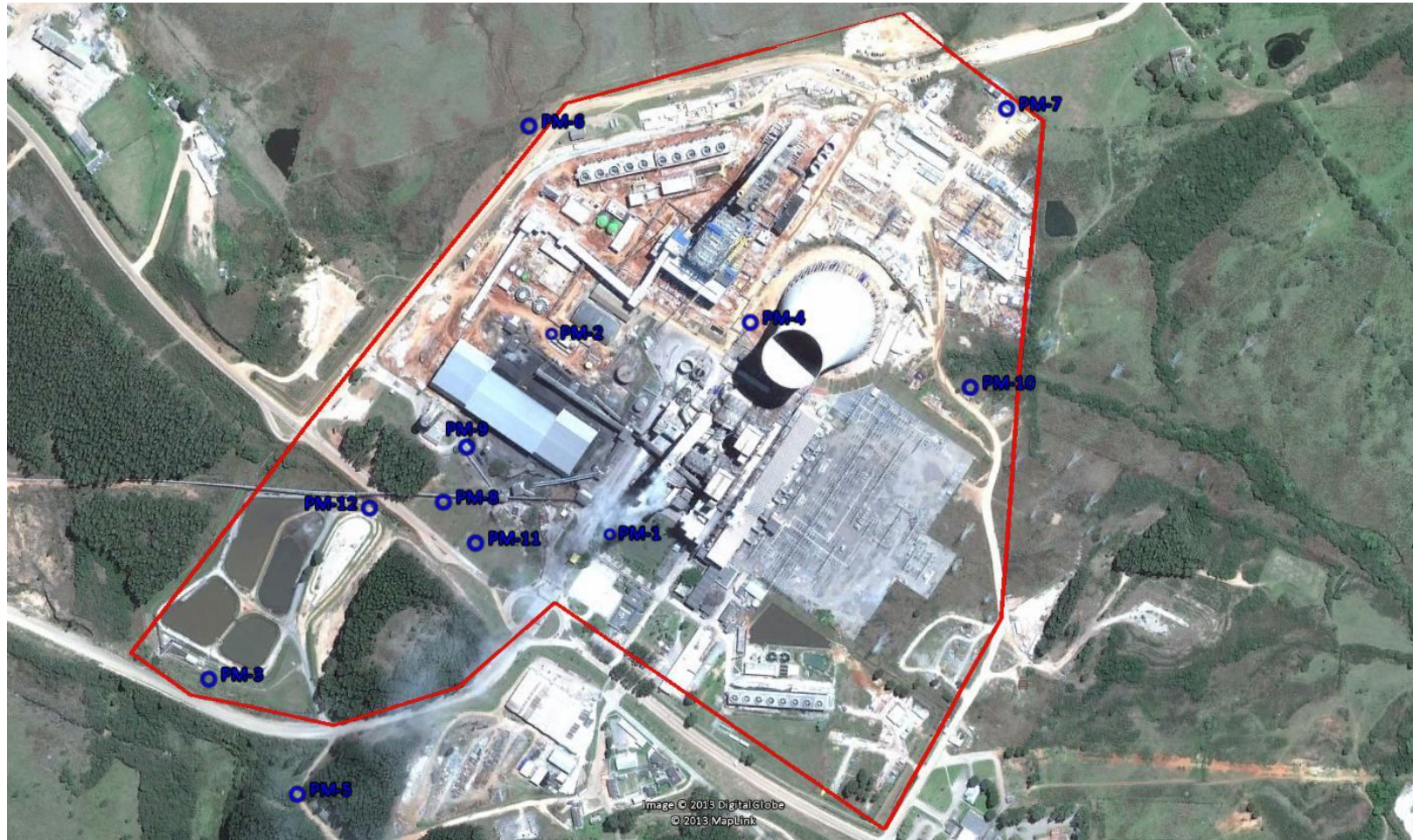
Figura 2. Localização dos poços de monitoramento na área da Usina – Fase B e Fase C.
