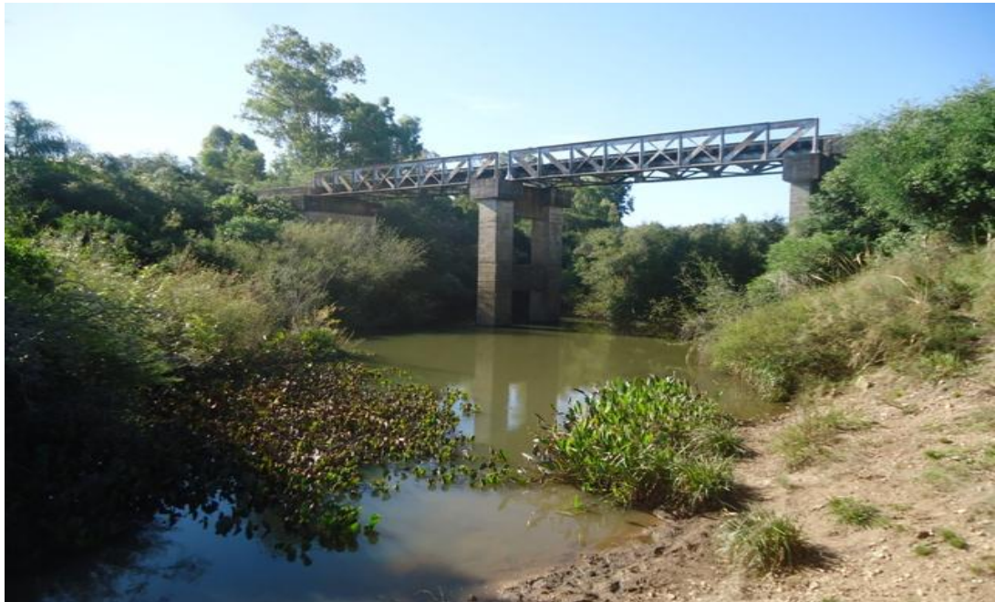
Figura 9.1. Imagem do PT1 da rede de monitoramento próximo a ponte férrea e a Br392, localizado à montante da barragem da UTPM no arroio Candiota.
