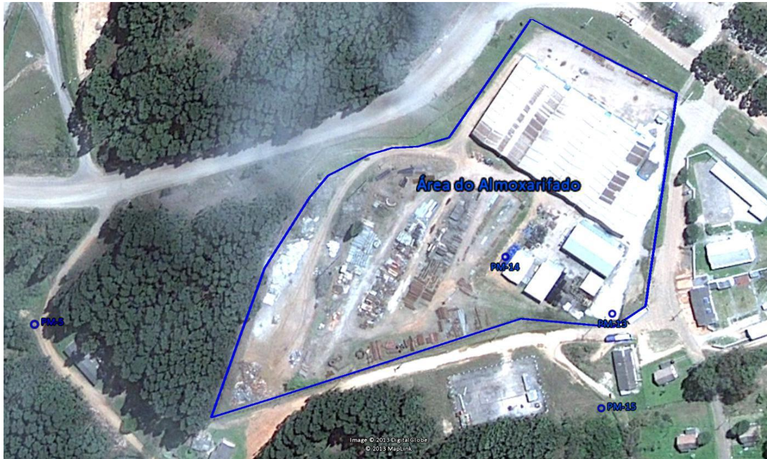
Figura 3. Localização dos poços de monitoramento da área do Almoarifado. O poço PM-15 foi soterrado por obras de terraplenagem realizadas no local num período entre a terceira e quarta coleta.
