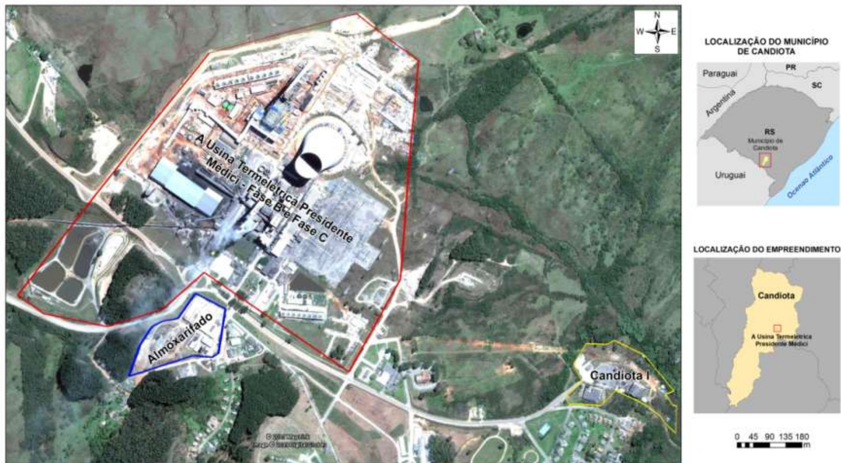
Figura 1. Localização das áreas monitoradas na Usina Termelétrica Presidente Médici: Área da Usina – Fase A e Fase B, Área do Almoxarifado e Área Candiota 1.
