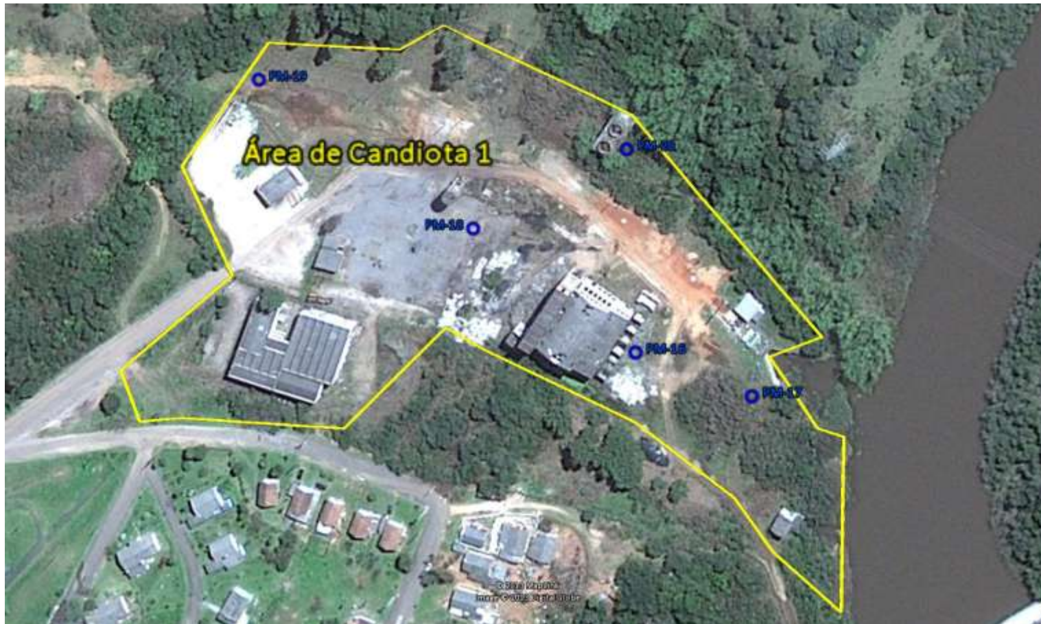
Figura 4. Localização dos poços de monitoramento da área de Candiotá 1. O poço PM-18 apresenta danos irreversíveis na sua estrutura causados por escavações nas suas imediações, inutilizando-o para amostragens.
