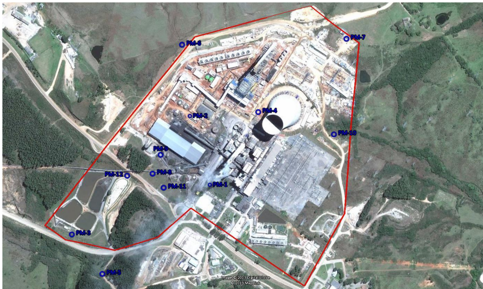
Localização dos poços de monitoramento na área da Usina – Fase B e Fase C.
