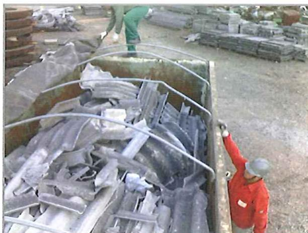
**Figura 1** – Carregamento de resíduos de Solo Contaminado e Telhas de Amianto.
