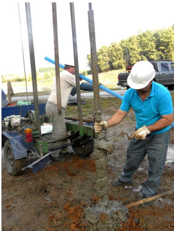
Figura 3. Trabalhos de instalação do Poço de monitoramento PM-12, a montante das lagoas de decantação.
