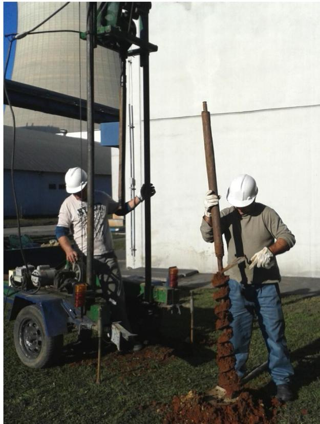
Figura 1. Trabalhos de instalação do Poço de monitoramento PM-2, na área Industrial.
