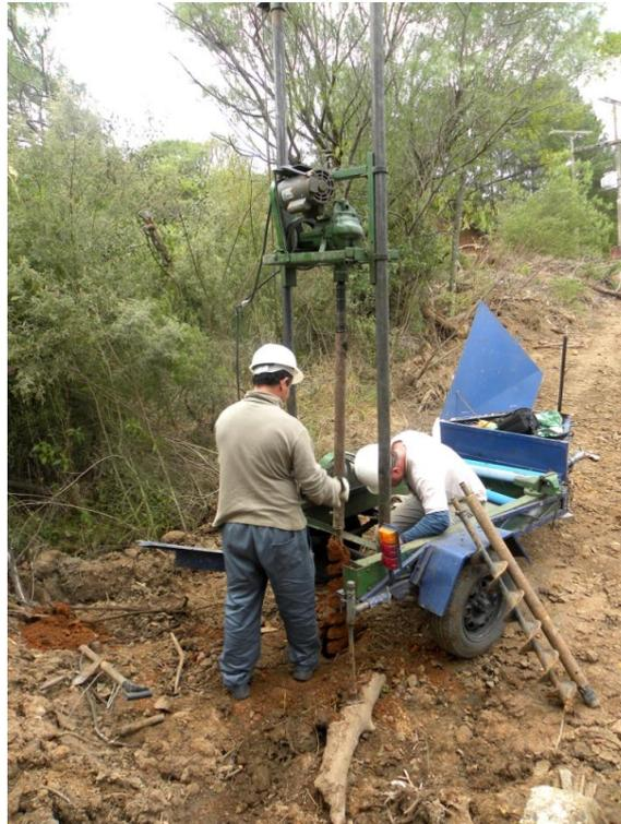
Figura 4. Trabalhos de instalação do Poço de monitoramento PM-17m na área de Candiota 1.
