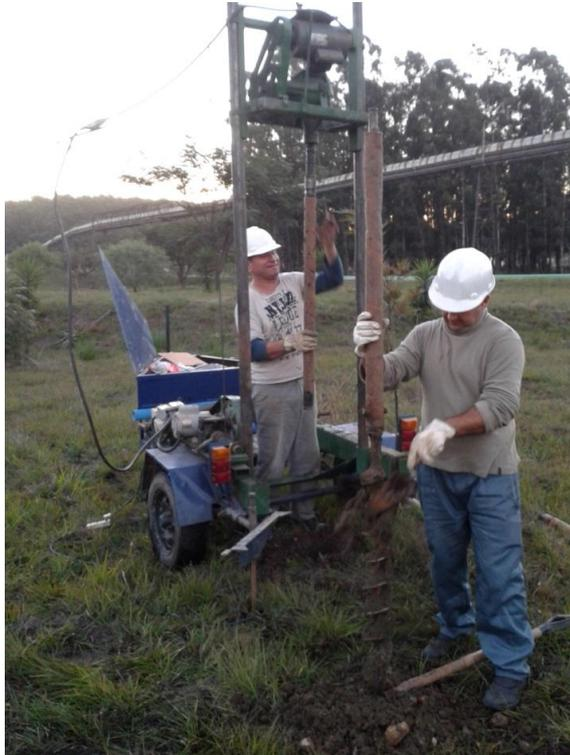
Figura 2. Trabalhos de instalação do Poço de monitoramento PM-11, a jusante do pátio de carvão.
