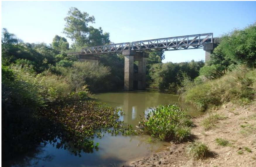
Figura 9.1. Imagem do PT1 da rede de monitoramento próximo a ponte férrea e a Br392, localizado à montante da barragem da UTPM no arroio Candiota.
