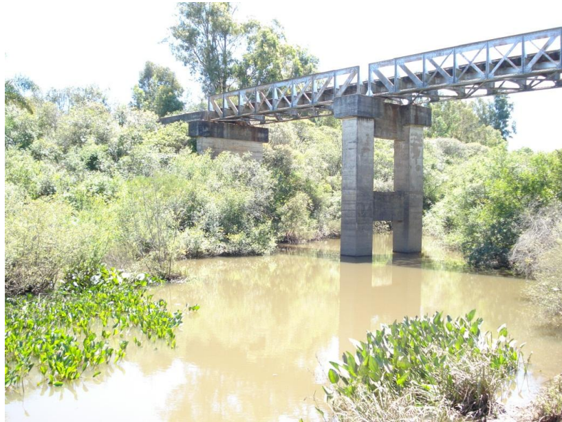
Figura 9.1. Imagem do PT1 da rede de monitoramento próximo a ponte férrea e a Br392, localizado à montante da barragem da UTPM no arroio Candiota.
