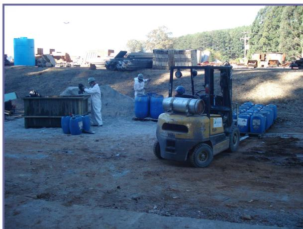
**Figura 3** – Solidificação de resíduos com cinzas de carvão mineral e toalha mecânica.
