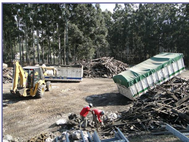
**Figura 12** – Segregação do isolamento térmico usado e madeira contaminada na área do Almojarifado.
