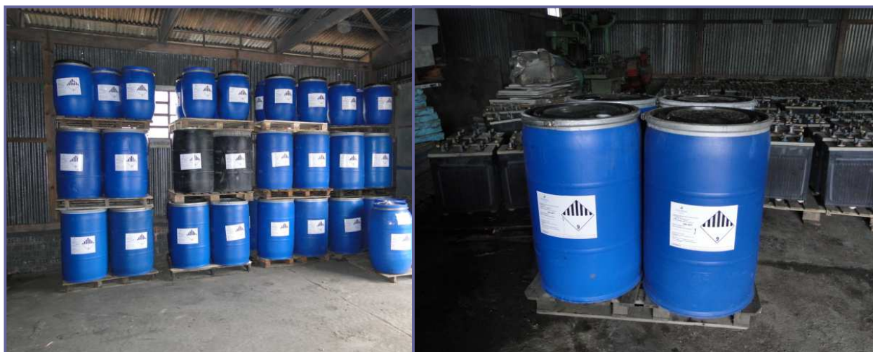
Figura 4 – Acondicionamento e armazenamento temporário de resíduos perigosos diversos.
