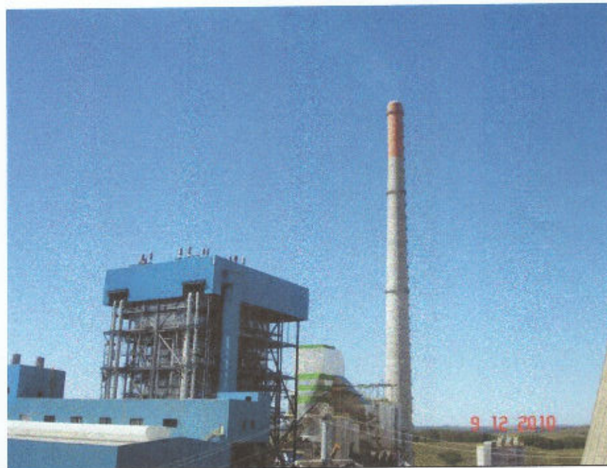
Figura 3 – Vista da chaminé – 210 MW
