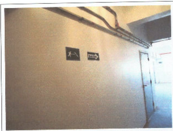
Foto 19 Acesso no Prédio de Controle sinalizado
