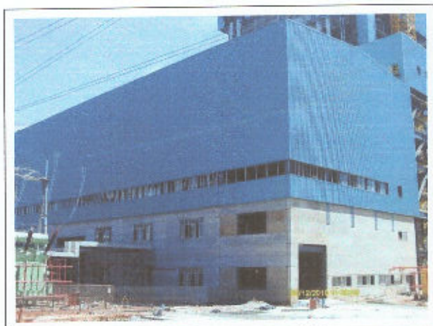
Foto 40 Casa da Turbina - fechamento concluído
