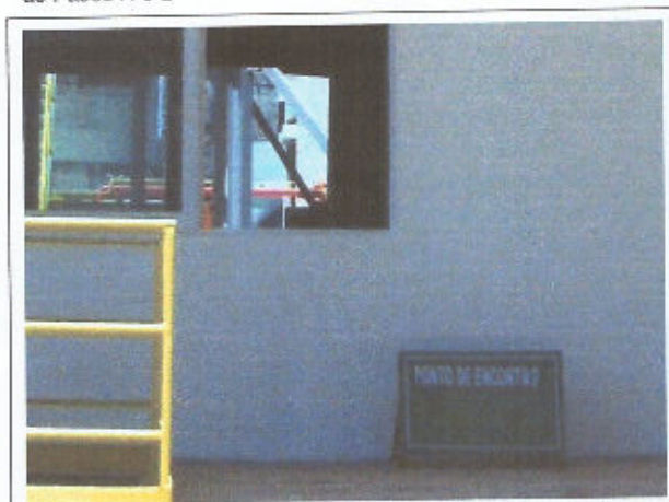
Foto 25 Ponto de Encontro no Prédio do Tratamento de Água da Cinza Pesada
