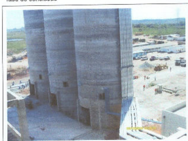
Foto 15 Via de acesso a Área de Remoção da Cinza Leve - em fase de conclusão
