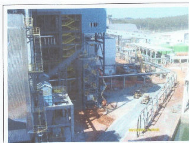
Foto 17 Área do Silo de Cinza Pesada - acesso em fase de pavimentação
