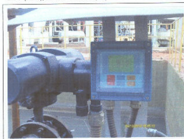
Foto 78 Medidores de pH e Vazão na bacia da Estação de Efluentes Industriais
