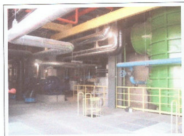
Foto 46 Tubulações Casa Maquinas, com isolamento térmico concluído
