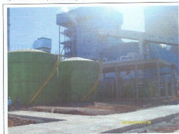
Foto 7 Via de acesso para a área de Químicos da Desmineralização - fase final.
