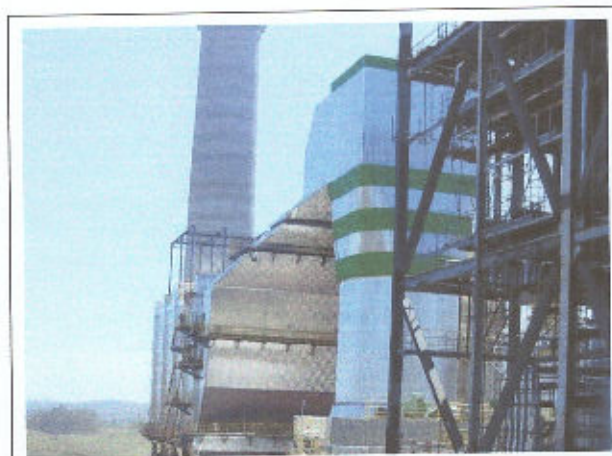
Foto 49 ESP1, Dessulfurizador (listras verdes), ESP2 (à esquerda) e chaminé ao fundo
