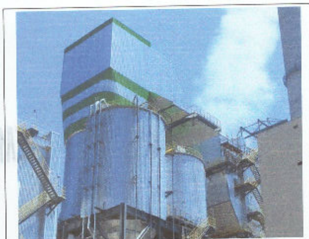
Foto 48 Dessulfurizador (1ª plano) e ESP 2 (ao fundo)
