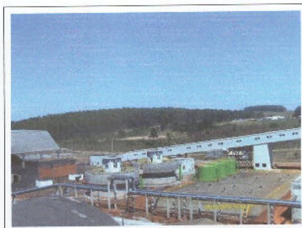
Foto 67 Clarificadores (tanques de concreto, ao centro)
