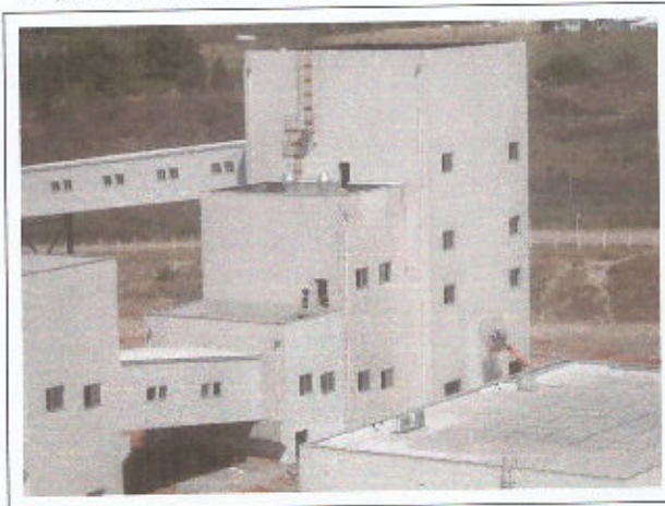
Foto 87 Sistema de transporte de Carvão e ao centro, a Torre dos Britadores de Carvão
