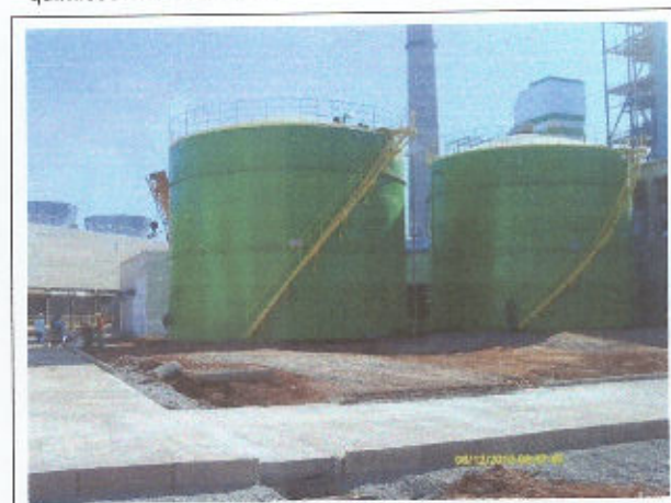
Foto 8 Via de acesso para a área de Químicos da Desmineralização - fase final.
