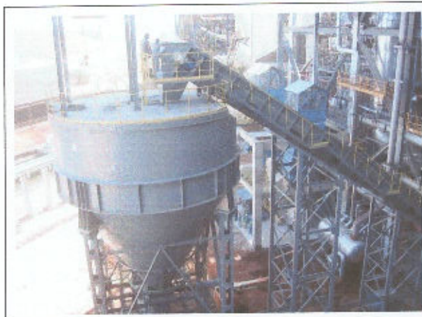
Foto 35 Silo de Cinza Pesada (vista lateral)
