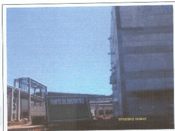
Foto 24 Ponto de Encontro em frente a Casa de Controle
