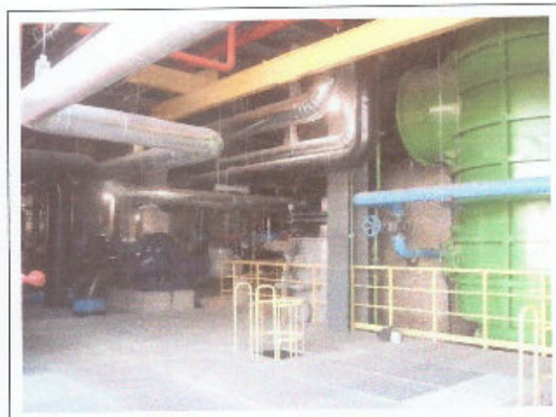
Foto 65 Tubulação Casa Máquina - com isolamento Térmico concluído
