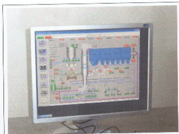
Foto 62 Monitor da sala de comando do FGD
