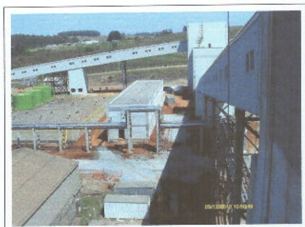
Foto 66 Casa de Bombas (prédio ao centro)
