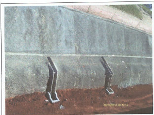
Foto 3 Instalação da drenagem superficial para escoamento das águas pluviais do talude - Concluída
