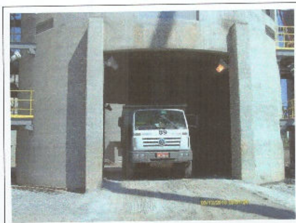
Foto 14 Carregamento na Área de Remoção da Cinza Leve - acesso em fase de conclusão
