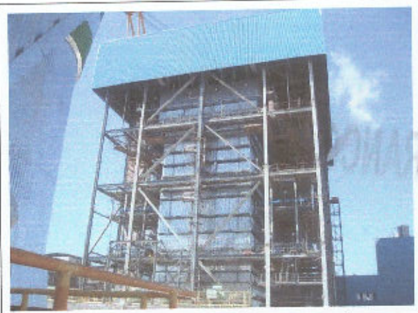
Foto 31 Caldeira - montagem concluída e em operação
