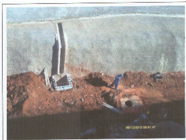
Foto 2 Instalação da drenagem superficial para escoamento das águas pluviais do talude
