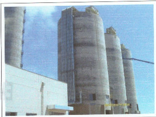
Foto 90 Tubulações de cinza e subprodutos do FGD aos Silos Cinza Leve e Silo de Subprodutos do Dessulfurizador
