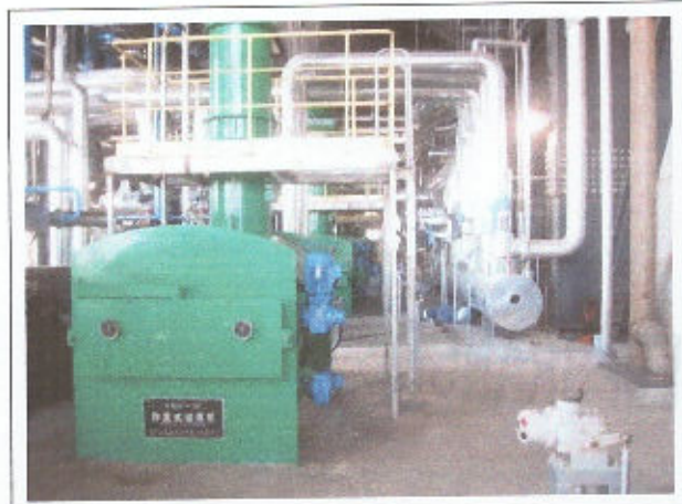
Foto 64 Coletor de vapor auxiliar (dir.)
