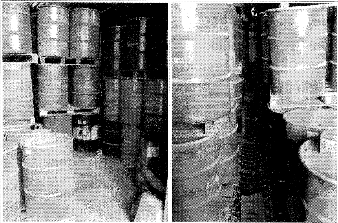
Figura 9A - Central de Armazenamento Temporário de Resíduos Classe I - Seção Interna – Compostos Inorgânicos. Empilhamento Inadequado. Acondicionamento inadequado de resíduos orgânicos x inorgânicos. Obstrução de Canaletas de Drenagem e Sistema de Exaustão.
