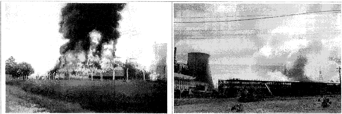
Figura 5A – Incêndio na Torre de Refrigeração a Úmido do Vapor das Fases A e B.
