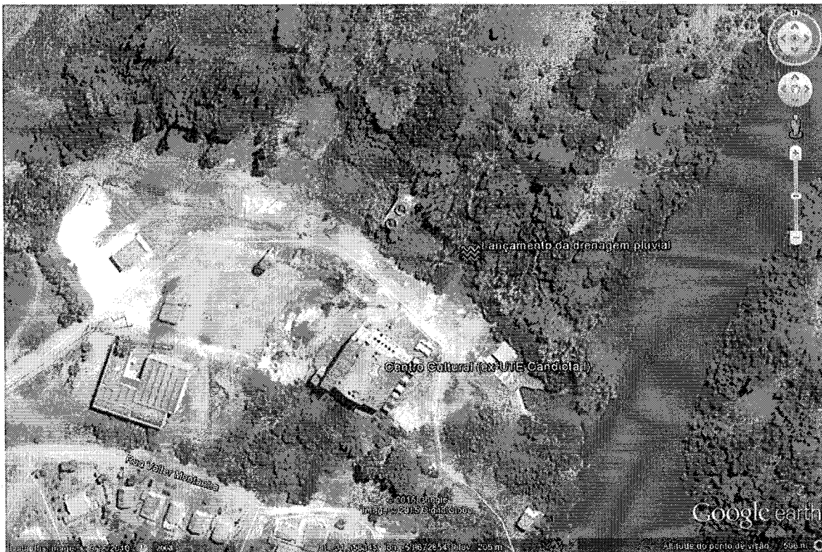
Vista de cima do lançamento da drenagem pluvial com o Arroio Candiota, a jusante da barragem.
