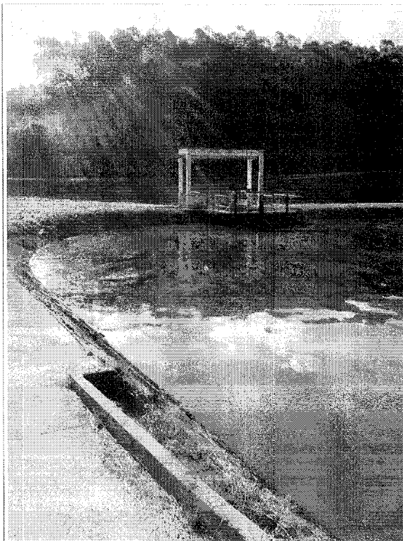
Figura 15C - Bacia de Equalização – Presença de pluma de óleo sobrenadante. Figura 15D – Descarte de Efluentes Líquidos.
