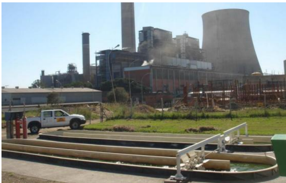
Figura 8: Fotobiorreatores do tipo Raceway – Antiga planta piloto de produção de biomassa microalgal localizada nas proximidades da torre de resfriamento das Fases A e B - Usina Termelétrica Presidente Médici, Candiota/RS.
