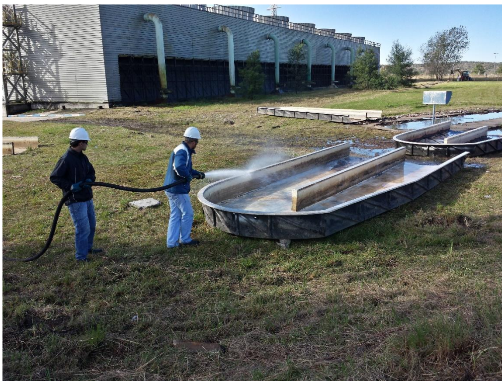
Figura 36: Limpeza dos biorreatores (02/07/2014)
