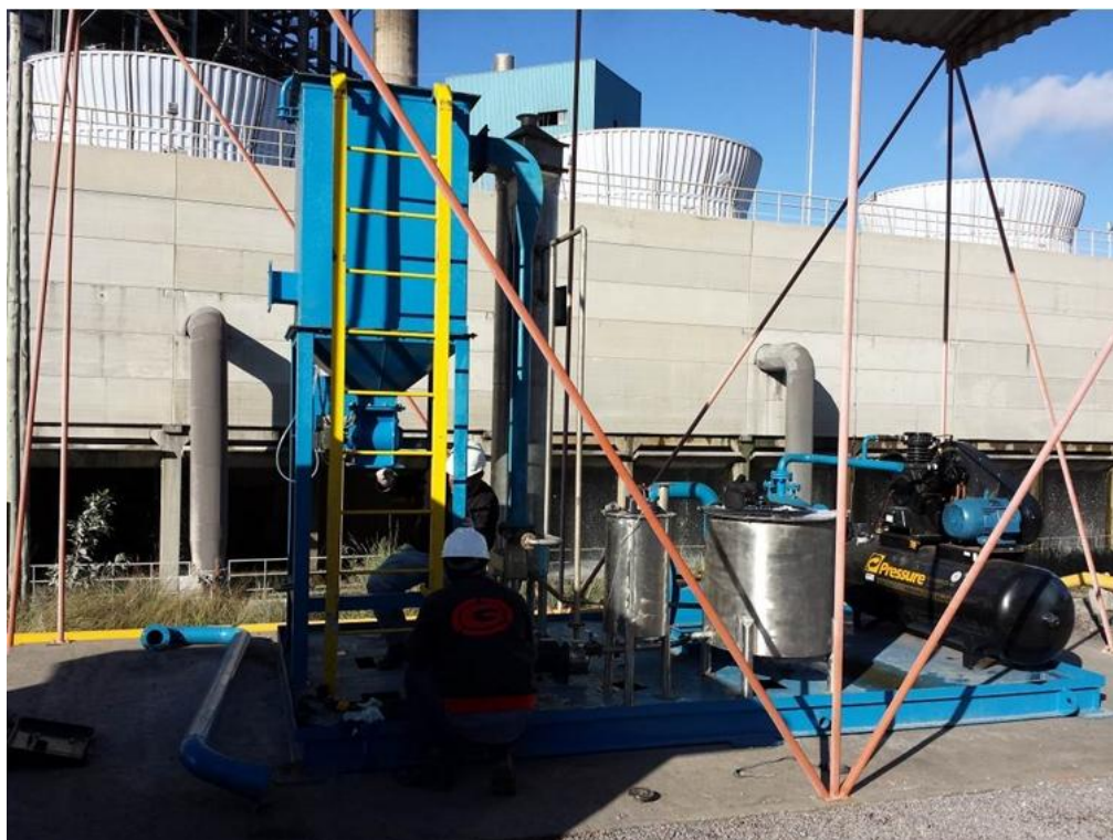
Figura 55: Montagem do Skid e Vaso de armazenagem de gás na Planta Piloto
