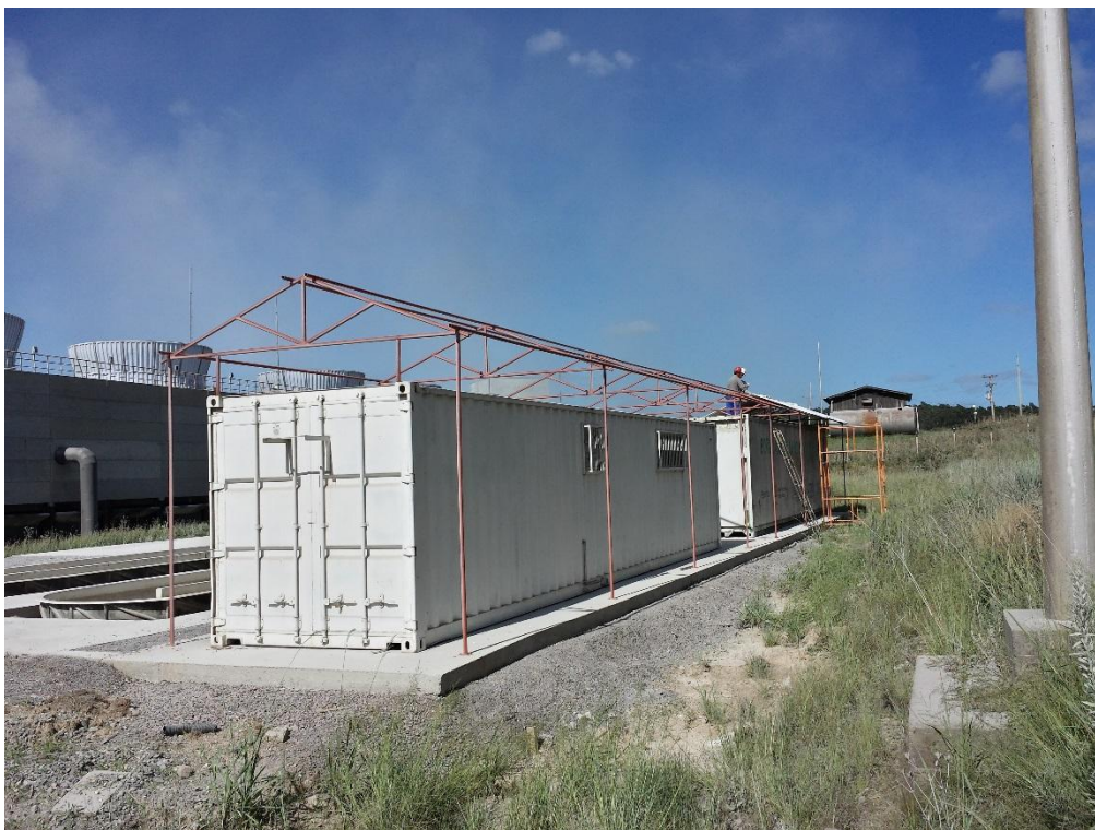
Figura 47: Instalação da cobertura dos containers
