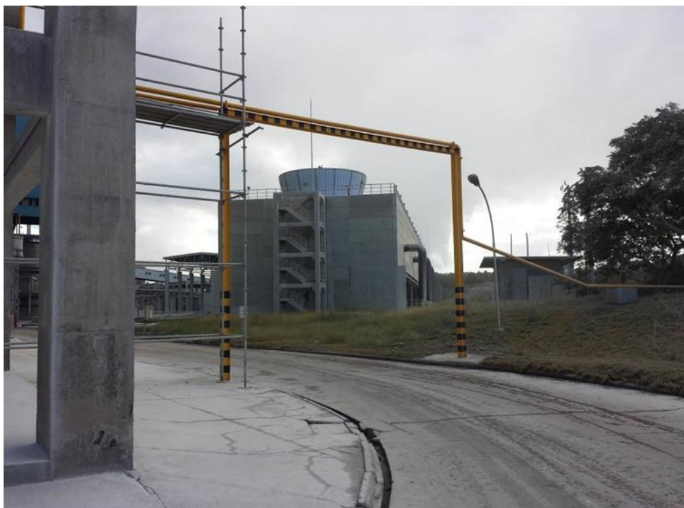
Figura 56: Assentamento tubulação da Chaminé da Fase C até Skid da Planta Piloto
