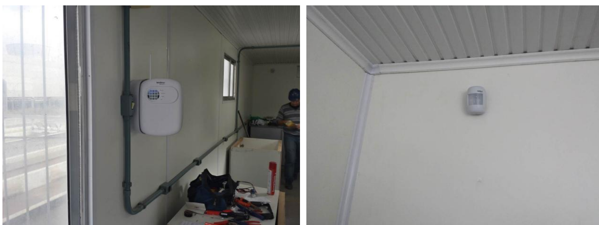
Figura 64: Instalação do sistema de segurança por alarme na Planta
