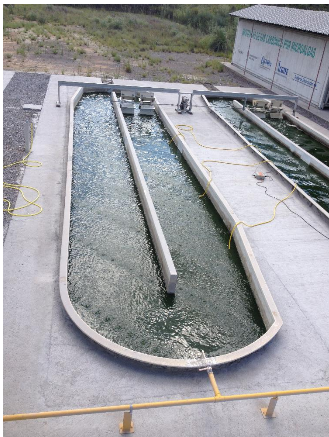
Figura 70: Vista aérea da Planta Piloto em operação
