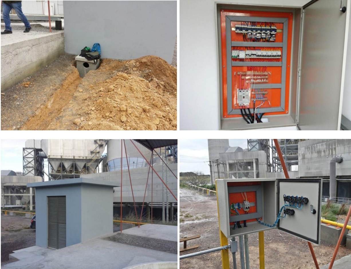
Figura 62: Instalação da Rede Elétrica na Planta
