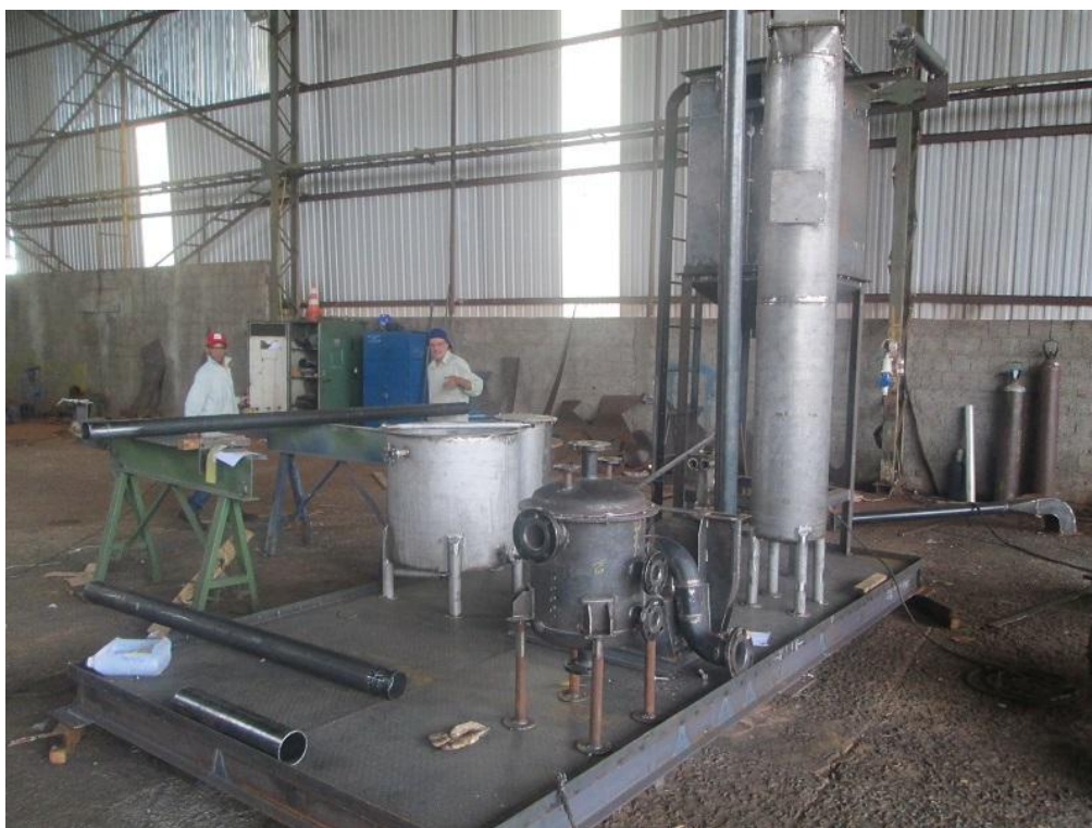
Figura 53: Montagem dos equipamentos que compõem o Skid
