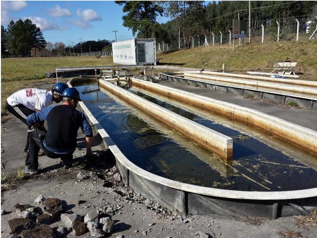
Figura 34: Remoção dos biorreatores (18/06/2014)
