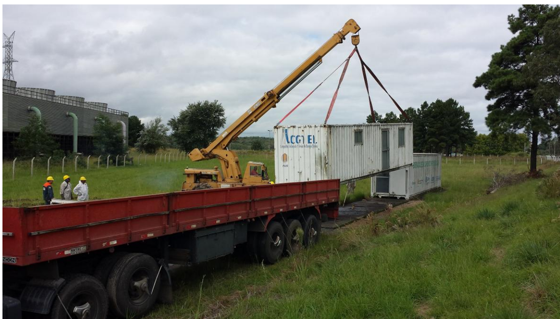
Figura 28: Retirada do container laboratório (20/03/2014)
