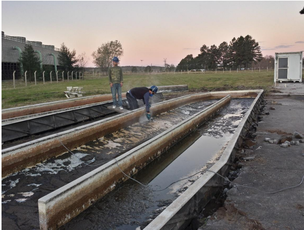
Figura 35: Remoção dos biorreatores (18/06/2014)
