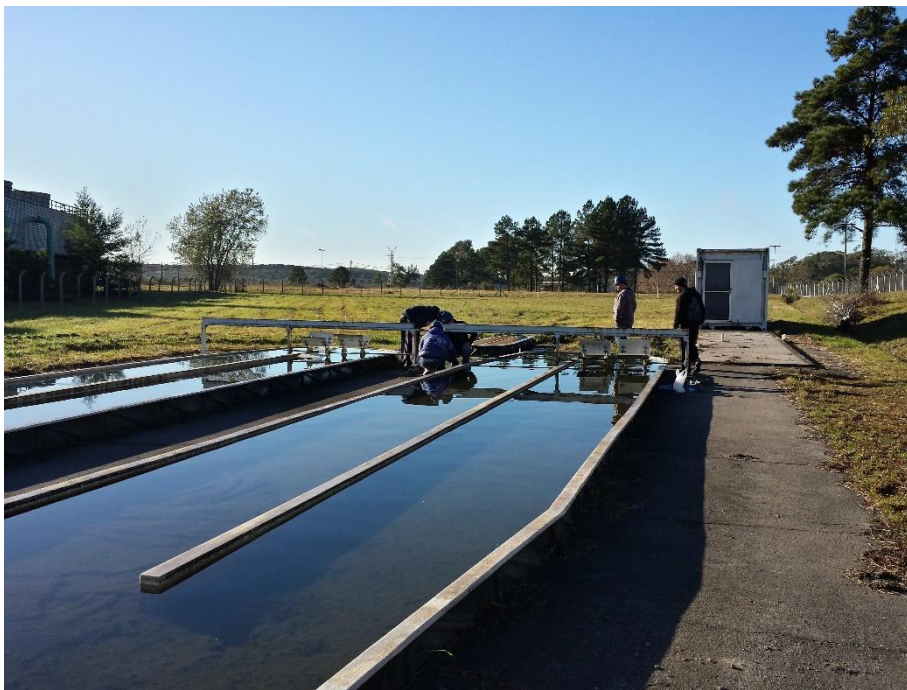
Figura 33: Remoção do sistema de agitação dos biorreatores (18/06/2014)
