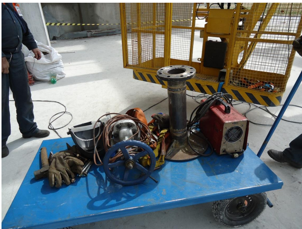
Figura 24: Material utilizado para instalação do ponto e Tie-in montado
