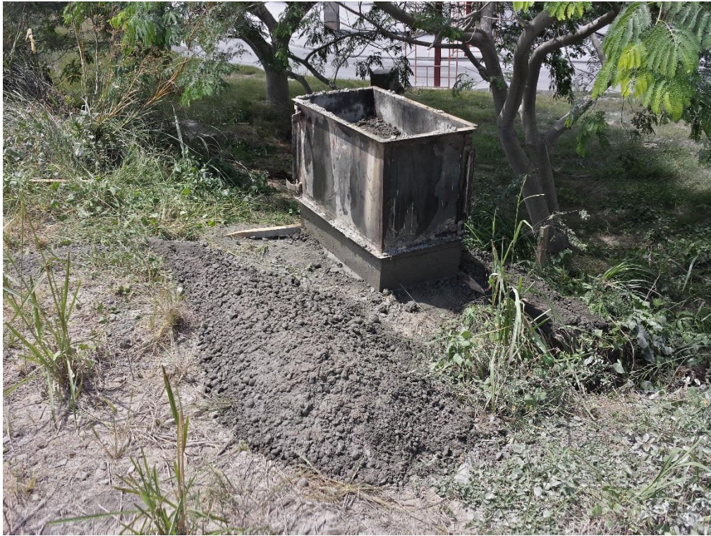
Figura 43: Construção dos dormentes para assentamento da tubulação de gás
