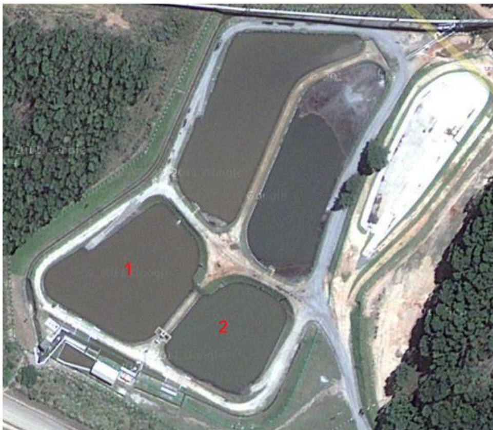
Figura 7: Lagoas de decantação da UTPM/CGTEE
