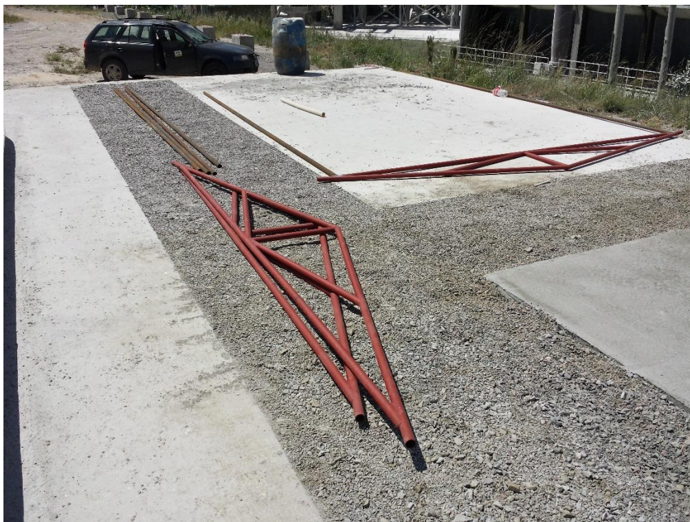
Figura 48: Instalação da cobertura do Skid
