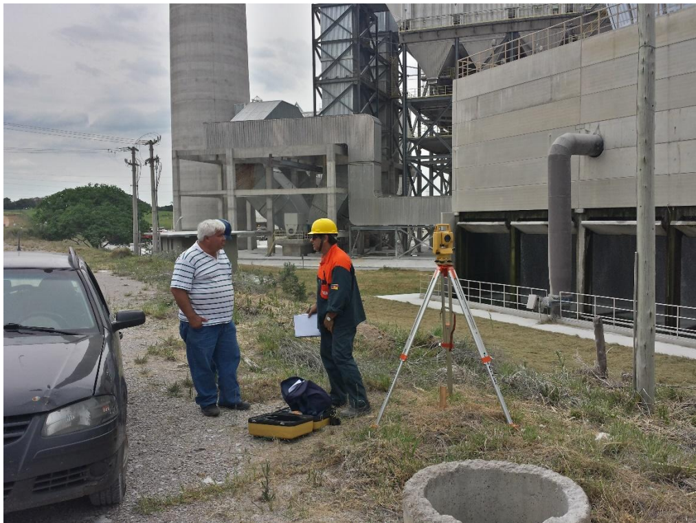
Figura 38: Marcação das coordenadas para início da construção das bases (29/10/2014)
