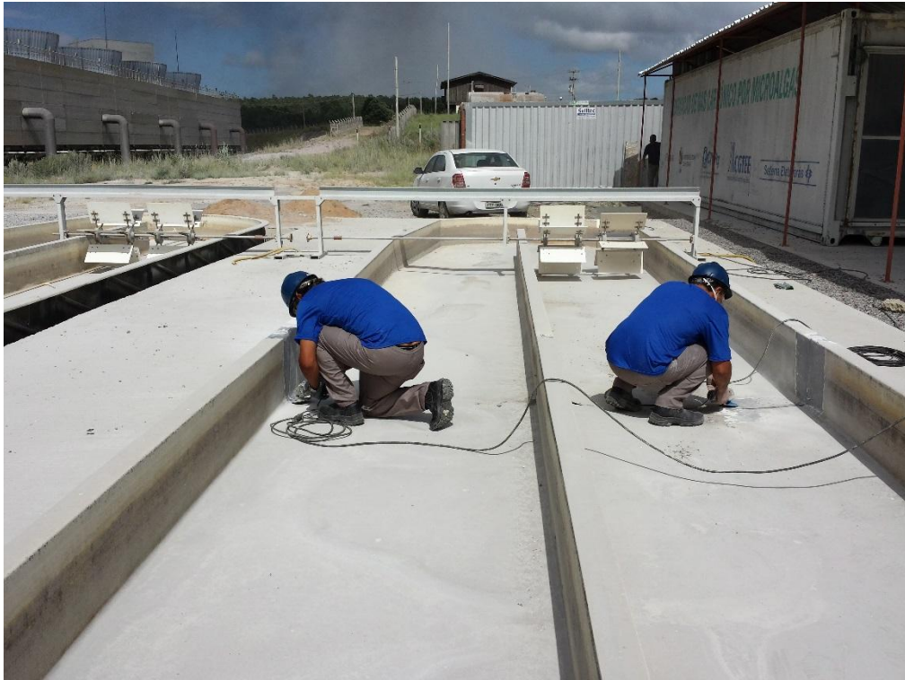
Figura 51: Reparo nos fotobiorreatores instalados na atual Planta Piloto
