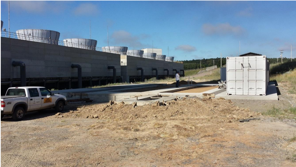
Figura 41: Bases dos fotobiorreatores e do Skid concluídas
