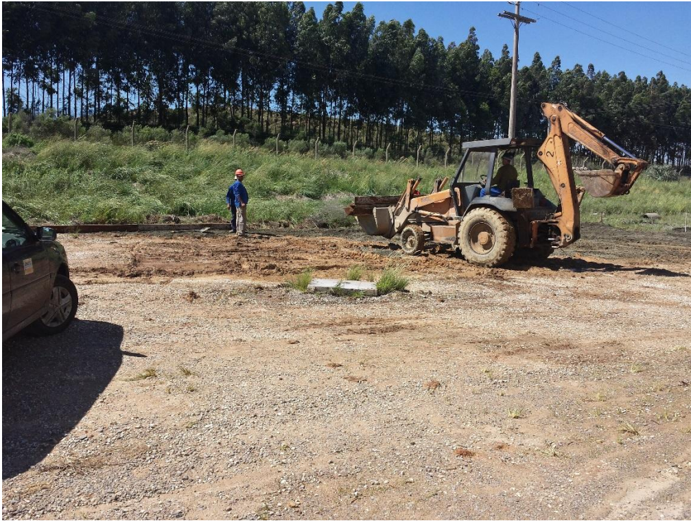
Figura 39: Início da construção das bases (04/11/2014)
