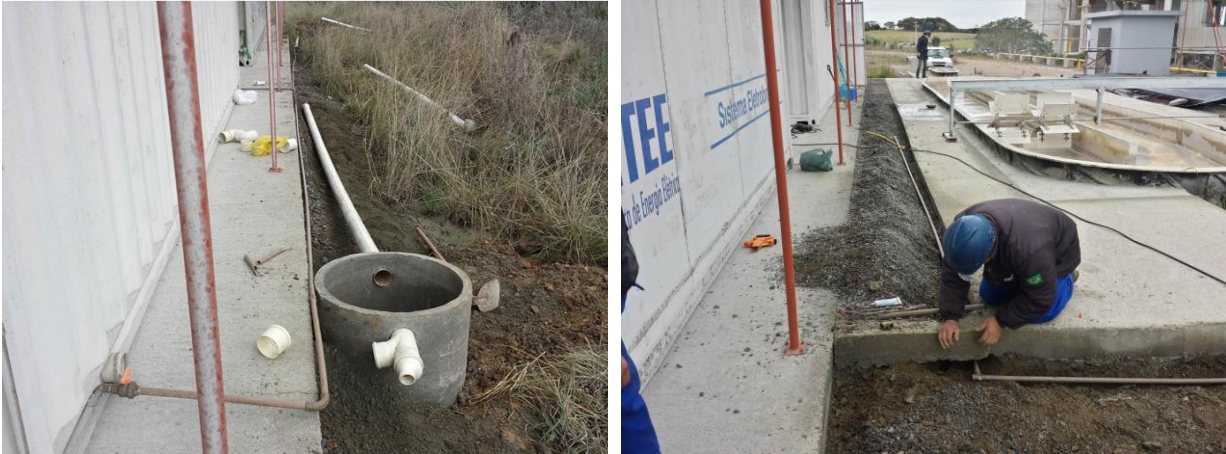
Figura 61: Instalação da Rede Hidráulica na Planta
