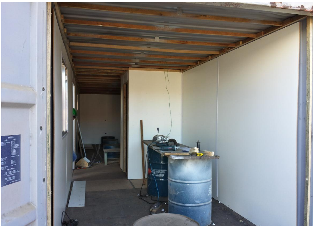
Figura 29: Reforma do container laboratório na sede da empresa ViaCon (21/03 a 03/06/2014)
