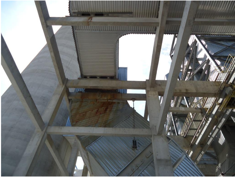
Figura 23: Local definido para tomada dos gases e início da execução do serviço
