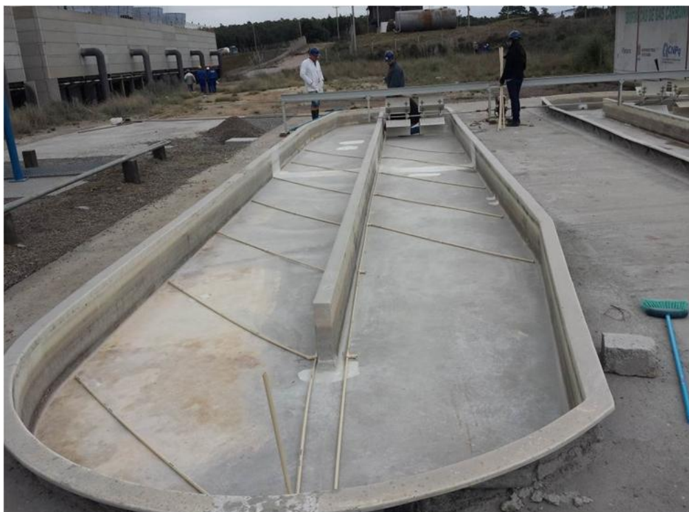
Figura 60:Montagem da tubulação de gás nos fotobiorreatores
