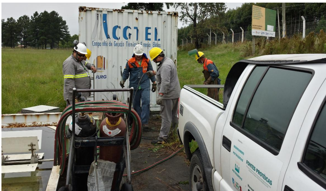
Figura 27: Retirada do container laboratório (20/03/2014)
