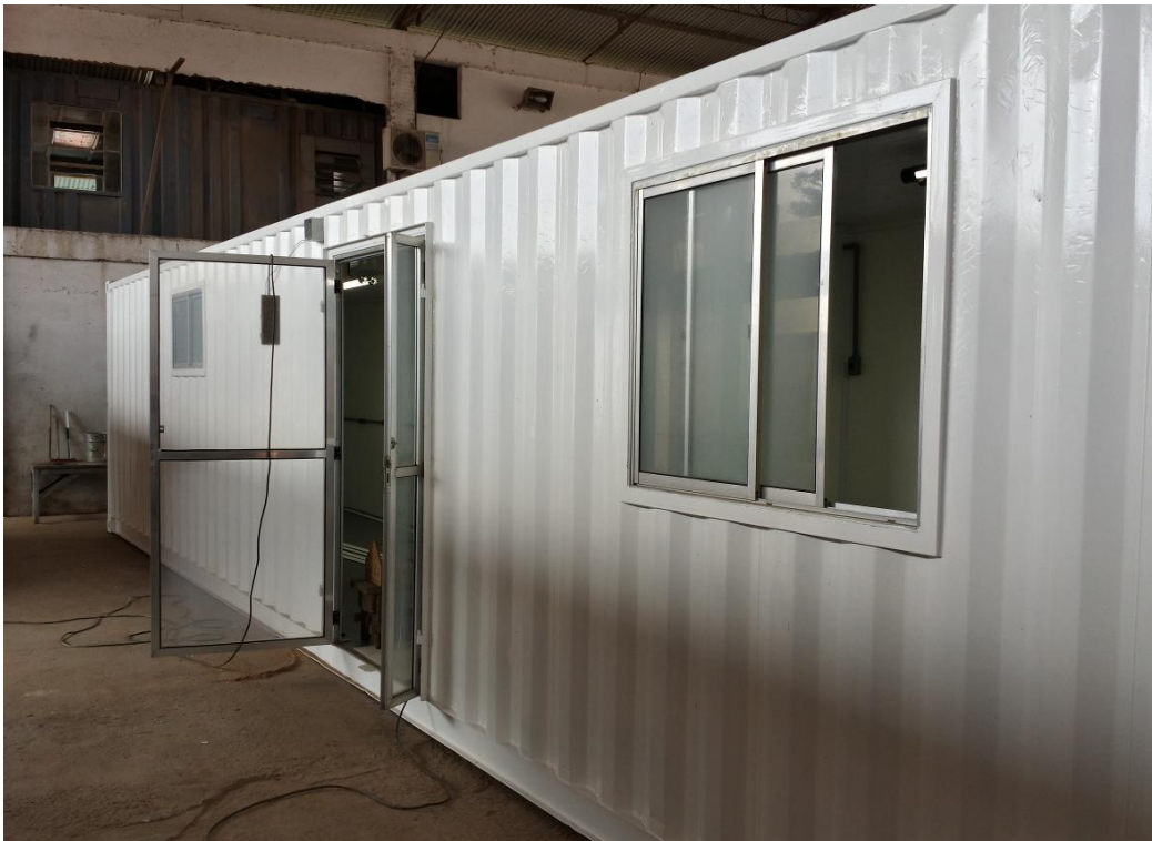
Figura 30: Reforma do container laboratório na sede da empresa ViaCon (21/03 a 03/06/2014)
