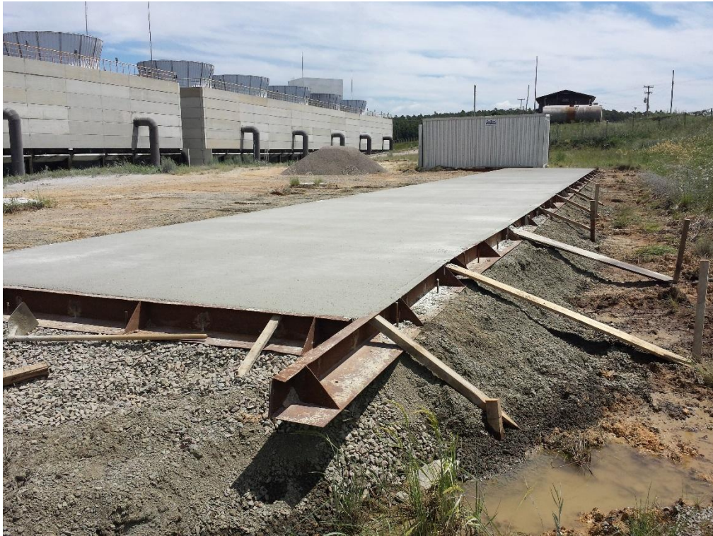
Figura 40: Base dos containers e início da construção das bases dos fotobiorreatores
