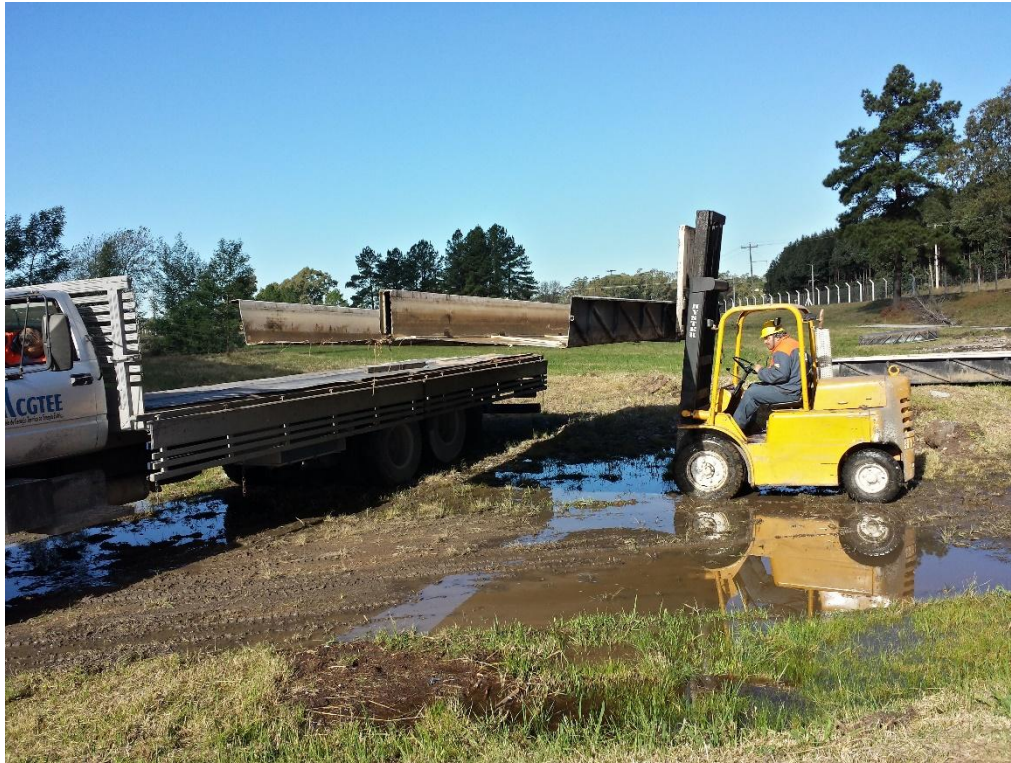
Figura 37: Transporte dos biorreatores para a nova localização da Planta Piloto nas proximidades da Fase C (02/07/2014)
