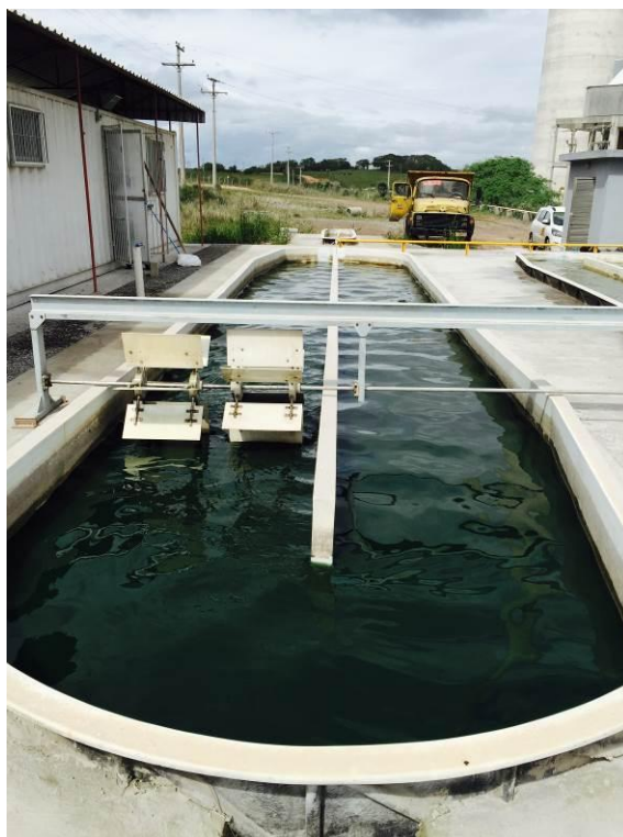
Figura 67: Início de operação da planta piloto: tomada de amostra para realização de análises químicas e microbiológicas
