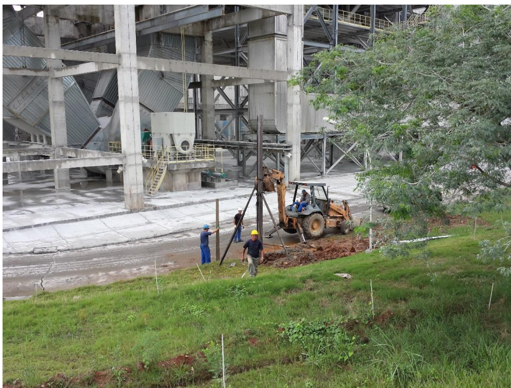
Figura 45: Construção do pipe-rack para passagem da tubulação de gás
