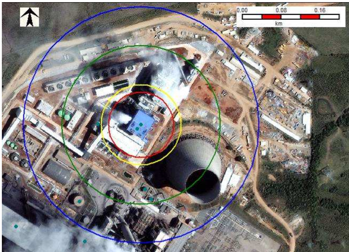
Figura 3.18- BLEVE da caldeira da Fase C, Cenário 22C, alcances para sobrepressões de 0,43 bar (vermelho), 0,3 bar (amarelo), 0,1 bar (verde) e 0,05 bar (azul)
