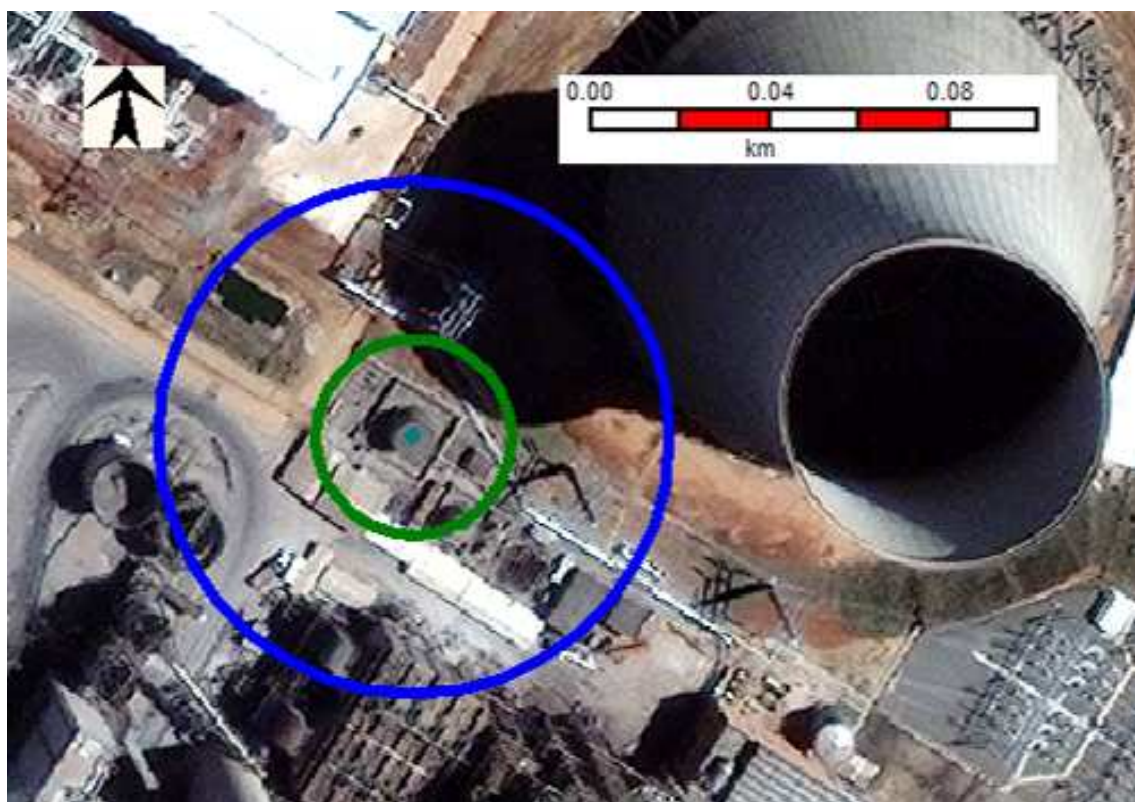
Figura 3.7- Incêndio em poça de óleo combustível, no dique do tanque de 500 m 3 da Fase B, Hipótese 20B, alcance para fluxos térmicos de 3 kW/m 2 (azul) e 12,5 kW/m 2 (verde)
