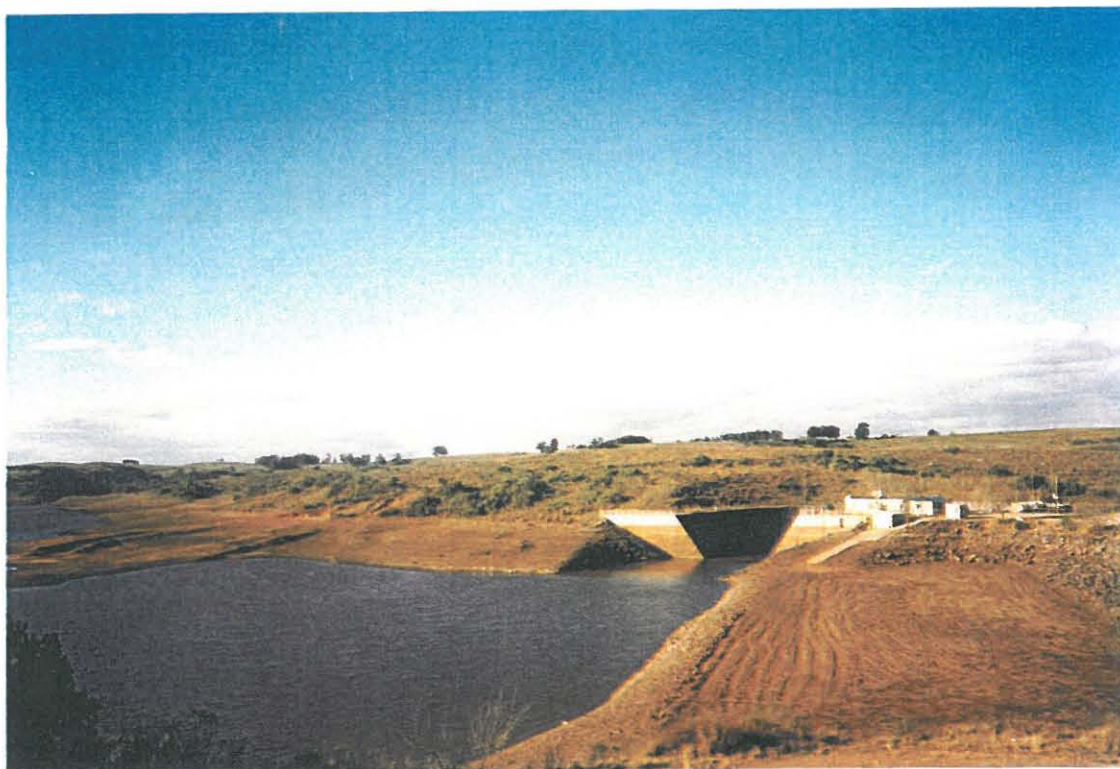
FOTO 2.3-Barragem II e vertedor.
