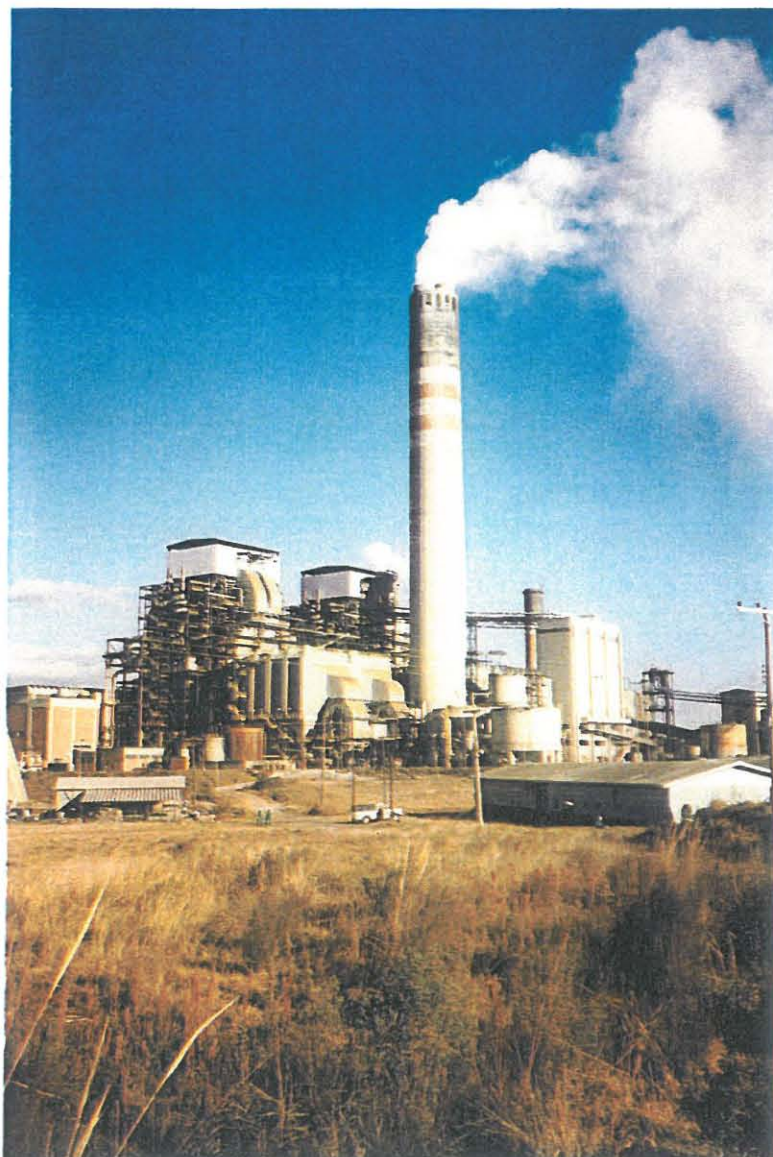
FOTO 2.1-UTPM e sítio para instalação da Usina Termelétrica Candiota III.
