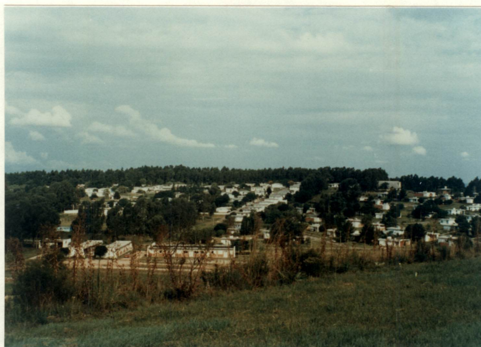
FOTO 2.5 - Vila Residencial - Vista geral.
