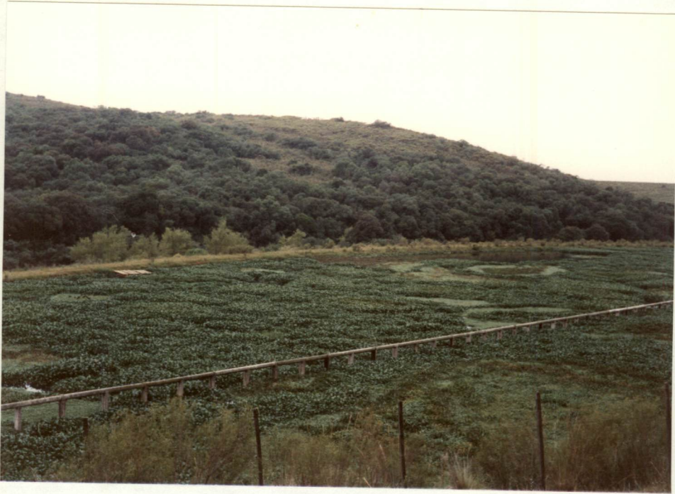
FOTO 2.8 - Lagoa de estabilização da Vila Residencial.
