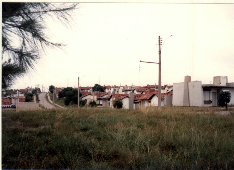
FOTO 2.4 - Vila Operária - Vista geral.
