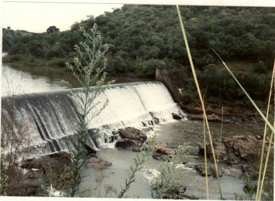
FOTO 2.9 - Barragem I - Abastecimento da UTPM.
