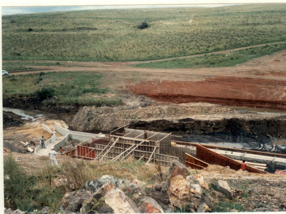
FOTO 2.11 - Barragem Quebra-Jugo - Fase de construção.
