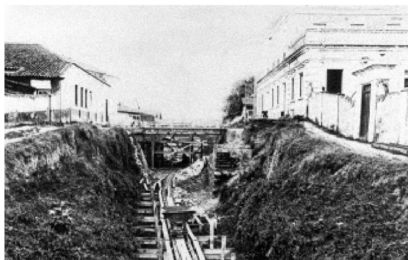
| Construção do Canal Campos – Macaé (Fonte: Blog Instituto Historiar - http://institutohistoriar.blogspot.com/2008/06/canal-campos-maca.html )
