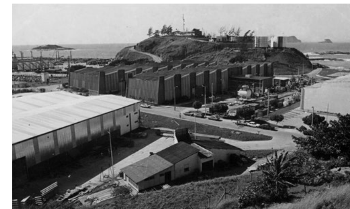
| Construção do Atual Terminal Alfandegado de Imbetiba, da Petrobras. Fonte: Biblioteca do IBGE
