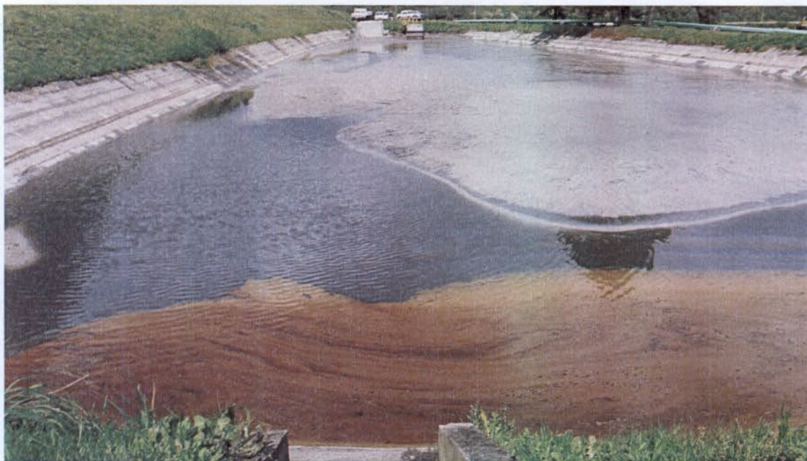
Figura 2. Ponto 1 da figura 1 - Bacia de emergência: Presença de efluentes contaminados com óleo e material sólido sedimentado
