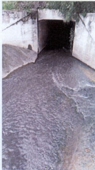
Figura 9. Ponto 4 da figura 1 – Bacia de sedimentação nº 4 e Reservatório de captação do sistema de recirculação de efluentes líquidos (também à direita na foto superior).
