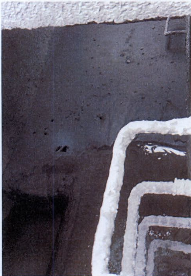
Figura 69: Ponto 4 da figura 56 – Registro de óleo presente em todos os compartimentos da Caixa SAO nº 05
