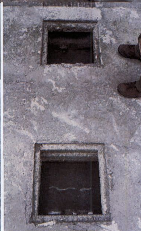
Figura 74: Ponto 5 da figura 56 – Caixa SAO localizada na fase C sem indícios de óleo
