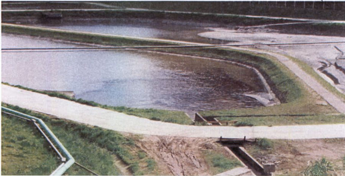
Figura 4. Ponto 2 da figura 1 - Bacias de sedimentação: Presença de pluma de óleo na bacia nº 1 à esquerda e material sólido sedimentado aguardando recolhimento na bacia nº 2 à direita.
