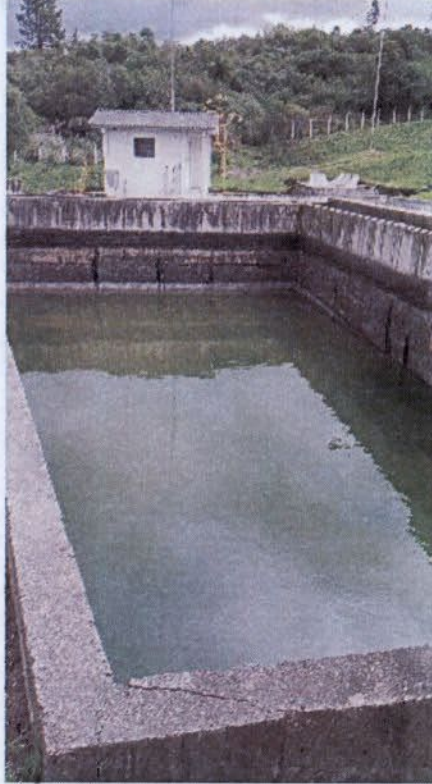
Figura 9. Ponto 4 da figura 1 – Bacia de sedimentação nº 4 e Reservatório de captação do sistema de recirculação de efluentes líquidos (também à direita na foto superior).
