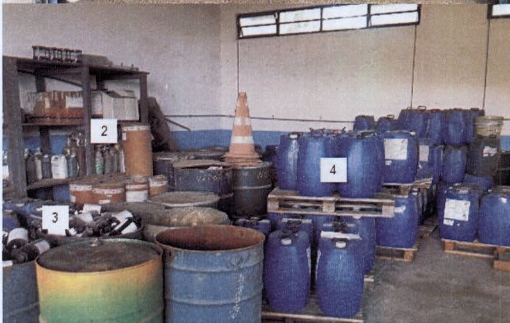
Figura 46 - Vista do primeiro compartimento da Central, não destinada aos resíduos Classe I, com destaques de acondicionamento inadequado de resíduos perigosos, conforme detalhado nas próximas fotos
