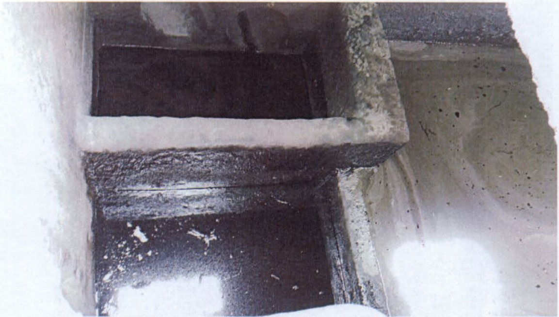
Figura 69: Ponto 4 da figura 56 – Registro de óleo presente em todos os compartimentos da Caixa SAO nº 05
