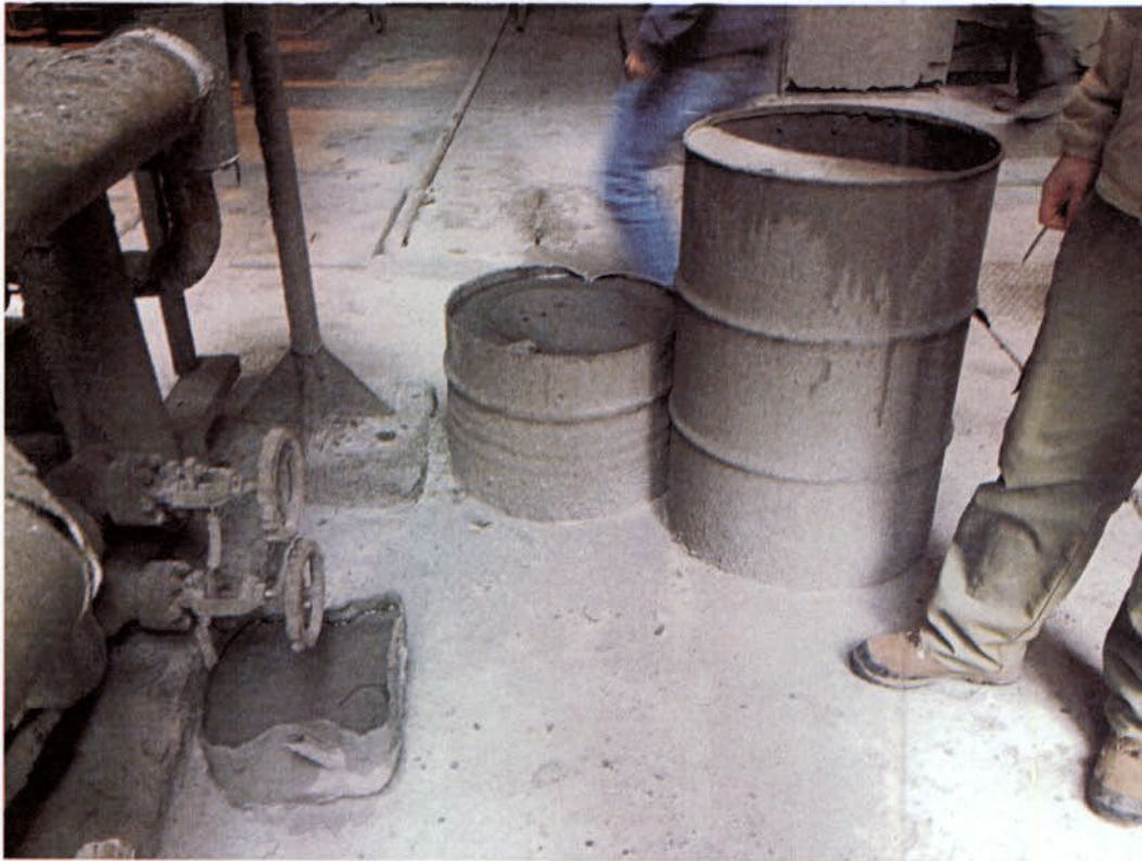
Figura 61: Ponto 2 da figura 56 – Vazamentos de óleo na Fase A em contenção por tonéis metálicos, com acondicionamento inadequado
