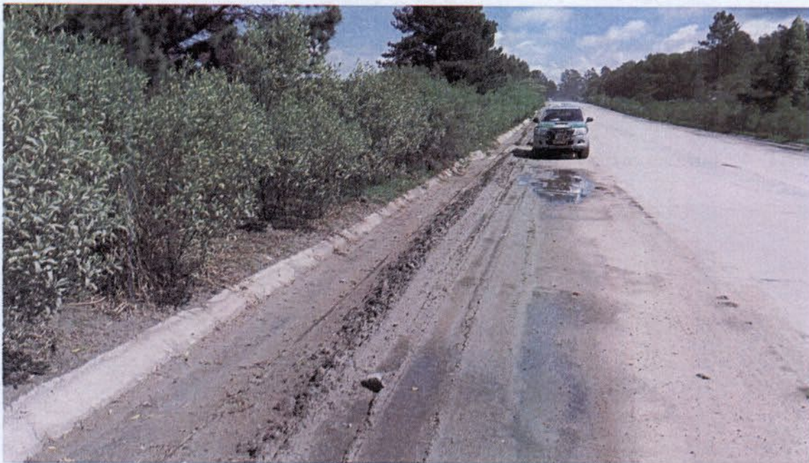
Figura 14 - Registro de sedimentos na estrada de acesso à Companhia Riograndense de Mineração em ponto cuja drenagem é descartada no corpo hídrico receptor dos efluentes da usina
