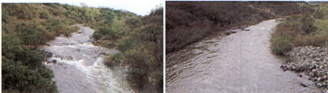
Figura 78. Direita: Montante do PM4 ; Esquerda: Jusante do PM4
