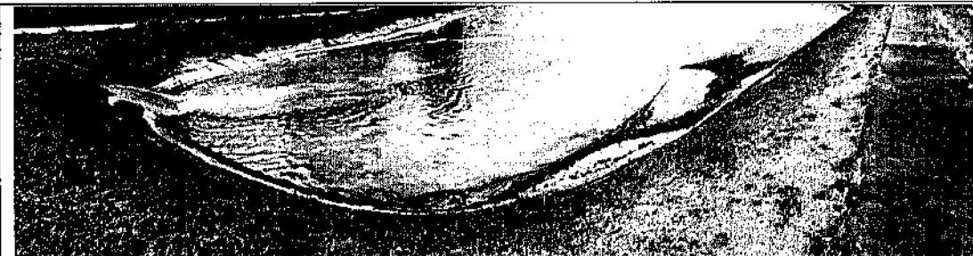
A3. Bacia 1 de Decantação de Cinzas. Recebimento de efluentes líquidos contaminados com Óleo
