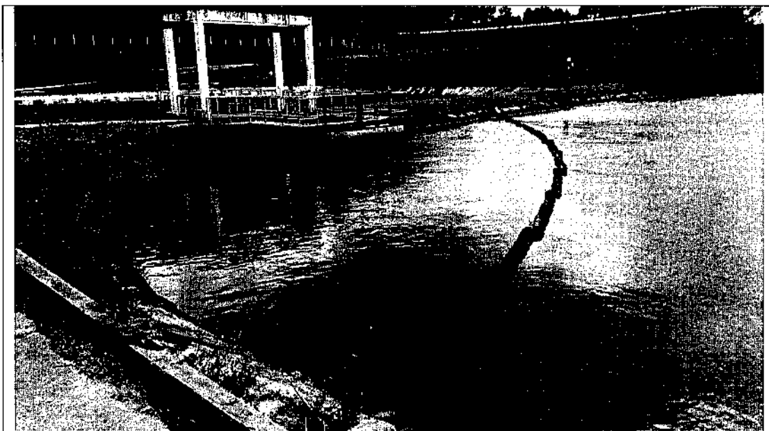
A7. Bacia 3 de Decantação de Cinzas. Barreira absorvedora de Óleo, visualmente saturada. Ação de contingência.
