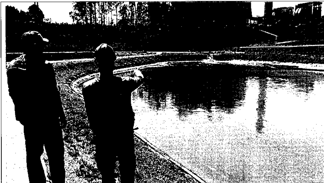
A1. Bacia 1 de Decantação de Cinzas. Recebimento de efluentes líquidos contaminados com Óleo, em vazão instantânea de 515,8 m 3 /h
