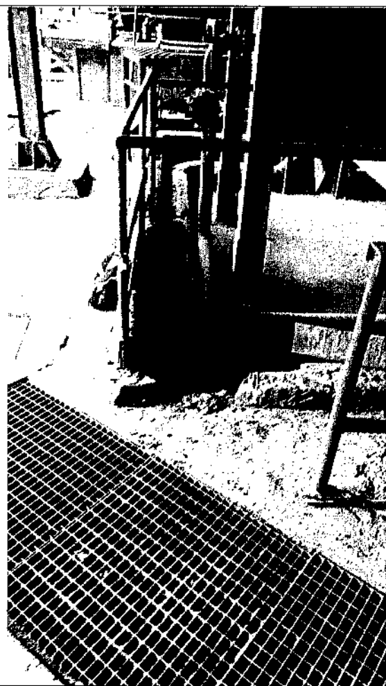
C6. Duto de descarga de drenagem da tremonha de cinzas de fundo da caldeira. Ponto crítico de vazamento decorrente da ineficiência de injeção do combustível nos queimadores. Ausência de dispositivo de contenção de drenagem oleosa, que é direcionada para a drenagem profunda sem prévio tratamento, vertendo para a bacias de decantação.
