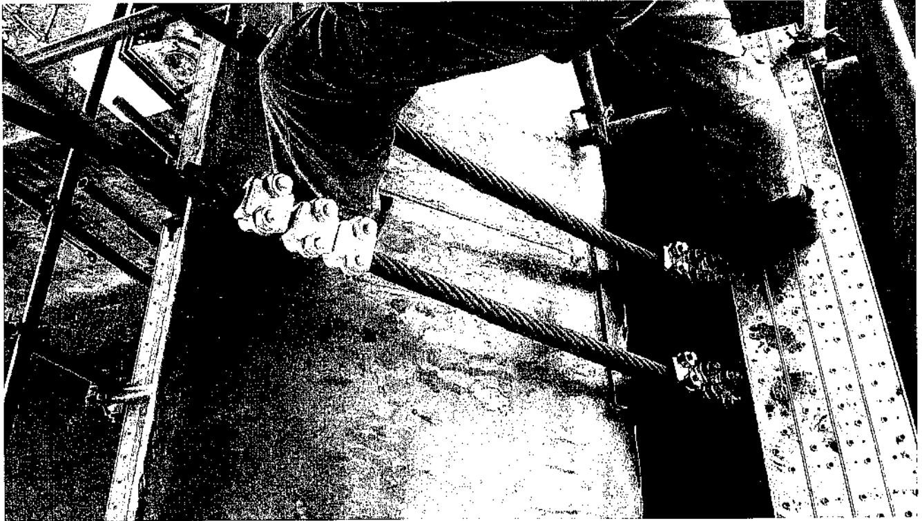
Figura 3: recuperação dos cabos da Comporta 1
