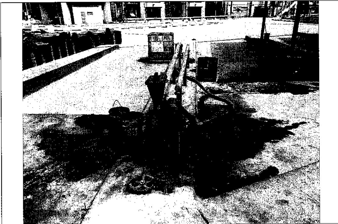
A.7. Vazamento em Válvula de Transferência da Estação de Abastecimento da Tancagem de Óleo Combustível. Contaminação da pavimentação e dispositivo de coleta de drenagem superficial.
