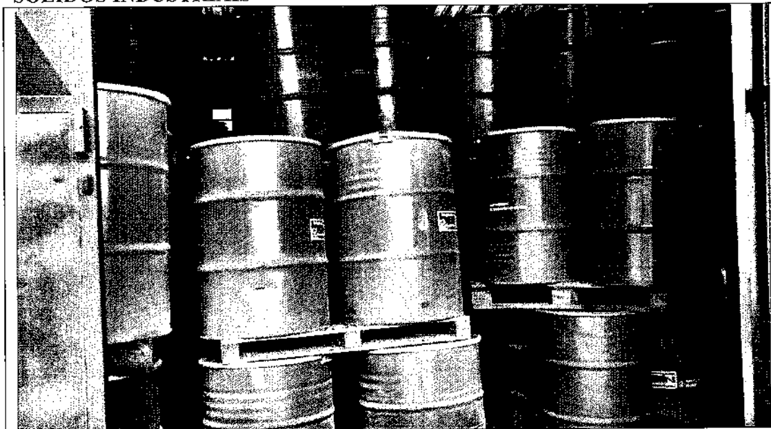
C.1. Seção interna de armazenamento de resíduos Classe I – Perigosos – Compostos Orgânicos. Galpão com ausência de espaço para armazenamento; Empilhamento indevido em suporte de madeira em péssimo estado de conservação, sem caixa/bacia coletora.
