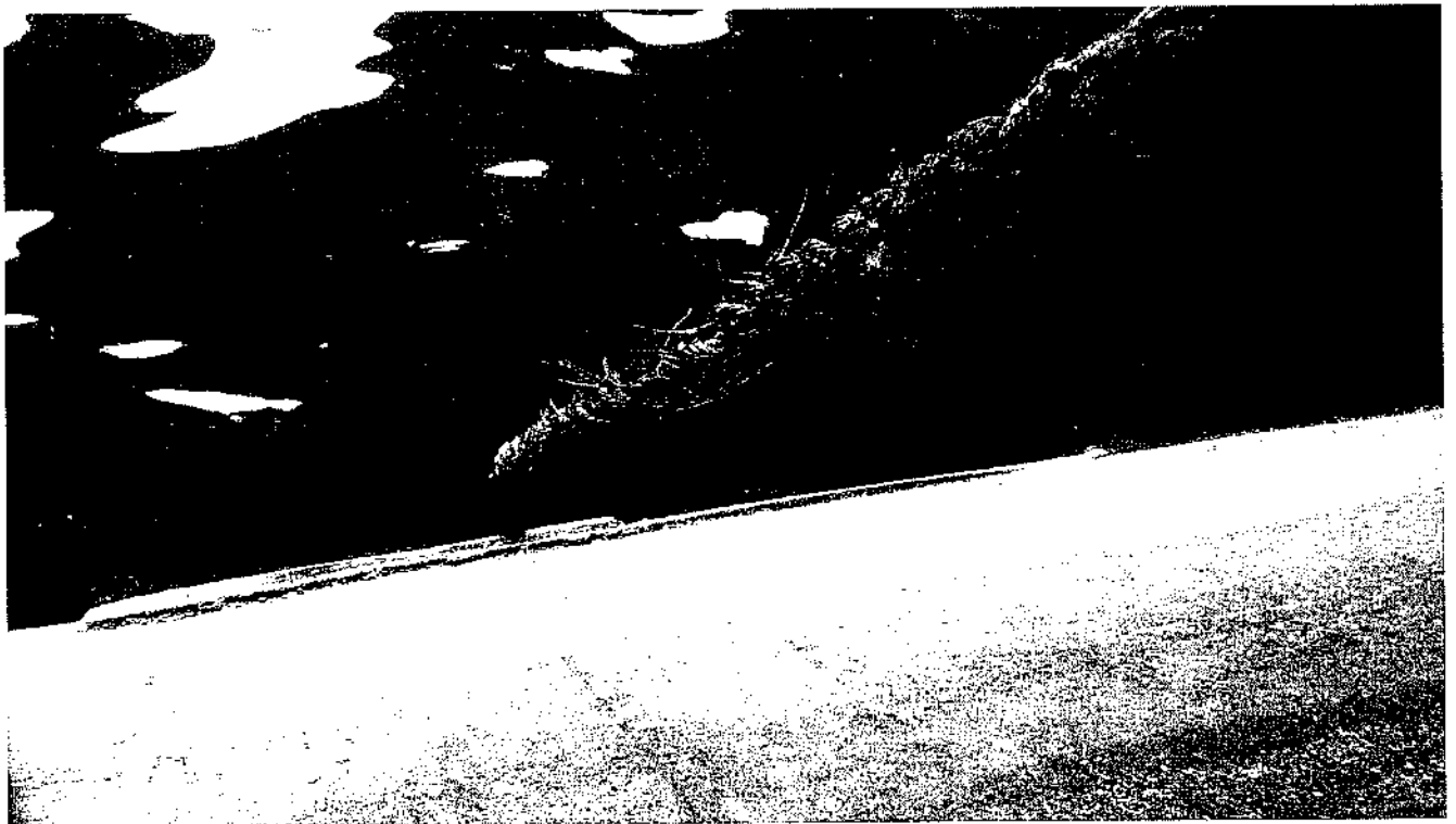
Figura 2: cabo de aço da Comporta 1 prestes a romper
