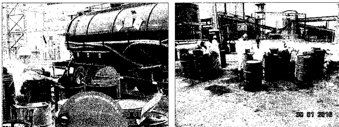
Figura 01. Esvaziamento e limpeza dos tambores contendo resíduos oleosos.
