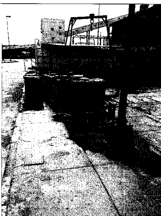
A.3. Armazenamento inadequado de óleo combustível em toneis desprovidos de tamponamento. Contaminação de pavimento dispositivo de coleta de drenagem superficial..
