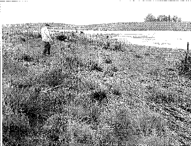
Evidência de ausência de manutenção
