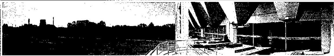
Figura 2E – Vista panorâmica da Sacada em piso superior do Centro Cultural Candiota I – Ao fundo a UTPM.
