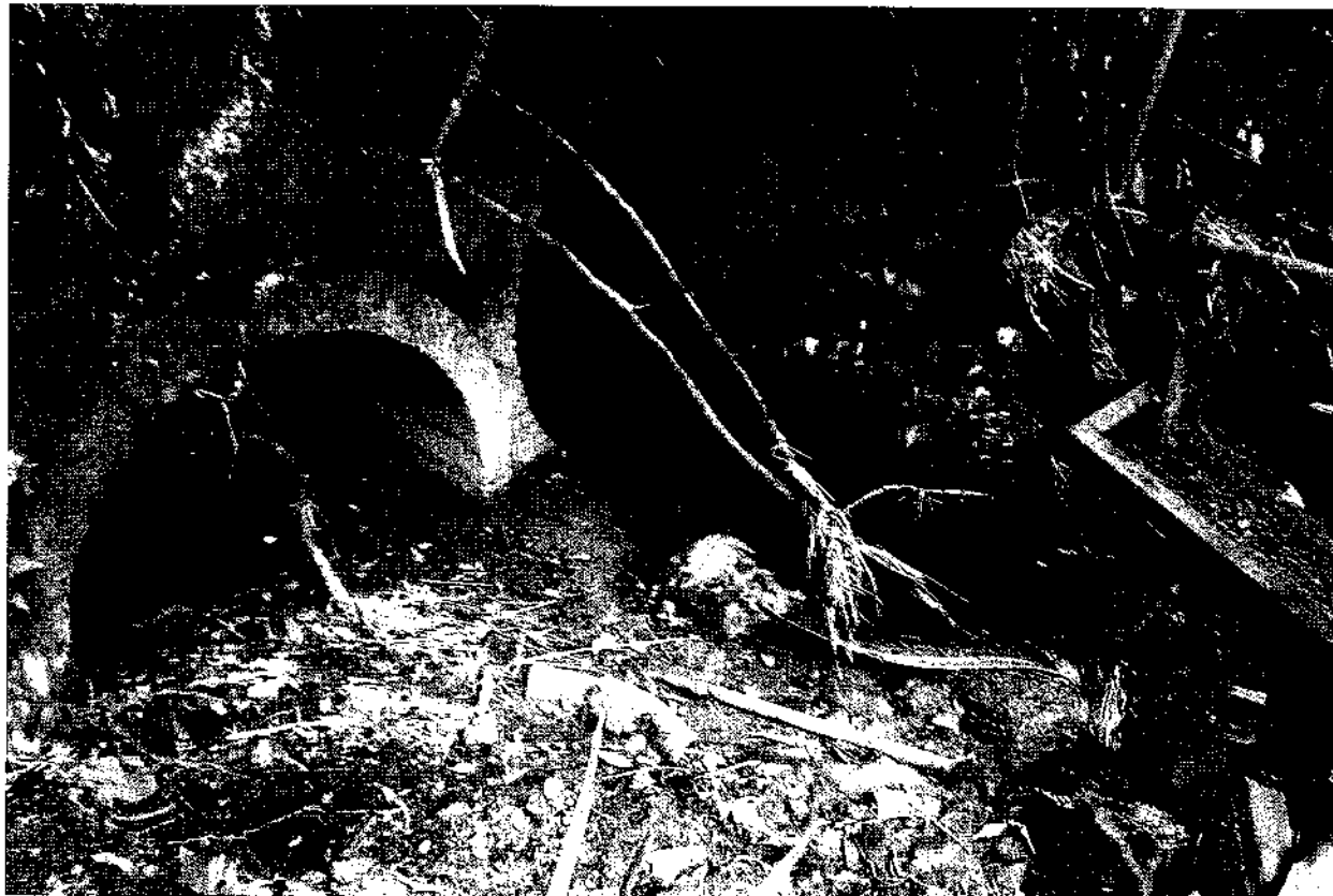
Local de lançamento da drenagem pluvial do Pátio do Centro Cultural e local de lançamento do efluente doméstico da Vila Residencial.
