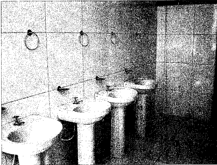
Foto 31 - Vista Interna Sanitários
