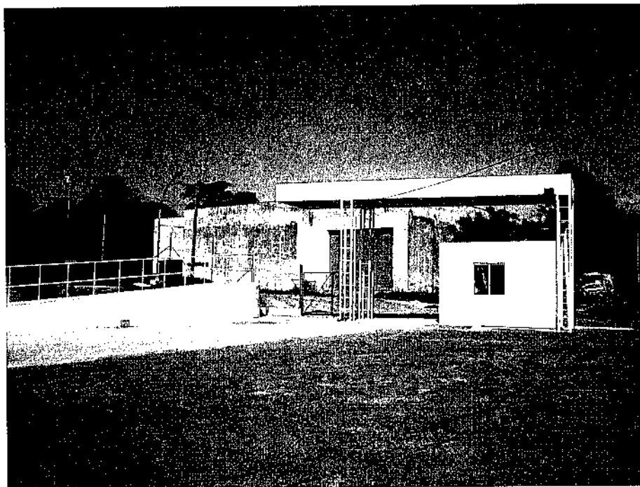
Foto 04 – Vista Guarita/Rampa de Acesso
