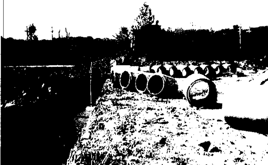
Foto 12 – Vista da área externa com tubos e escavações da Prefeitura Municipal
