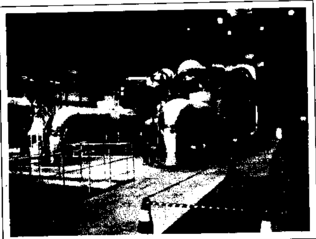
Foto 43 Turbina - foto do lado de admissão de vapor superaquecido e reaquecido
