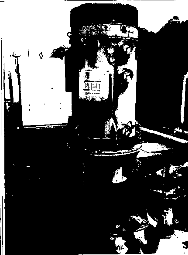
A.83. Bomba Centrífuga da Fase B. Observa-se deterioração da estrutura metálica.
