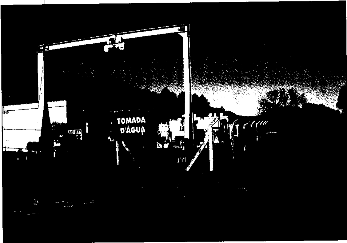
Figura 13. Tomada D'Água da UPME.
