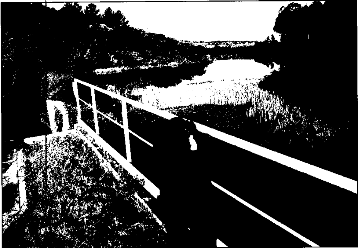
Figura 7. Vista da Entrada do Canal de Adução na Barragem I.
