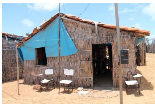
Foto 7.3-55: Tipologia das casas da CRQ Pontal da Barra durante a fase de ocupação das famílias, CRQ Pontal da Barra (CH2M, fev/17)
