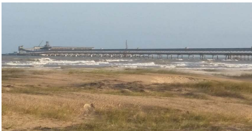
Foto 7.3-2: Vista de trecho da correia transportadora do Terminal Marítimo Ignácio Barbosa (TMIB).
