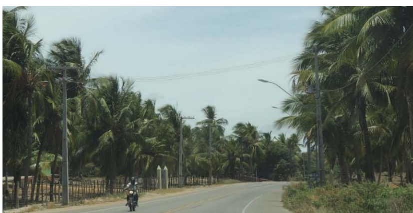
Foto 7.3-7: Áreas ociosas com coqueirais ao longo da rodovia SE-100: potencial uso para fins imobiliários.
