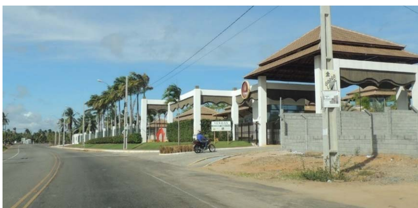
Foto 7.3-6: Entrada do Condomínio Thai, no Povoado de Capuã.
