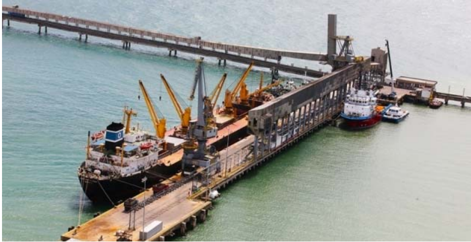
Foto 3-1 Visão do cais de atracação do TMIB, com espaço para apenas uma embarcação de grande porte. Ao fundo, a Ponte de Ligação, com acesso para caminhões e uma correia transportadora enclausurada para transferência de granéis sólidos.
