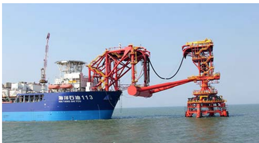
Foto 3-3: Sistema de Ancoragem em Torre
