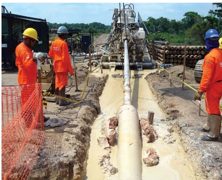
Foto 3-5: Instalação de tubulação por Perfuração Direcional Horizontal.
