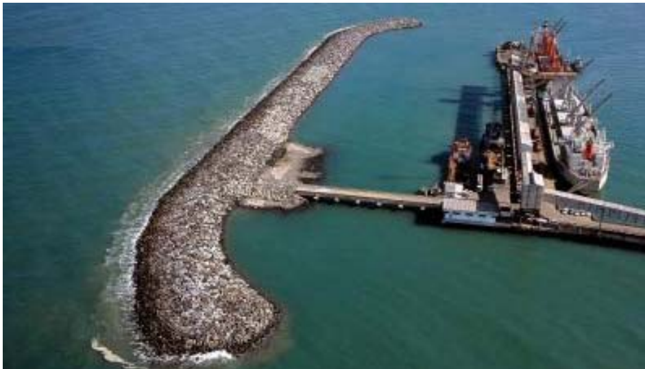
Foto 3-2 Mesmo cais de atracação, visto do lado oposto e com o quebra-mar em enrocamento que lhe dá proteção.
