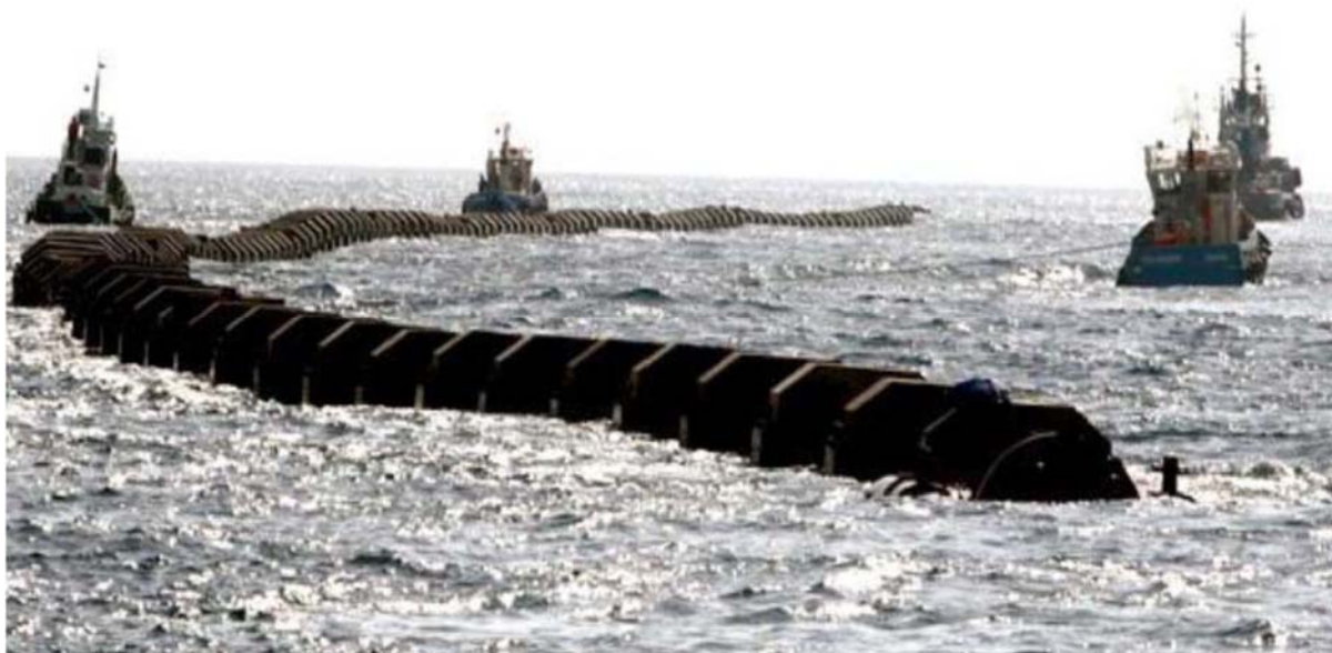
Foto 5-3: Segmento de duto sendo transportado em flutuação por rebocadores
