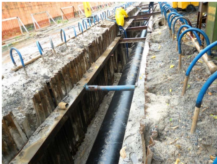
Foto 3-4: Escavação em valas para a implantação de tubulações de grande diâmetro
