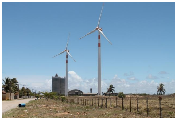
Foto 8.4-1: complexo eólico barra dos coqueiros, praia do jatobá: usos industriais no entorno da área do projeto
