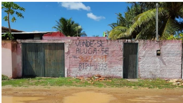
Foto 7.3-39: Casa 2 antes da desocupação
