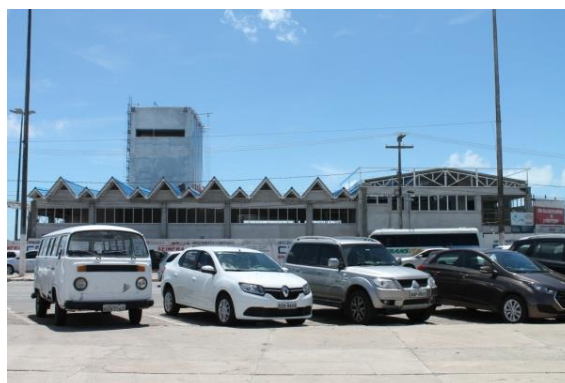
Foto 7.3-21: Obras de ampliação do Terminal Pesqueiro Público de Aracaju
