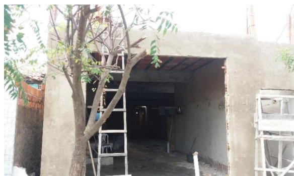
Foto 7.3-43: Visita de acompanhamento social na nova casa / comércio do Anísio que está sendo construída na Praia de Jatobá
