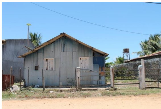
Foto 7.3-44: Casa 5 que atualmente encontra-se demolida
