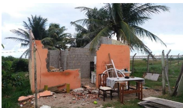
Foto 7.3-31: Casa 1 – Benfeitoria 1 na Praia de Jatobá que pertence ao Lu e Bira está desocupada e liberada para demolição
