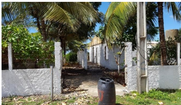
Foto 7.3-37: Casa 2 antes da desocupação
