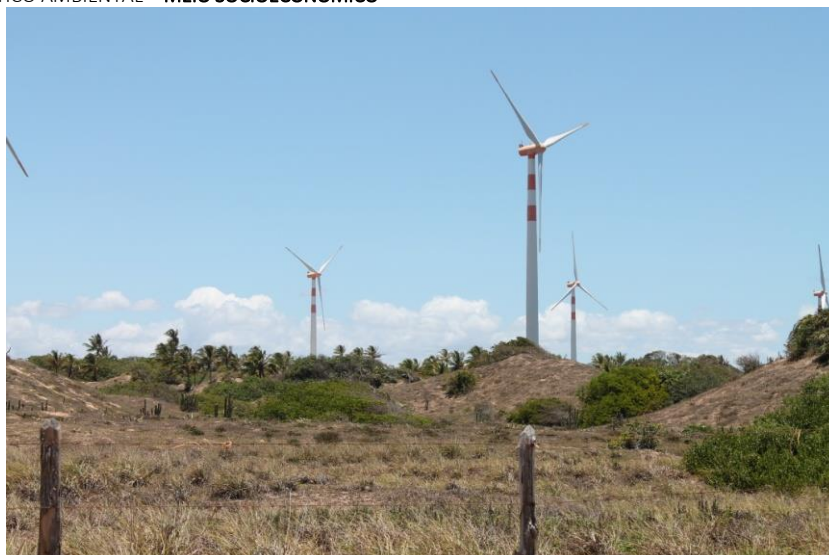
Foto 7.3-9: Complexo Eólico Barra dos Coqueiros (UEE Barra dos Coqueiros)
