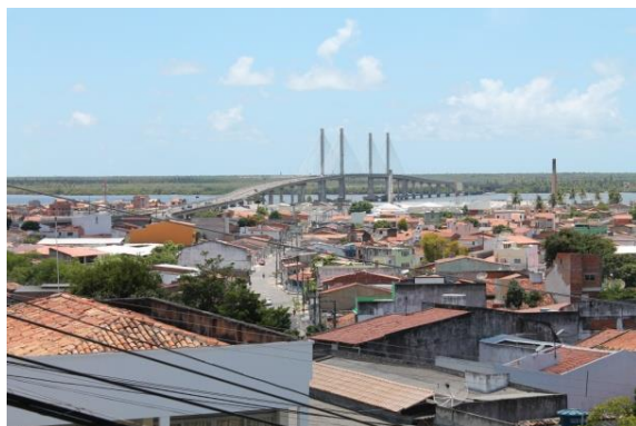
Foto 7.3-10: Ponte Governador João Alves que liga Aracaju a Barra dos Coqueiros: vetor de intensificação de ocupação e consequente pressão imobiliária
