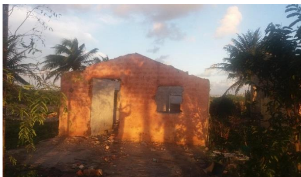
Foto 7.3-33: Casa 1 – Benfeitoria 2 na praia de jatobá que pertence ao Zé Ivo Batista está desocupada e liberada para demolição
