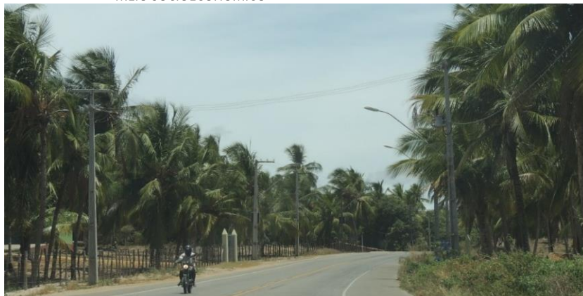
Foto 7.3-7: Áreas ociosas com coqueirais ao longo da rodovia SE-100: potencial uso para fins imobiliários
