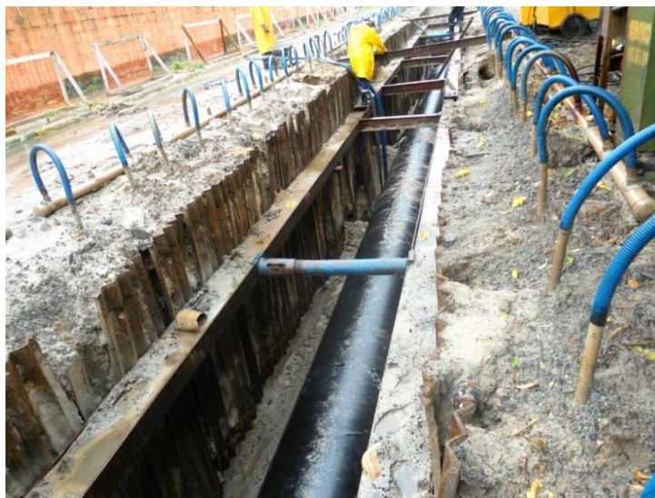
Foto 3-4: Escavação em valas para a implantação de tubulações de grande diâmetro
