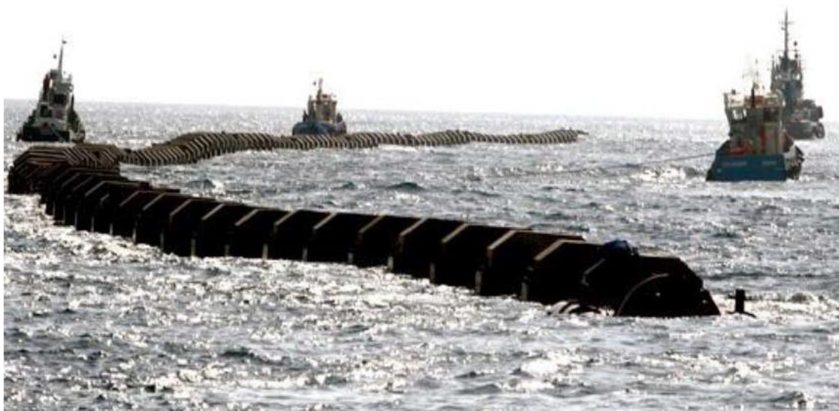
Foto 5-5: Segmento de duto sendo transportado em flutuação por rebocadores
