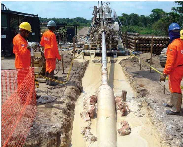
Foto 3-5: Instalação de tubulação por Perfuração Direcional Horizontal.
