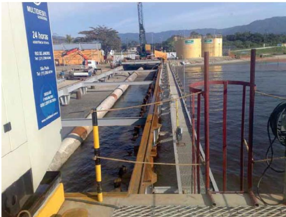
Foto 5-3: Exemplo de ponte provisória (vista para onshore)
