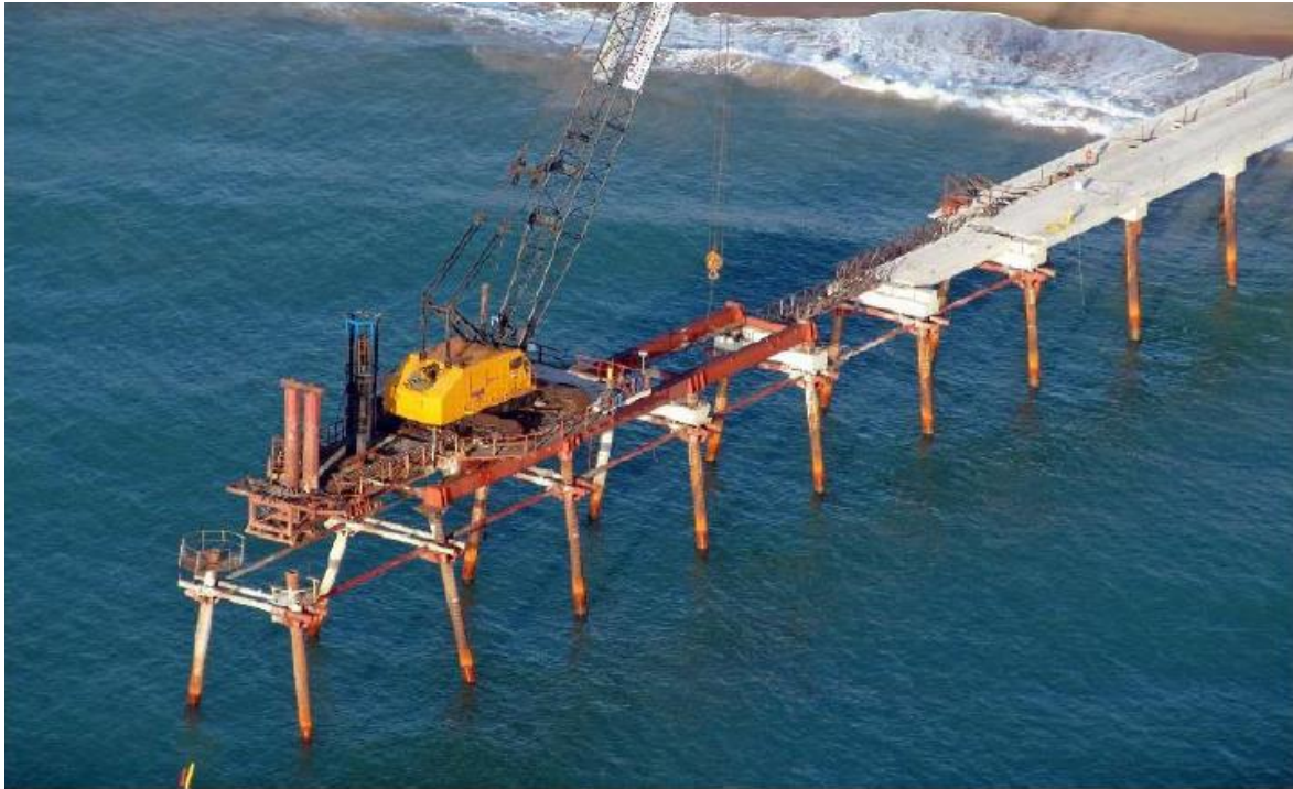
Foto 5-4: Exemplo de ponte provisória
