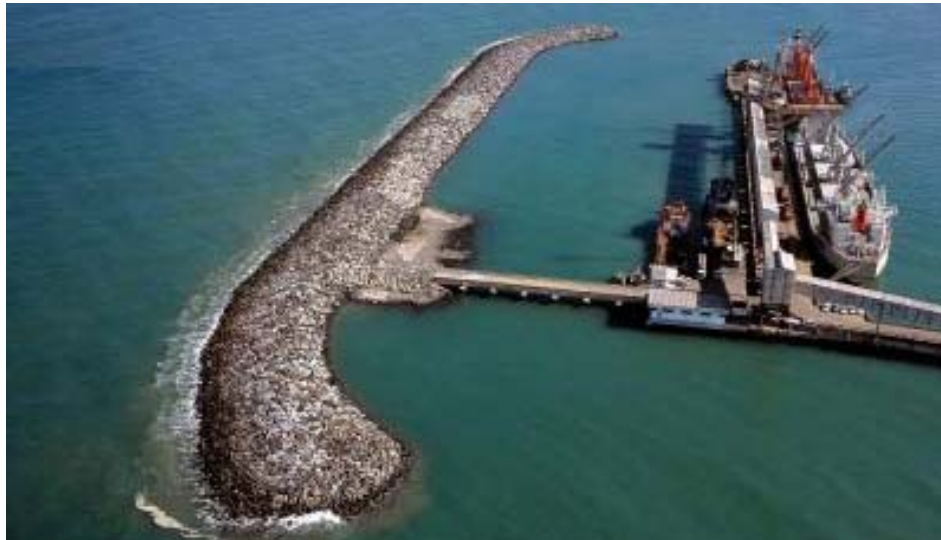
Foto 3-2: Mesmo cais de atração, visto do lado oposto e com o quebra-mar em enrocamento que lhe dá proteção
