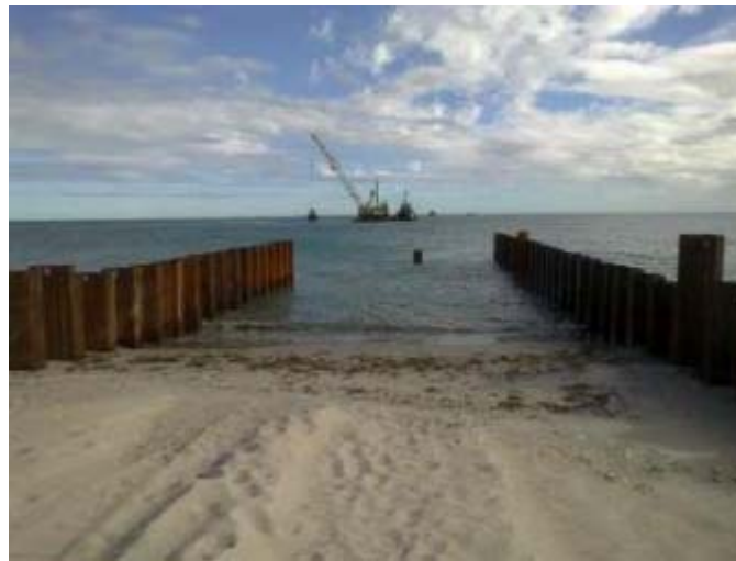
Figura 3-13: Exemplo de Cofferdam para instalação de gasoduto
