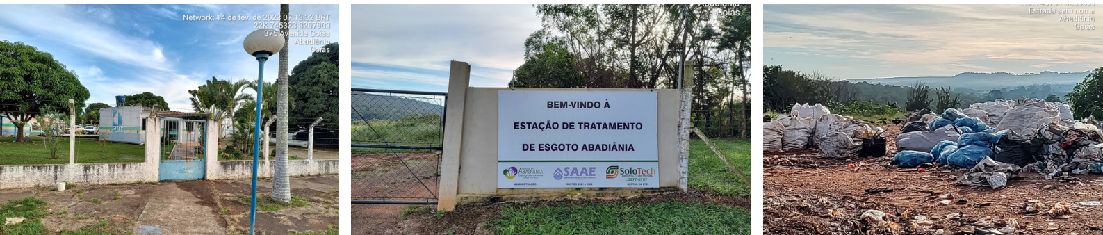
■ Figuras 59-61 - Infraestrutura de saneamento básico (SAAE, ETE e Aterro Controlado)
