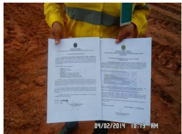
Foto 1-3: Cópia da LI 895 e ASV 721 nas frentes de obra.
