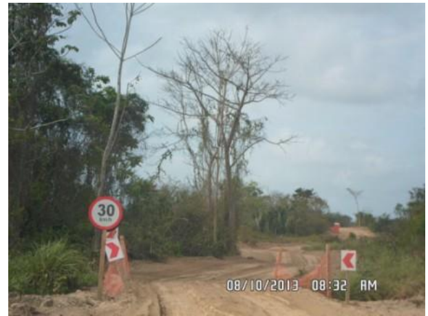
Foto 17-6: Sinalização de velocidade máxima. Locação 07.
