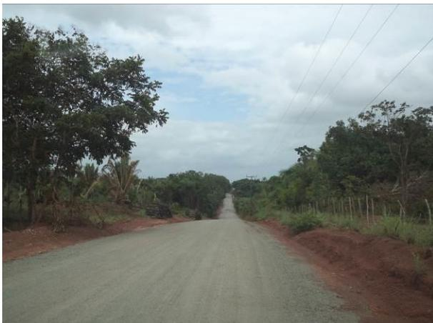
Foto 149: Cobertura da via com pó de brita. Fonte: Amplo, 2014.
