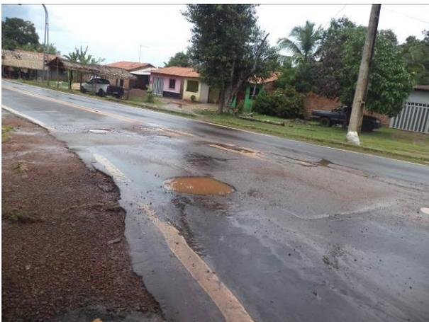
Foto 61: Ausência de acostamento e o surgimento de buracos na Rodovia MA-324, no trecho que perpassa pela comunidade. Fonte: Amplo, 2014.
