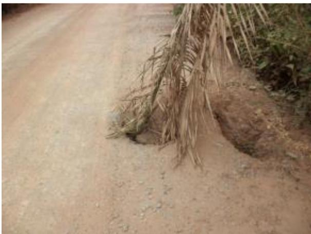
Foto 107: Buraco na via devido à quebra de manilha subterrânea de drenagem de água. Fonte: Amplo, 2013.
