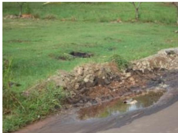
Foto 114: Porção do acesso com a cobertura asfáltica deformada e acúmulo de água (São José dos Matos).
