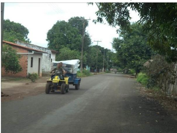
Foto 153: Tráfego de veículos de moradores locais; pavimentação de piçarra com óleo queimado (Campestre). Fonte: Amplo, 2014.
