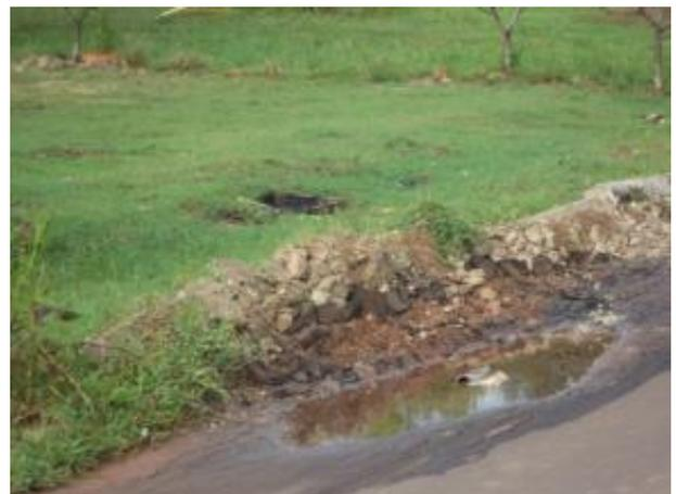
Foto 34: Porção de cobertura asfáltica deformada e com acúmulo de água na via principal. Fonte: Amplo, 2013.
