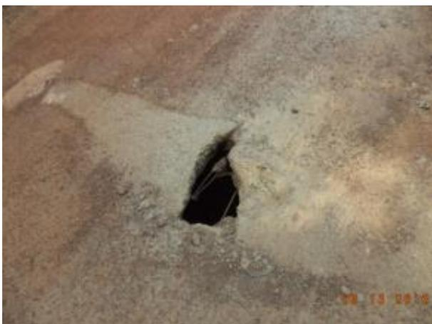
Foto 127: Buraco devido à quebra de manilha de escoamento de água. Fonte: Ampla, 2013.
