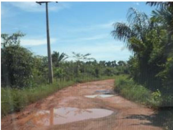
Foto 99: Trecho com buracos e acúmulo de água. Fonte: Amplo, 2013.
