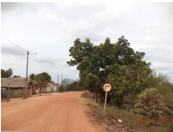
Foto 9: Condição da via e da sinalização; localidade Vila São Raimundo. Fonte: Ampla, 2014.
