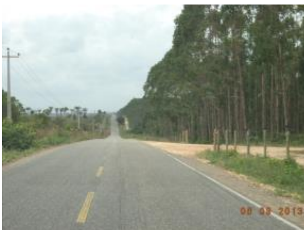
Foto 36: Início do Acesso SP07. Derivação da rodovia MA-125. Fonte: Ampla, 2013.
