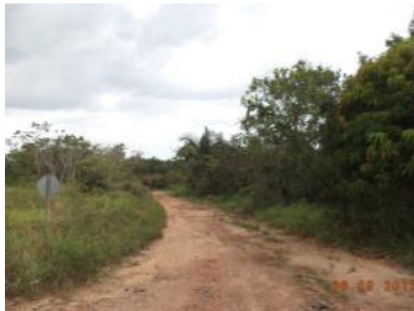
Foto 29: Acesso SP05. Presença de processos erosivos na via. Fonte: Ampla, 2013.
