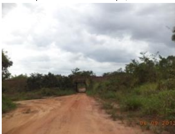
Foto 27: Final do acesso SP04. À esquerda faixa de domínio da EFC. Fonte: Amplo, 2013.
