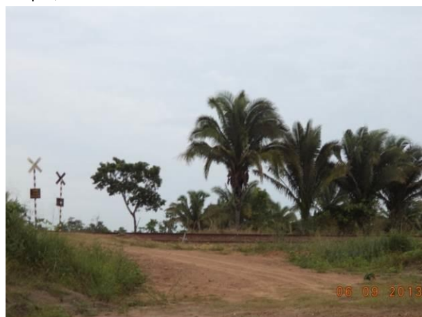
Foto 43: Final do acesso SP07. Encontro com a faixa de domínio da EFC. Ao fundo Passagem em Nível da ferrovia. Fonte: Amplo, 2013.
