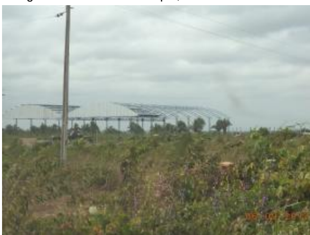
Foto 68: Galpões da indústria de cerâmica, em construção. Fonte: Amplo, 2013.
