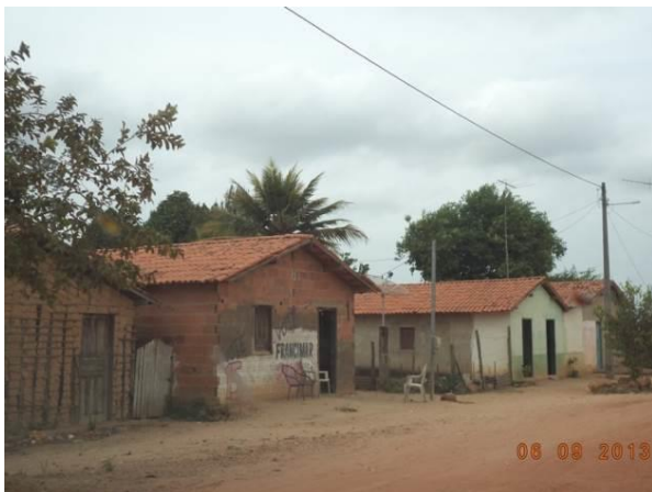
Foto 11: Padrão construtivo das residências da Vila São Raimundo. Fonte: Ampla, 2014.
