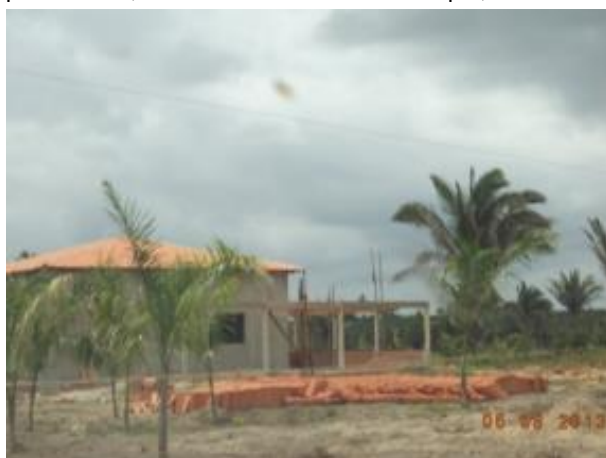
Foto 49: Habitação em construção às margens do acesso. Fonte: Ampla, 2013.
