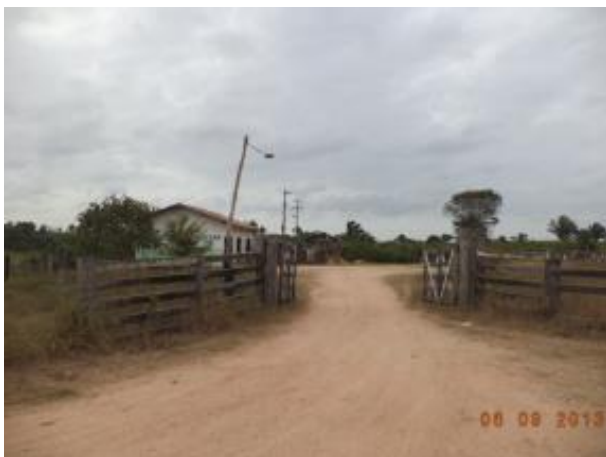
Foto 60: Entrada do matadouro municipal. Fonte: Amplo, 2013.
