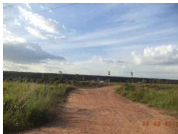
Foto 22: Cobertura de piçarra e terra na via de acesso (ao fundo, Passagem em Nível da EFC). Fonte: Amplo, 2013.
