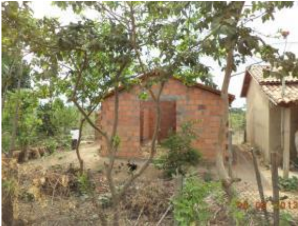
Foto 76: Habitação de alvenaria, em construção. Vila São Raimundo. Fonte: Ampla, 2013.
