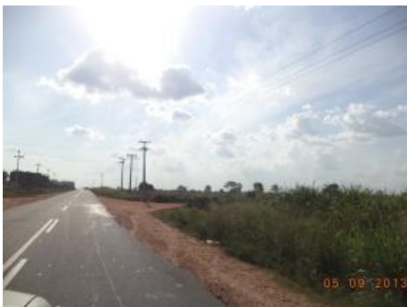
Foto 13: Início do Acesso SP01. Derivação da rodovia MA-125. Fonte: Ampla, 2013.
