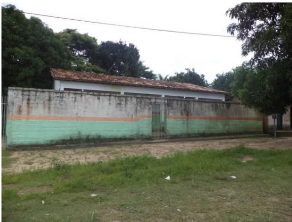
Foto 7: Escola Municipal de Ensino Fundamental São Geraldo; localidade Vila São Raimundo. Fonte: Ampla, 2014.
