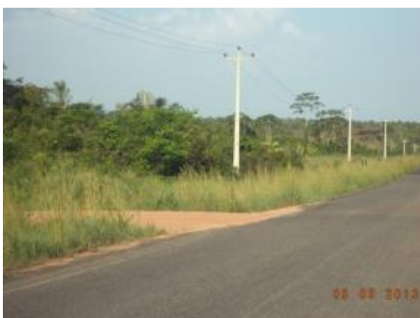
Foto 21: Início do Acesso SP03. Derivação da rodovia MA-125. Fonte: Amplo, 2013.
