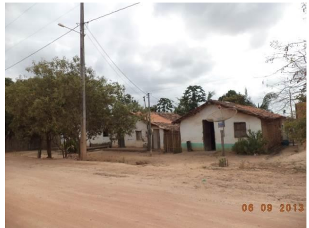
Foto 8: Pavimentação da via e equipamento de iluminação pública; Vila São Raimundo. Fonte: Ampla, 2014.
