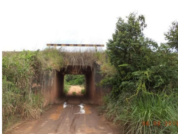
Foto 31: Passagem Inferior de veículo ao final do acesso SP05. Fonte: Ampla, 2013.
