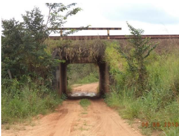
Foto 26: Passagem de veículos ao final do acesso SP04. Fonte: Amplo, 2013.
