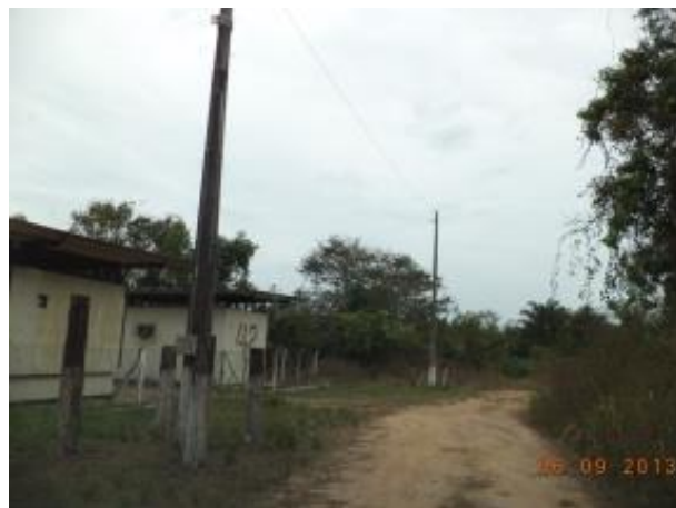
Foto 35: Final do acesso SP06. Faixa de domínio da EFC. Fonte: Ampla, 2013.
