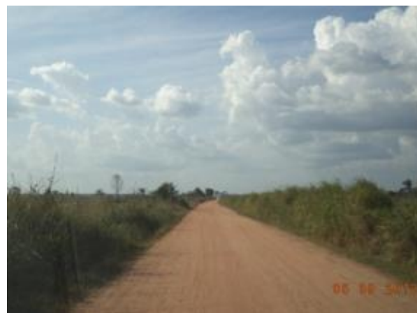
Foto 14: Cobertura da via de terra e piçarra. Entorno com áreas destinadas à pecuária extensiva. Fonte: Ampla, 2013.
