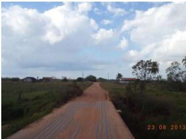
Foto 35: Ponte Estreita sobre curso d'água. Não há guarda corpo e local reservado para transposição por pedestres. Fonte: Amplo, 2013.
