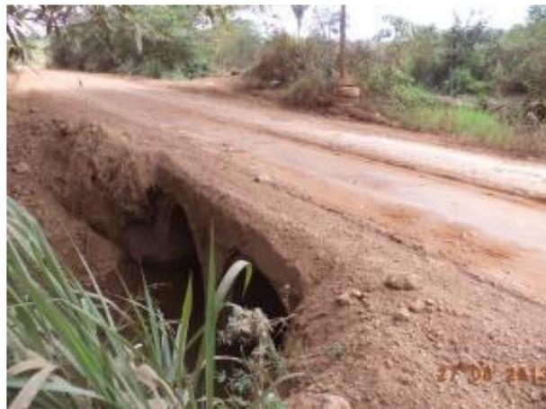
Foto 70: Estreitamento de via, devido à transposição de curso d'água. Nota-se ausência de guarda-corpo, gerando risco de acidentes. Fonte: Amplo, 2013.
