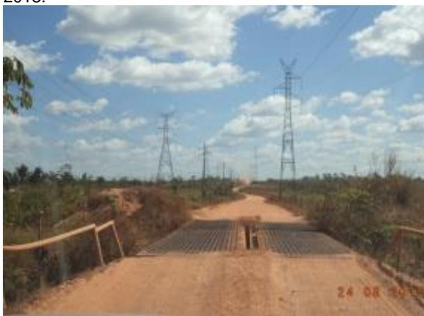
Foto 103: Ponte estreita sobre curso d'água. Perímetro sem guarda-corpo apresentando riscos à segurança dos que trafegam pela via. Fonte: Amplo, 2013.
