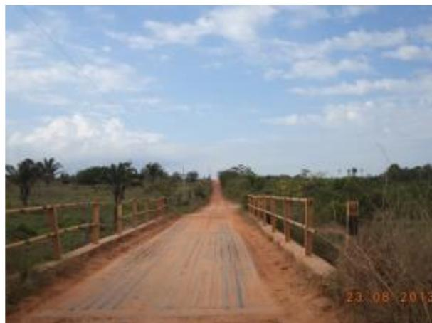
Foto 34: Ponte estreita com guarda-corpo danificado. Não há espaço para transposição segura de pedestres. Fonte: Amplo, 2013.
