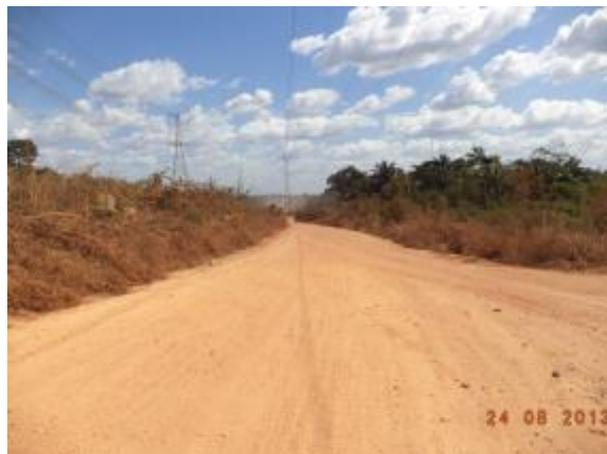
Foto 100: Acesso MB12. Cobertura da via de terra e piçarra. A via apresenta elevado potencial para suspensão de material particulado. Fonte: Amplo, 2013.
