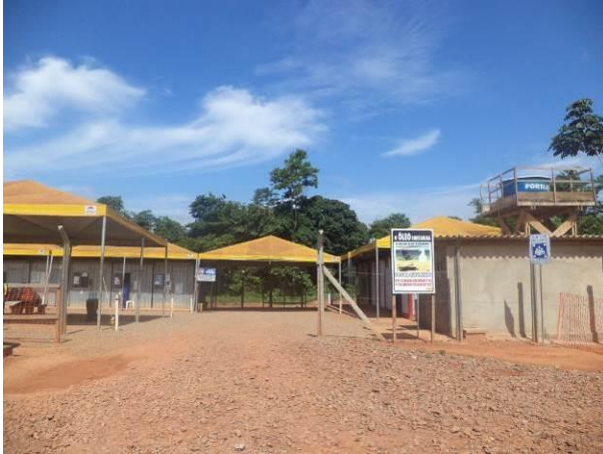
Foto 53: Canteiro de Obras Avançado situado no Acesso Viário AC01C. Fonte: Amplo, 2013.
