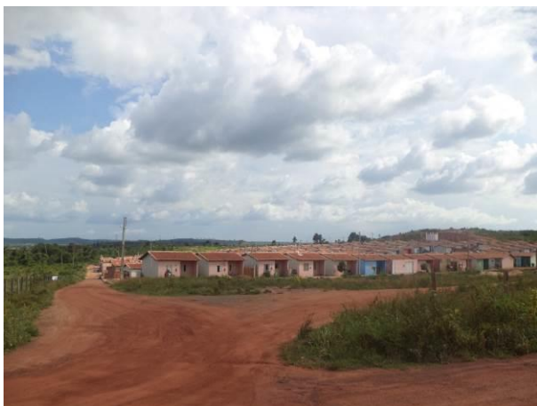
Foto 25: Residencial Vila Juscelino (Projeto Minha Casa Minha Vida), em Açailândia/MA. Fonte: Amplo, 2014.
