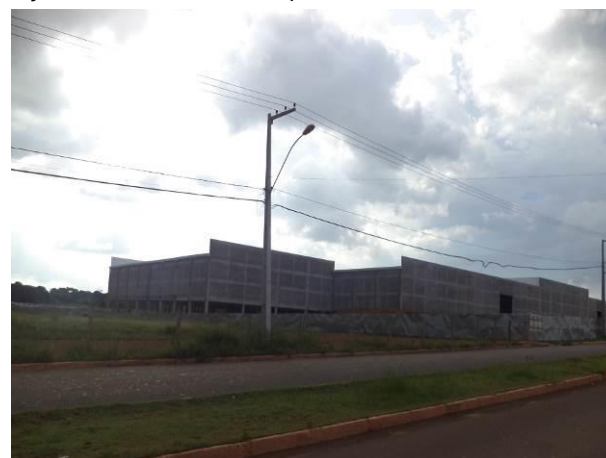
Foto 76: Construção do Shopping Center às margens do Acesso Viário AC04B, em Açailândia/MA. Fonte: Ampla, 2014.
