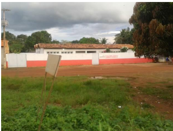
Foto 3: Unidade de Ensino da Vila Reta (Escola Municipal Leônidas Clemente de Mores), em Açailândia/MA. Fonte: Amplo, 2014.
