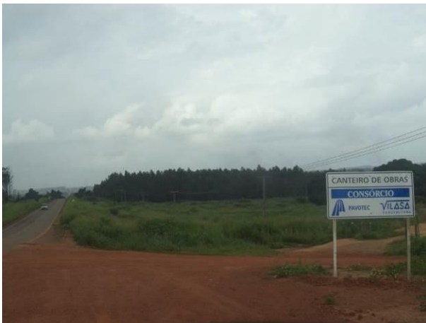
Foto 55: Início do Acesso Viário AC02, às margens da BR 222, em Açailândia/MA. Fonte: Amplo, 2014.
