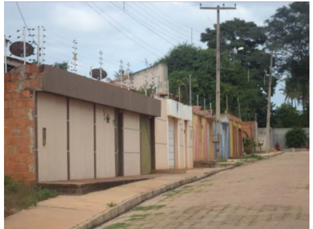
Foto 14: Padrão construtivo das residências na localidade Residencial Tropical, em Açailândia/MA. Fonte: Ampla, 2014.
