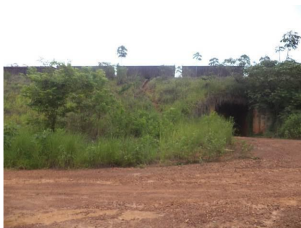
Foto 84: Trecho final da via de acesso, em Açailândia/MA. Fonte: Ampla, 2014.
