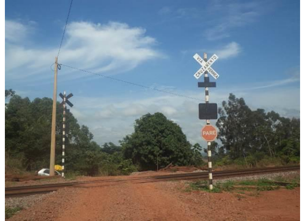
Foto 54: Passagem de Nível existente no trecho final do Acesso AC01C, em Açailândia/MA. Fonte: Amplo, 2014.
