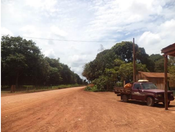
Foto 11: Condições da pavimentação da localidade Seringal, em Açailândia/MA. Fonte: Ampla, 2014.
