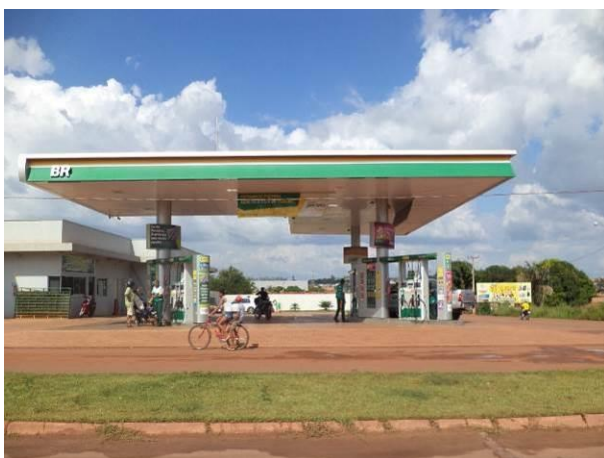
Foto 75: Posto de combustível situado às margens do Acesso AC04B, em Açailândia/MA. Fonte: Ampla, 2014.
