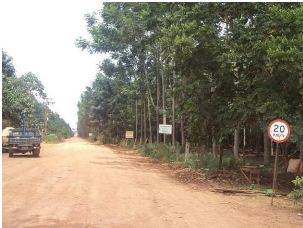
Foto 37: Sinalização existente no Acesso Viário AC01A, em Açailândia/MA. Fonte: Ampla, 2014.
