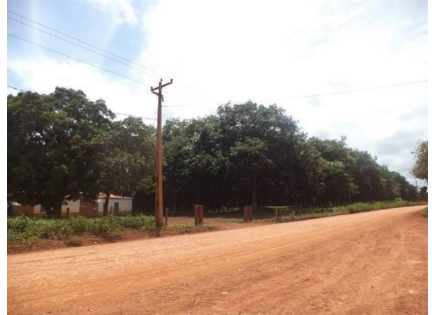
Foto 12: Distribuição de energia elétrica na localidade Vila Seringal, em Açailândia/MA. Fonte: Ampla, 2014.
