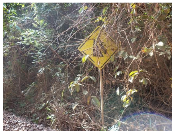
Foto 50: Sinalização coberta pela vegetação no Acesso AC01C, em Açailândia/MA. Fonte: Amplo, 2014.
