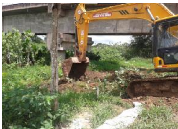
Foto 7-44: Área alagada realizando-se supressão com maquinário retroescavadeira hidráulica. Locação 11, Vitória Mearim/MA.
