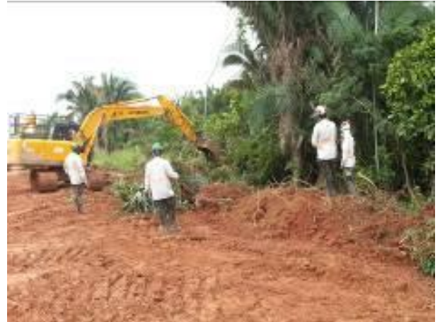
Foto 7-108: Equipe do Programa de Afugentamento e Salvamento de Fauna acompanhando atividade de supressão vegetal. Locação 43, São Pedro da Água Branca/MA.
