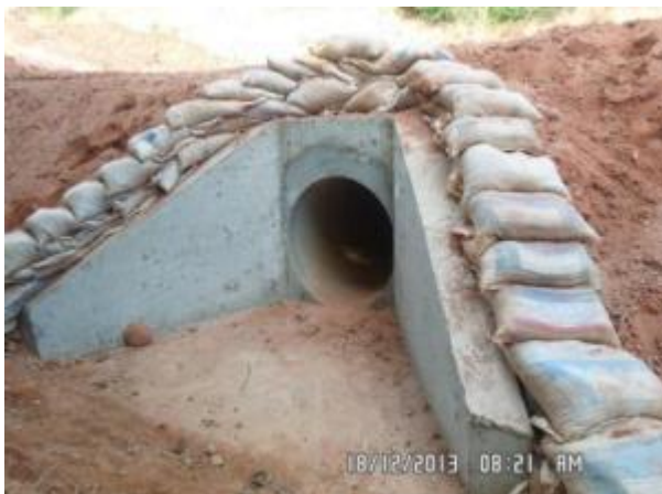
Foto 2-39: Utilização de rip rap servindo de contenção temporária e pontual (Locação 36).
