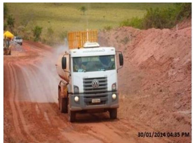
Foto 2-70: Umectação das frentes de obra (Locação 36).
