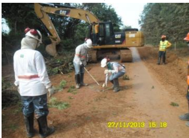
Foto 2-3: Acompanhamento da equipe de afugentamento e resgate de fauna durante supressão (Locação 30-31).
