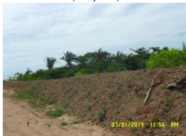
Foto 2-26: Armazenamento temporário de topsoil em leiras para posterior reutilização em recuperação de áreas (Locação 0-2).
