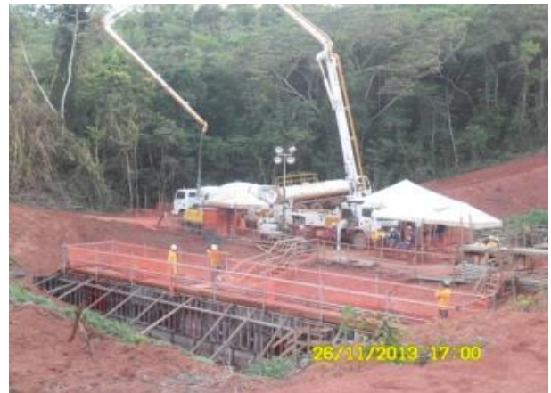
Foto 2-10: Atividade de concretagem de bueiro (Locação 30-31).
