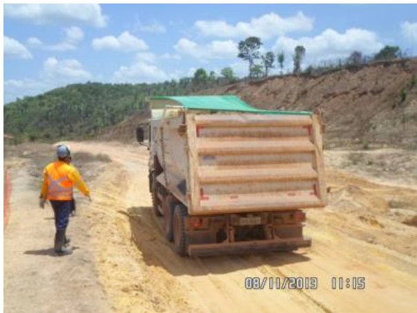
Foto 2-71: Enlombamento/cobertura das cargas de solo necessárias à terraplanagem (Locação 20).
