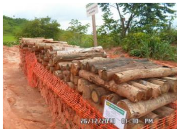
Foto 2-4: Material resultante de supressão romaneada, armazenada em área específica e identificada (Locação 36-37).
