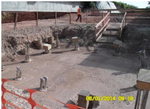
Foto 2-13: Encontro 02 da Ponte Ferroviária. Bacia 814/815 (Locação 13-14).
