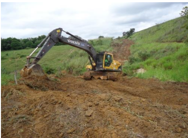
Foto 2-57: Limpeza de sub-bosque; remoção do topsoil para posterior armazenamento (Locação 53).
