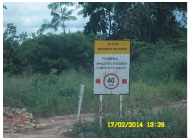
Foto 2-74: Sinalização de velocidade ao tráfego da obra (Locação 53).
