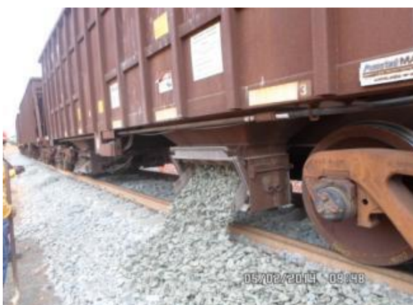
Foto 2-17: Descarga de brita de lastro (Locação 36).
