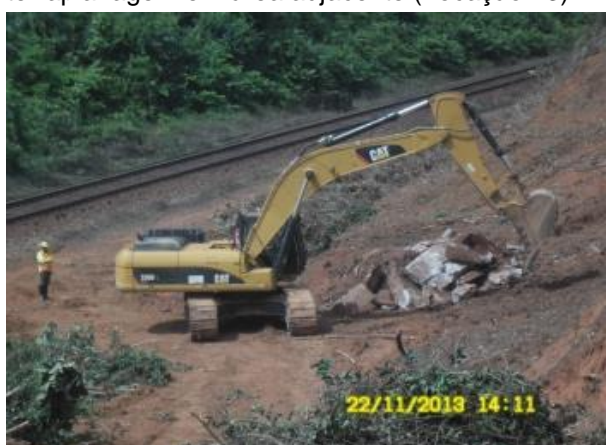
Foto 2-27: Recolhimento de entulho gerado pela atividade de demolição das alas de bueiro a ser prolongado (Locação 30).
