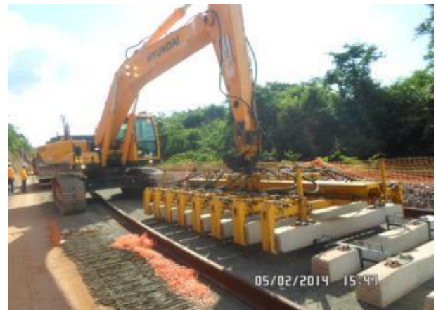
Foto 2-16: Montagem da grade ferroviária com colocação dos dormentes de concreto (Locação 36).
