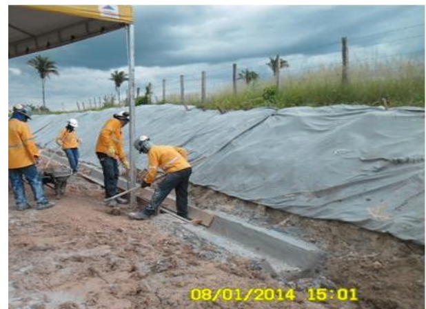
Foto 2-40: Instalação de sistema de drenagem nos canteiros avançados; colocação de manta geotêxtil para evitar carreamento de solo (Locação 13).
