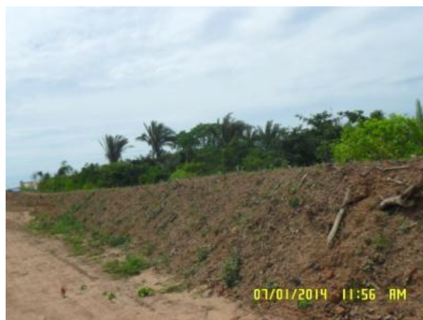
Foto 2-66: Topsoil armazenado em leiras de 1,5m de altura (Locação 0-2).
