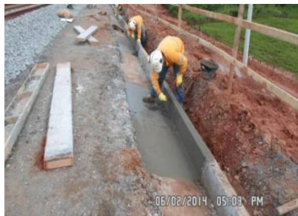
Foto 2-20: Construção da sarjeta para drenagem superficial (Locação 36-37).
