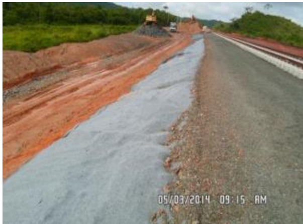
Foto 2-45: Atividade de instalação de manta geotêxtil em área adjacente em relação ao eixo ferroviário em duplicação (Locação 36).
