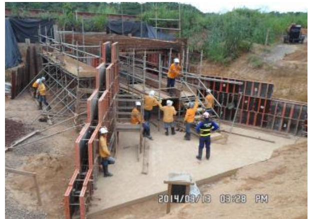
Foto 2-8: Armação da ala de bueiro simples celular (Locação 25-26).
