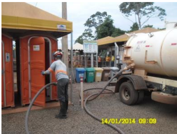
Foto 2-33: Atividade de recolhimento do lodo sanitário na fonte geradora (Locação 30).
