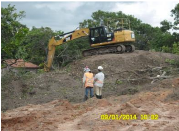
Foto 2-55: Acompanhamento da supressão pela equipe de afugentamento e resgate de fauna (Locação 0-2).
