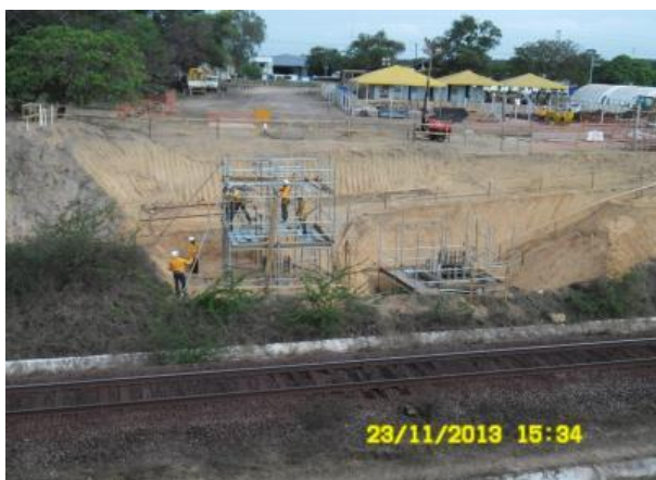
Foto 2-11: Montagem da fôrma de base esquerda do Viaduto Rodoviário (Locação 0-2).
