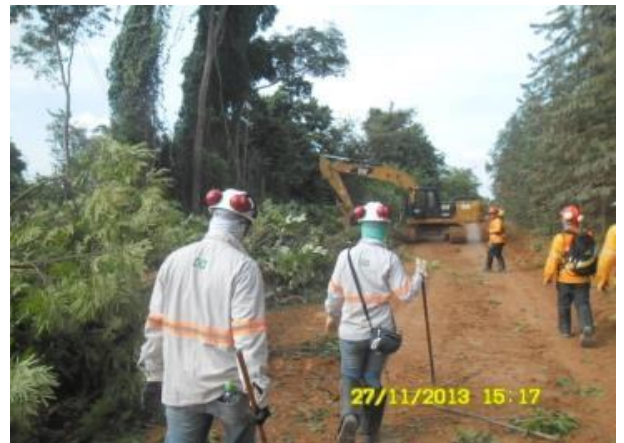
Foto 2-56: Acompanhamento da supressão pela equipe de afugentamento e resgate de fauna (Locação 30).
