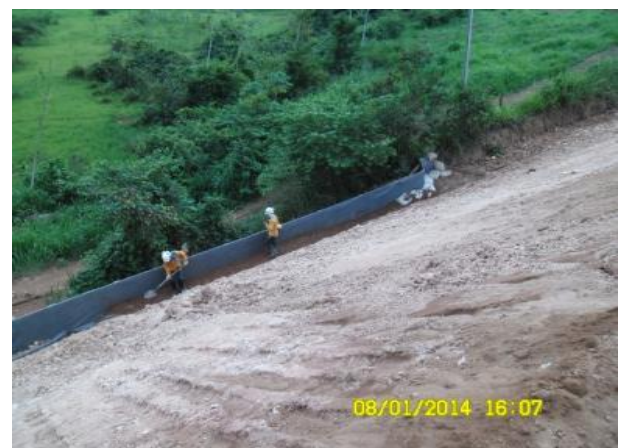
Foto 2-42: Instalação de barreira de contenção e manta geotêxtil para o controle de carreamento de solo (Locação 53).
