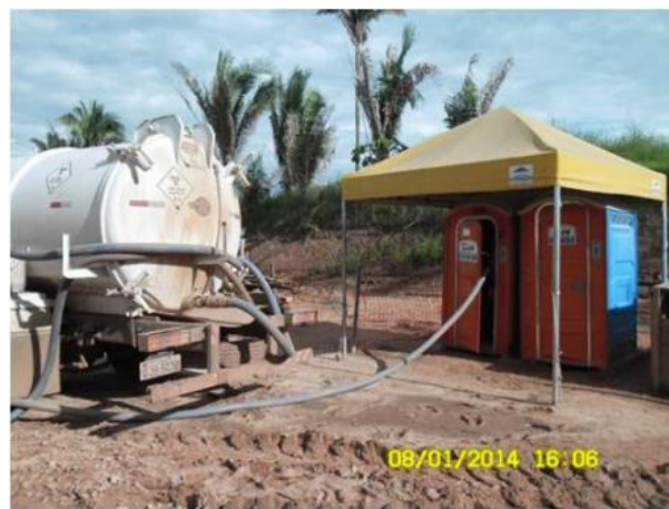
Foto 2-34: Atividade de recolhimento do lodo sanitário na fonte geradora por meio de caminhão a vácuo (Locação 13).
