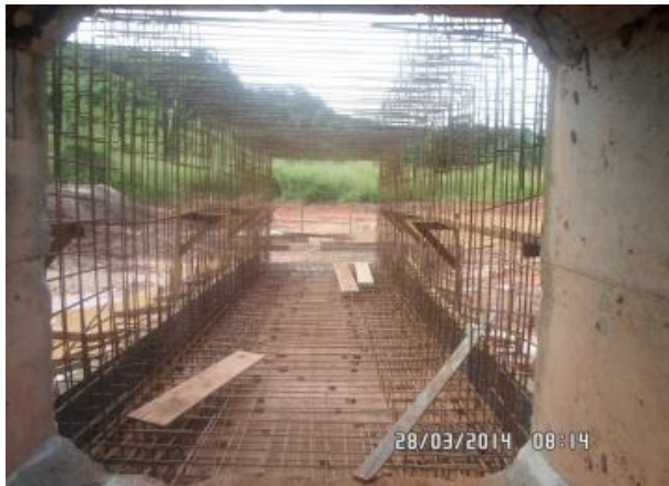
Foto 2-7: Armação de bueiro simples celular prolongado (Locação 25-26).
