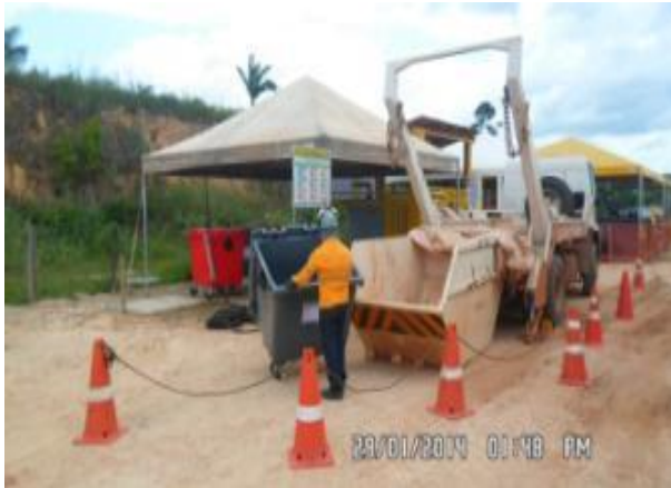
Foto 2-29: Atividade de coleta para o transporte externo via caminhão poliguindaste (Locação 20).
