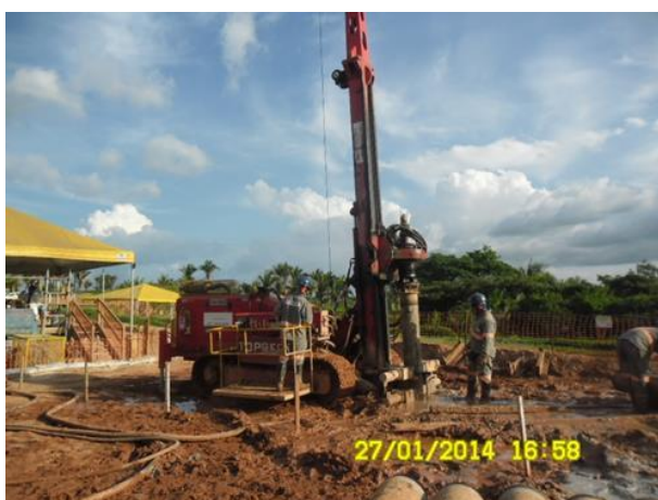
Foto 2-37: Atividade de perfuração de estaca raiz com auxílio de água como fluido (Locação 14).
