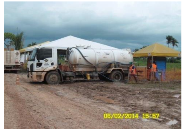
Foto 2-32: Modelo de caminhão a vácuo que realiza coletas em cada fonte geradora ao longo da obra, responsável pelo transporte externo até destinação final (Locação 13).
