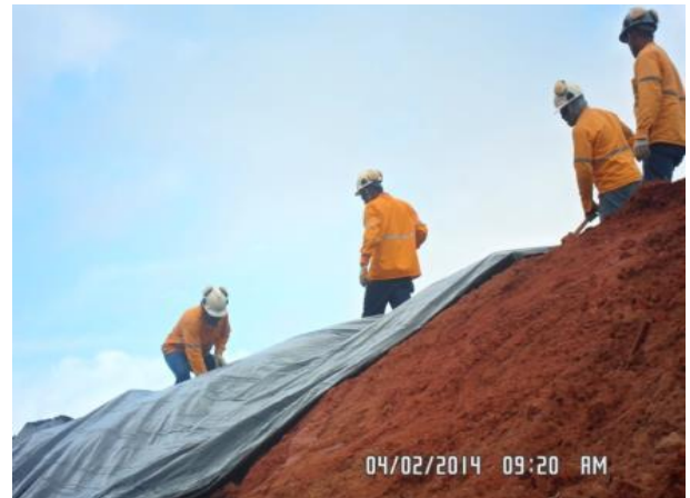
Foto 2-44: Cobrimento de solo exposto do talude em formação através de manta geotêxtil (Locação 36).
