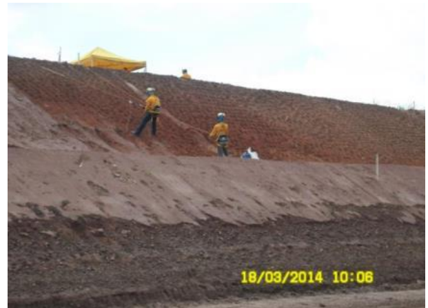
Foto 2-46: Equipe de campo realizando covas no talude a ser posteriormente revegetado através do processo de hidrossemeadura (Locação 0-2).
