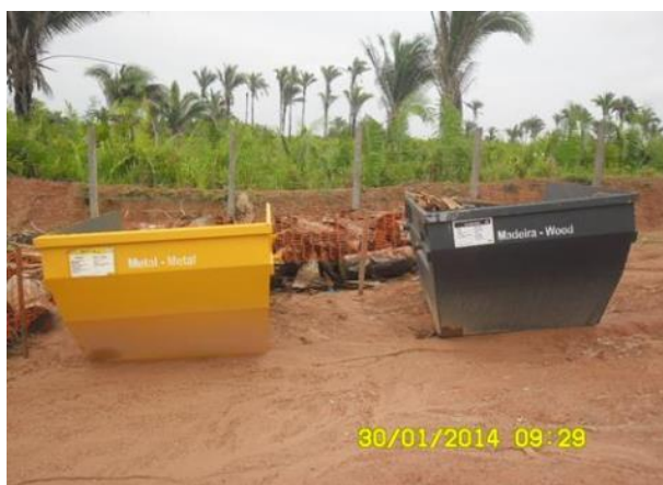
Foto 2-23: Caçambas coletoras identificadas utilizadas nas frentes de obra ao posterior recolhimento por meio de caminhão poliguidaste (Locação 14).
