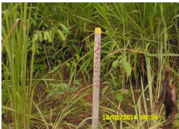
Foto 2-1: Execução de demarcações físicas para posterior atividade de supressão vegetal (Locação 43-44).
