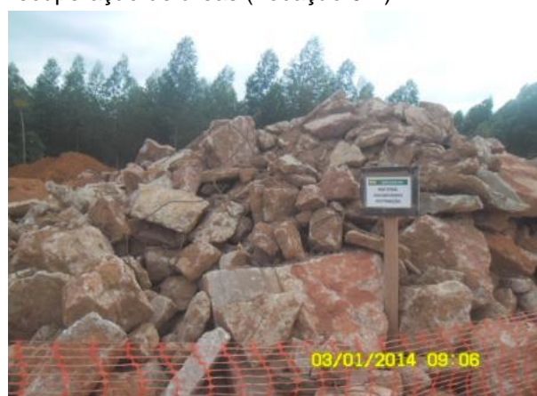
Foto 2-28: Armazenamento segregado temporário de entulho para posterior reutilização na obra (Resolução CONAMA 307/2002); (Locação 30).
