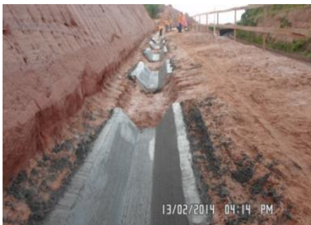
Foto 2-19: Construção de placas a compor a sarjeta para drenagem superficial (Locação 36-37).
