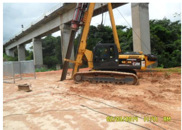
Foto 2-12: Atividade de cravamento de estaca da Ponte Ferroviária Igarapé Presa de Porco (Locação 20-21).
