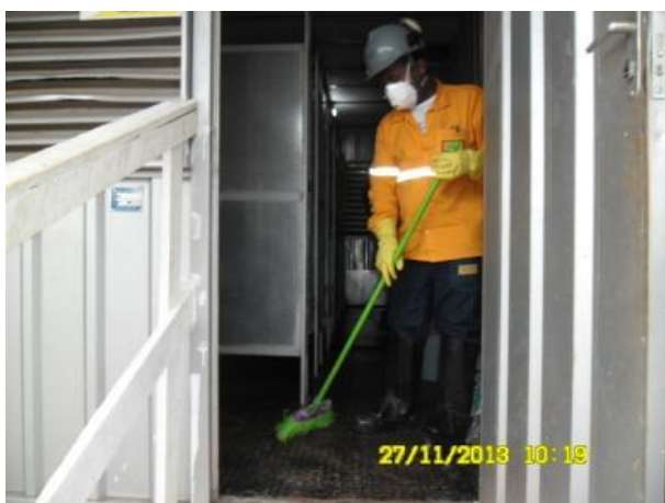
Foto 2-35: Higienização periódica nos sanitários instalados nas frentes de obra (Locação 53).
