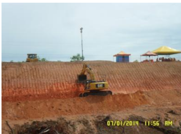
Foto 2-41: Escavadeira realizando atendimento geotécnico quanto à inclinação ao talude de corte (Locação 0-2).
