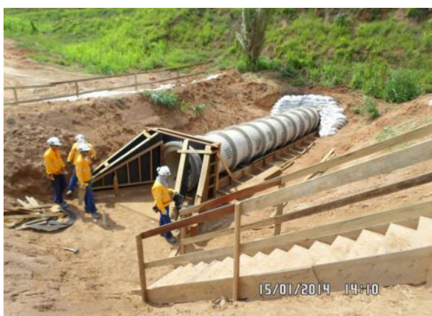
Foto 2-5: Execução de fôrma do berço da ala de bueiro tubular simples prolongado (Locação 20-21).
