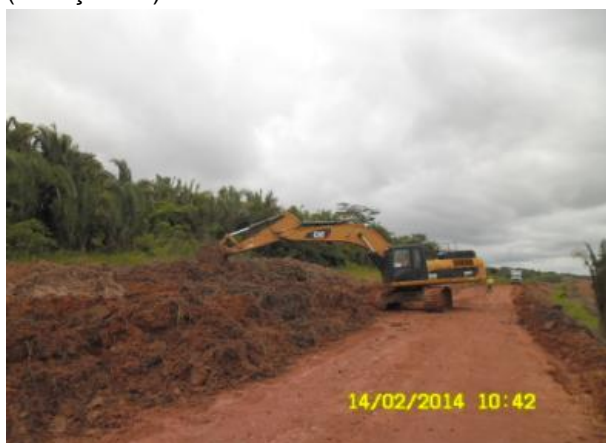
Foto 2-25: Escavadeira realizando formação de leiras com o topsoil gerado pela atividade de terraplanagem em área adjacente (Locação 43).
