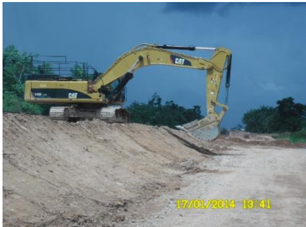
Foto 2-43: Escavadeira auxiliando na tarefa de reconformação e compactação de talude, em atendimento às premissas da engenharia (Locação 53).
