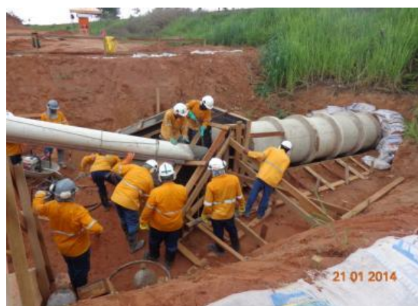
Foto 2-6: Concretagem de berço da ala de bueiro tubular simples prolongado (Locação 20-21).
