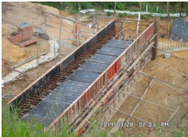
Foto 2-9: Escoramento das paredes de bueiro simples celular prolongado (Locação 25-26).
