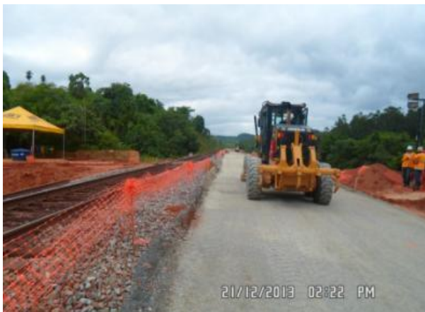
Foto 2-15: Nivelamento do sublastro (Locação 36-37).
