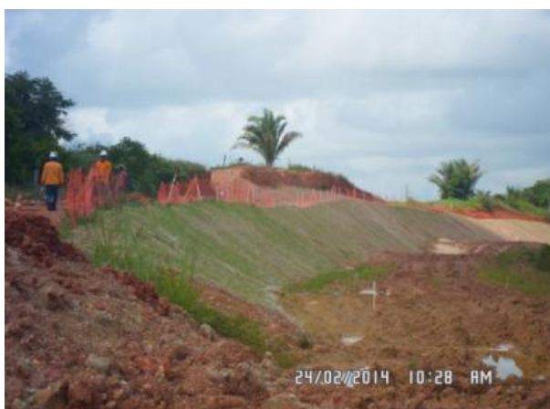
Foto 2-47: Revegetação em evolução após aplicação de hidrossemeadura (Locação 48).
