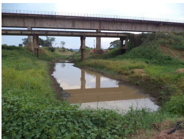
Foto 29: Montante da ponte 11 em outubro de 2013.
