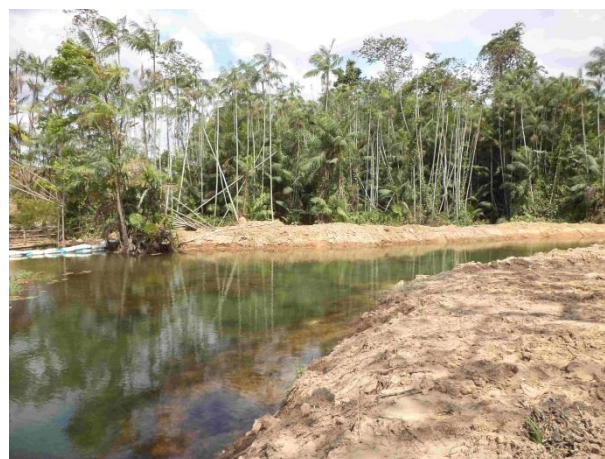
Foto 69: Jusante da travessia 164, em outubro de 2013.
