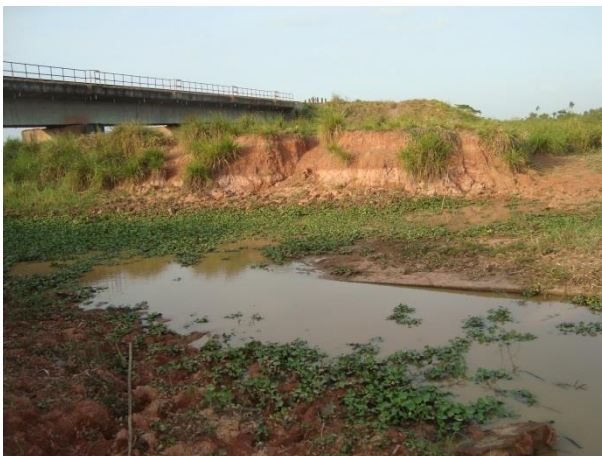
Foto 7: Montante da ponte 04 em outubro de 2013.
