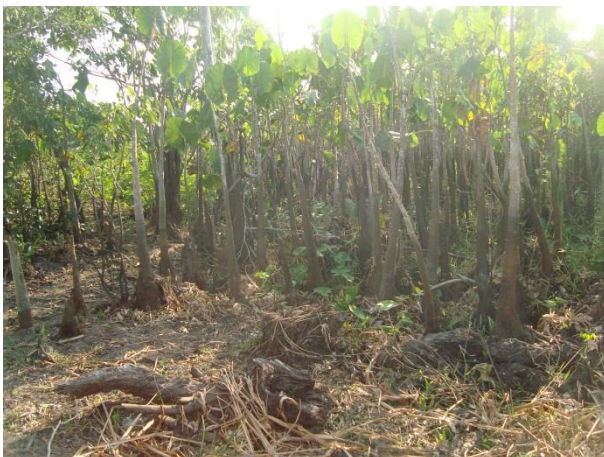
Foto 22: Montante da ponte 09 em outubro de 2013.
