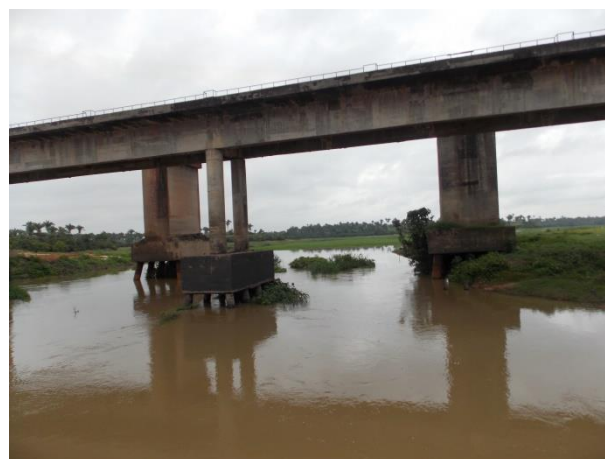
Foto 130: Rio Zutúia – Jusante
