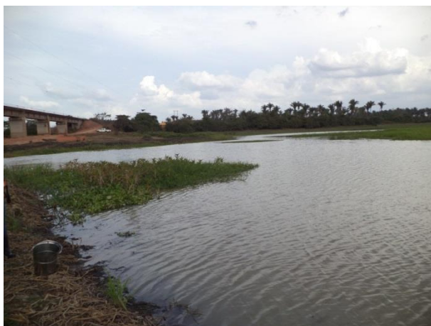
Foto 31: Montante da ponte 12 em outubro de 2013.
