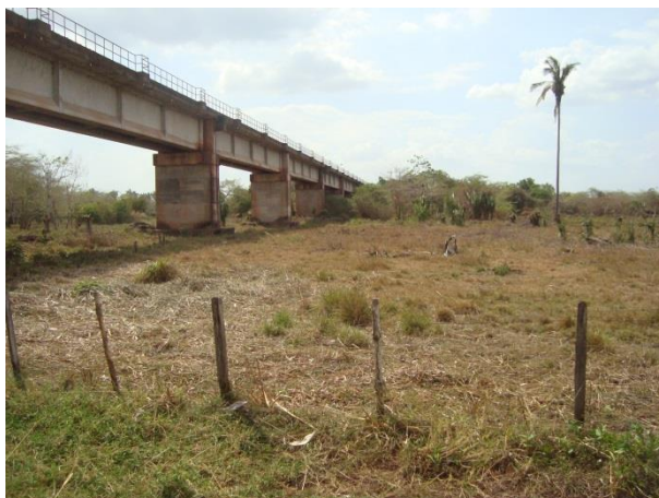
Foto 20: Montante da ponte 08 em outubro de 2013.
