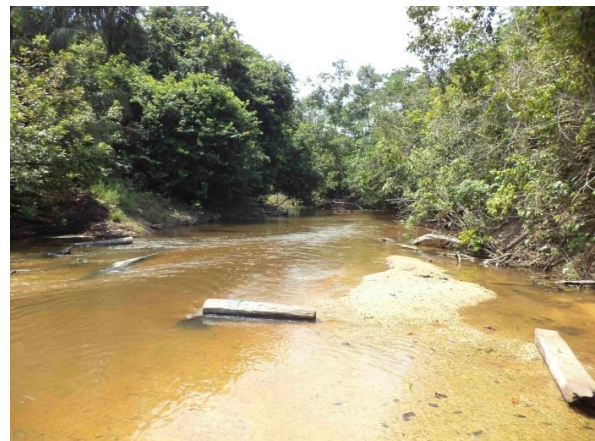
Foto 95: Jusante da ponte 37 em outubro de 2013.
