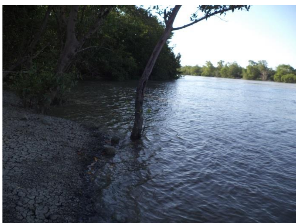
Foto 1: Montante da ponte 01 em outubro de 2013.
