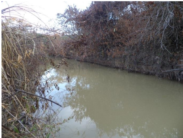
Foto 59: Montante da ponte 23 em outubro de 2013.
