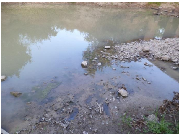
Foto 40: Montante da ponte 15 em outubro de 2013.
