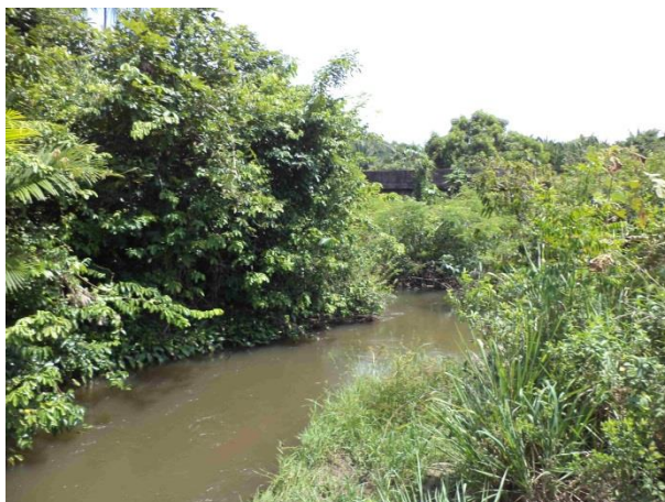
Foto 84: Montante da ponte 31 em outubro de 2013.
