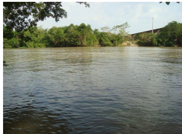
Foto 17: Jusante da ponte 07 em outubro de 2013.
