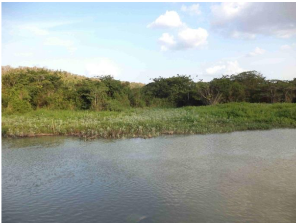
Foto 72: Montante da Ponte 27 em outubro de 2013.
