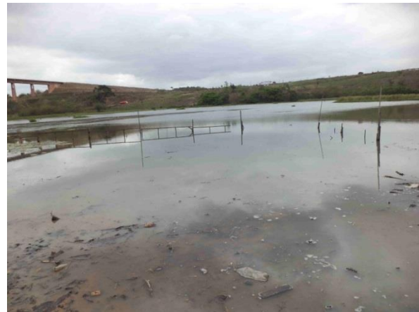
Foto 77: Jusante da travessia 191 em out./2013. Foto: Amplo
