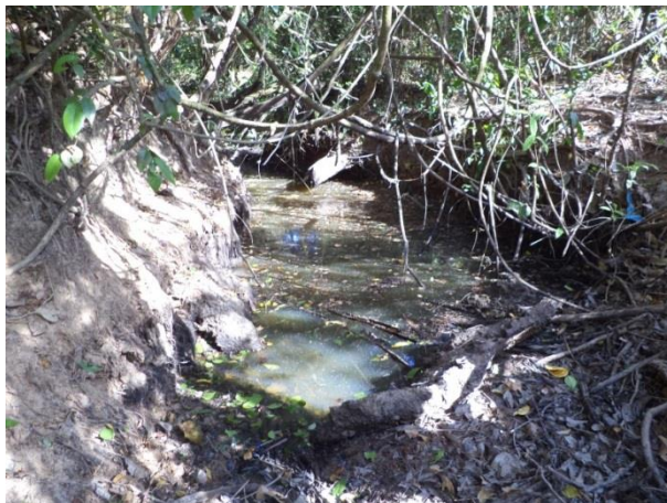
Foto 3: Montante da ponte 02 em outubro de 2013.
