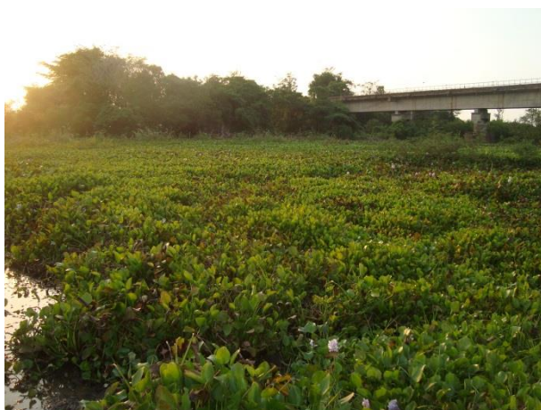
Foto 12: Montante da ponte 06 em outubro de 2013. Foto: Amplo
