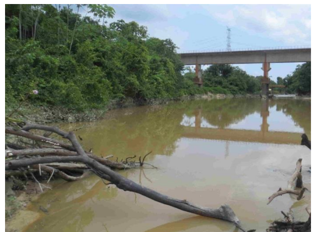
Foto 99: Jusante da ponte 38 em outubro de 2013.
