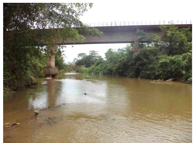
Foto 107: Jusante da ponte 42 em outubro de 2013.
