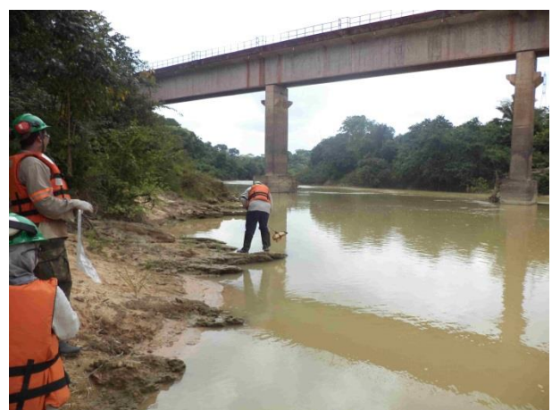
Foto 101: Jusante da ponte 39 em outubro de 2013.
