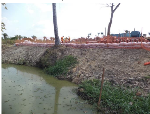
Foto 28: Detalhe das obras a montante da ponte 10.
