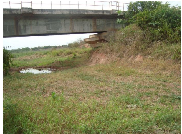
Foto 11: Jusante da ponte 05 em outubro de 2013.
