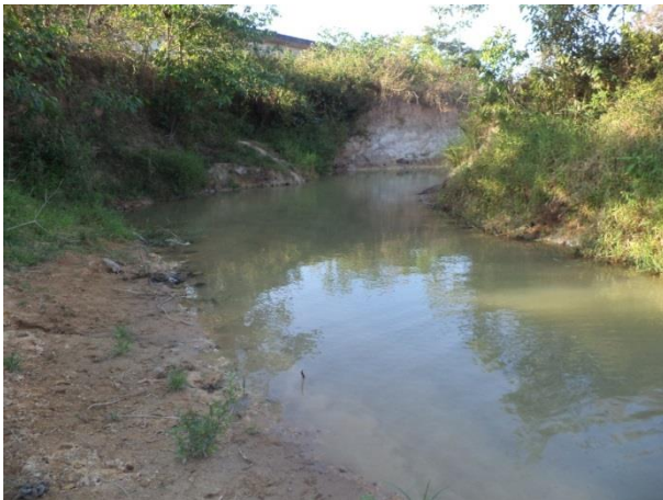
Foto 55: Montante da Ponte 21 em outubro de 2013.
