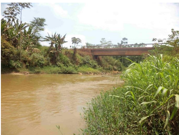
Foto 106: Montante da ponte 42 em outubro de 2013.
