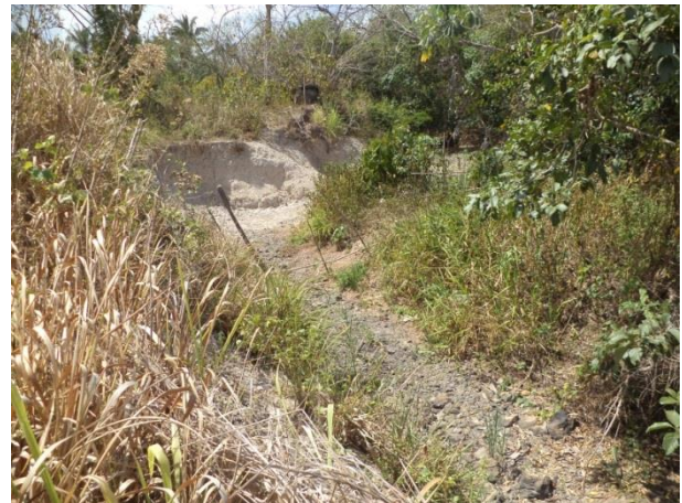
Foto 52: Montante da Ponte 19 em outubro de 2013.
