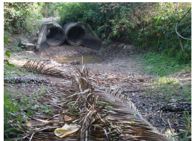
Foto 6: Jusante da ponte 03 em outubro de 2013.
