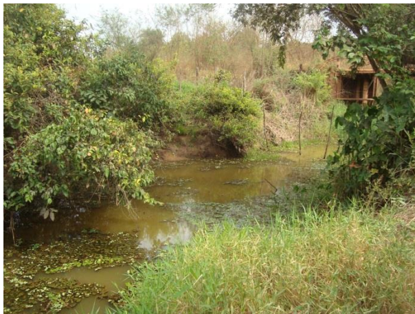
Foto 33: Montante da ponte 13 em outubro de 2013.
