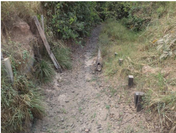
Foto 51: Montante da ponte 19 em outubro de 2013.
