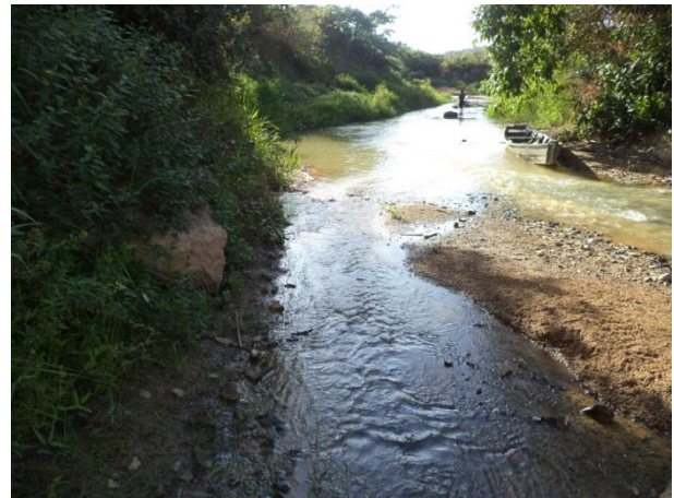
Foto 56: Jusante da Ponte 21 em outubro de 2013.
