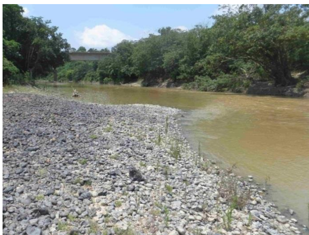
Foto 98: Montante da ponte 38 em outubro de 2013.
