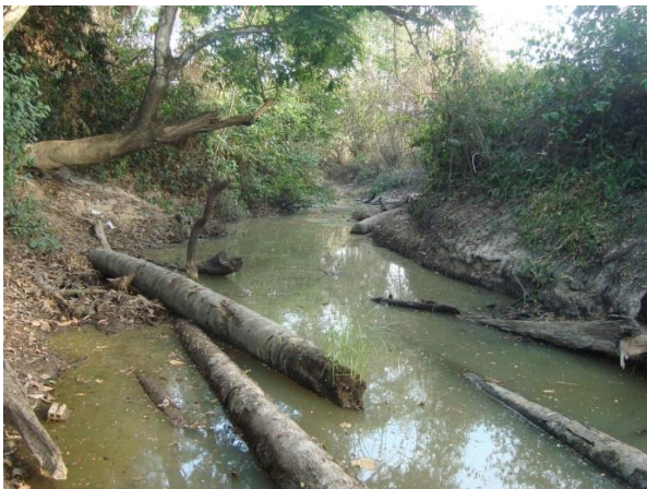
Foto 44: Montante da ponte 17 em outubro de 2013.
