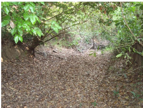
Foto 5: Montante da ponte 03 em outubro de 2013.
