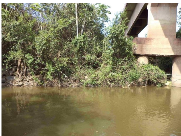
Foto 90: Montante da ponte 34 em outubro de 2013.
