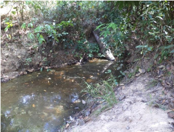
Foto 53: Montante da Ponte 20 em outubro de 2013.
