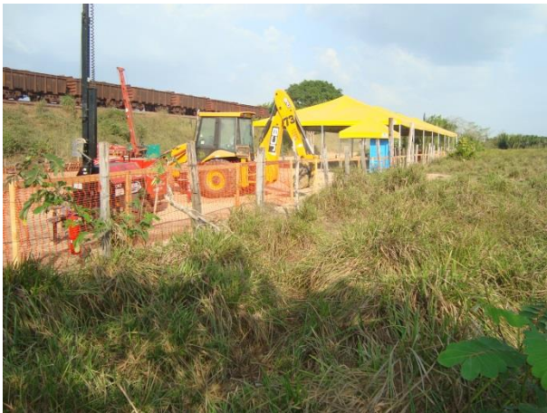
Foto 24: Detalhe dos equipamentos de obras.
