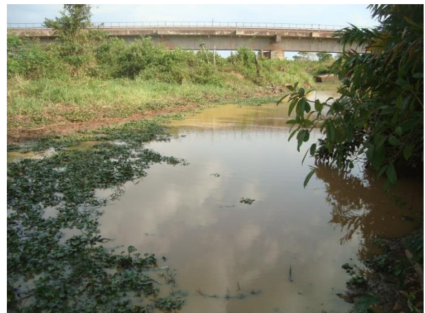
Foto 8: Jusante da ponte 04 em outubro de 2013.
