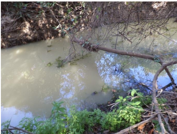
Foto 42: Montante da ponte 16 em outubro de 2013.
