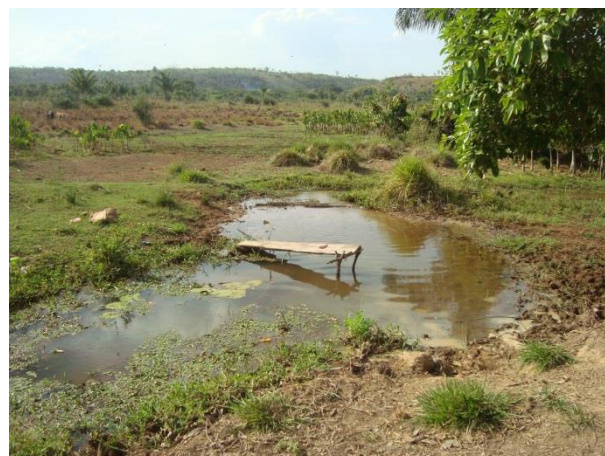
Foto 62: Jusante da Ponte 24 em abril de 2013.
