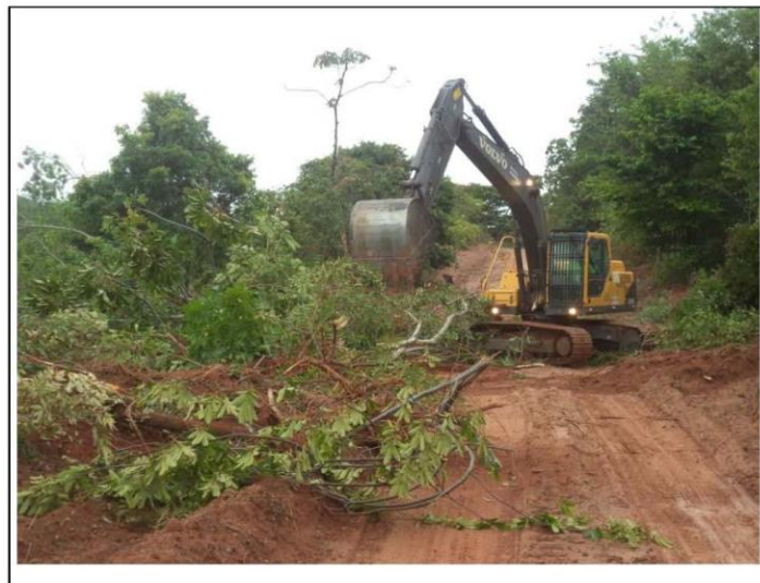
Foto: 5-7 Escavadeira realizando limpeza de sub-bosque entre as localidades 36-37.
