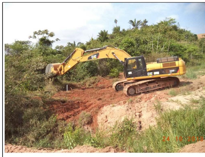
Foto: 5-5 Escavadeira realizando limpeza de sub-bosque entre as locações 36-37.
