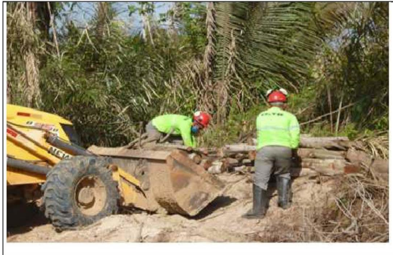
Foto: 5-9 Enleiramento de material na faixa de domínio VALE.
