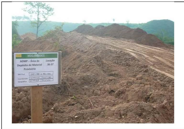
Foto: 5-22 ADMP (Área Depósito de Material Provisório) com identificação.
