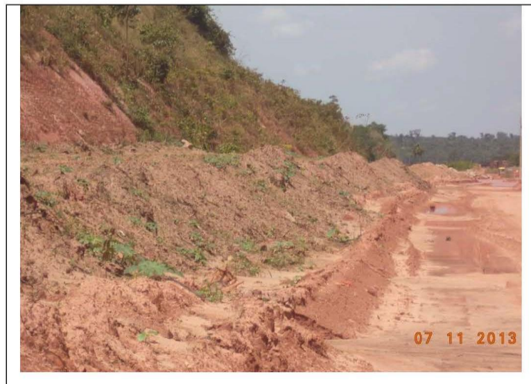
Foto: 5-10 Enleiramento de material na faixa de domínio VALE.
