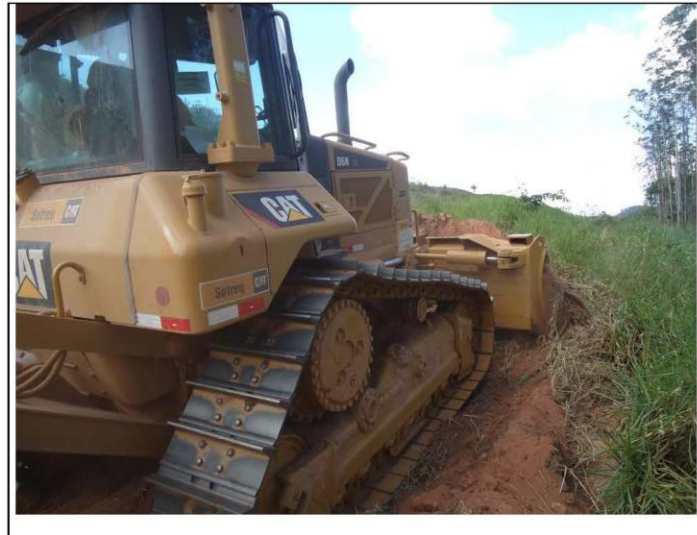
Foto: 5-6 Remoção de gramíneas com auxílio de trator D6 na Loc. 36-37.
